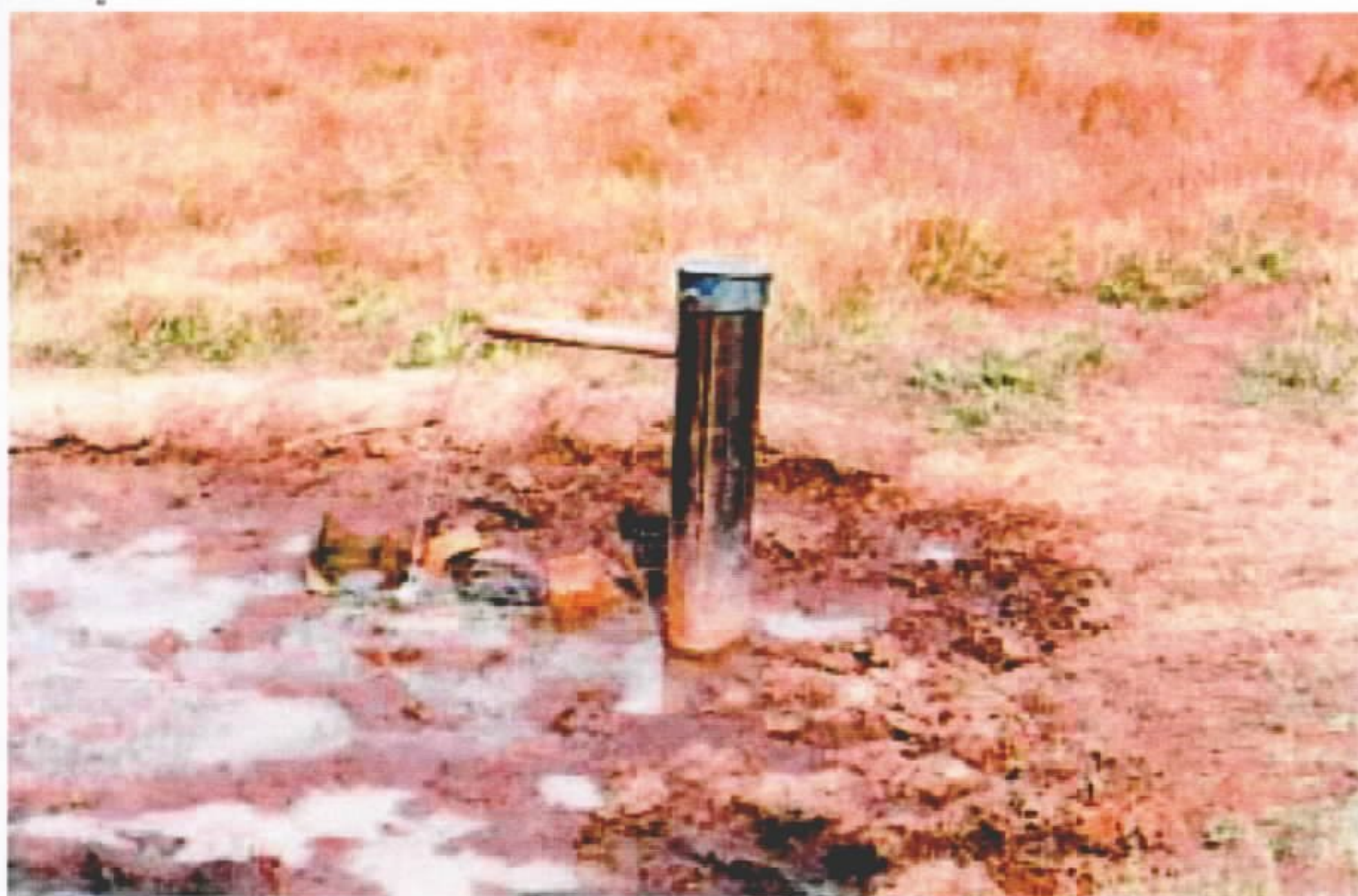
Foto 6 - Poço artesiano sem laje de proteção sanitária, servindo de bebedouro para o gado, com alto risco de contaminação. Fazenda Tapera. UTM: 417023E8249040N.
