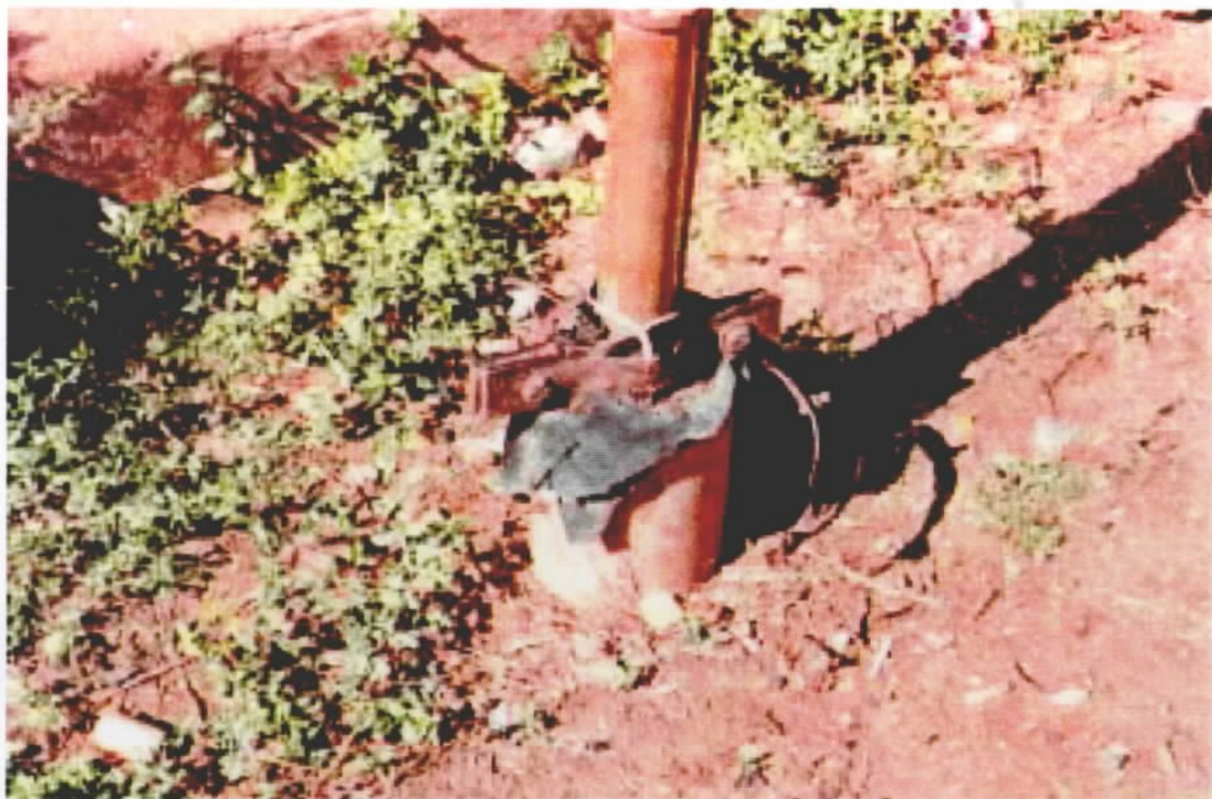
Foto 8 - Poço tubular com risco alto de contaminação em consequência da improvisação da tampa da saliência.
