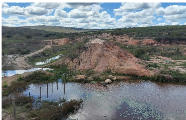
Figura 16 – Imagem da Barragem Vida Nova exibindo a área rompida no desastre de 2021. Fonte: Anselmo Pedrazzi.
