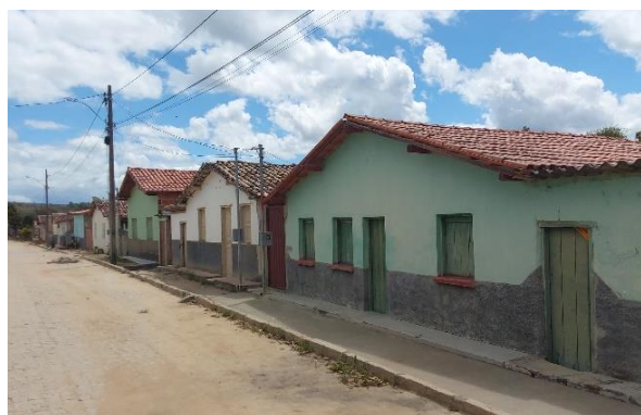
Figura 5 – Imagem da rua Santos Dumont, onde estão localizados a maior parte dos imóveis da Área 1. Fonte: Anselmo Pedrazzi.
