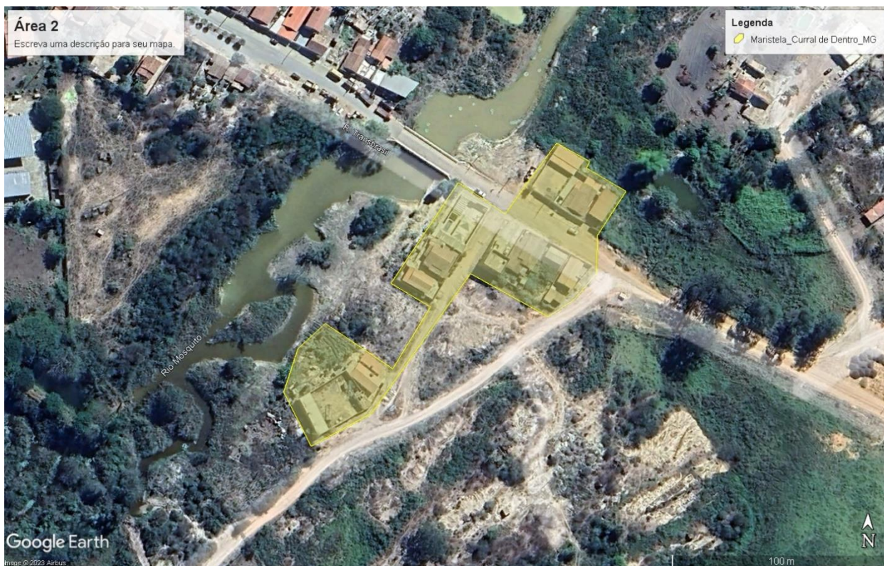
Figura 11 - Imagem da Área 2 (em amarelo), indicando a distribuição dos imóveis atingidos pelo desastre de dezembro de 2021, classificados como risco médio. Fonte: GoogleEarth.
