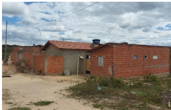
Figura 15 – Imagem exibindo imóveis construídos com variados padrões construtivos, os deixando com variados graus de vulnerabilidade. Fonte: Anselmo Pedrazzi.
