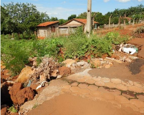
Figura 8 – Processo erosivo avançando para via no PM-05.
