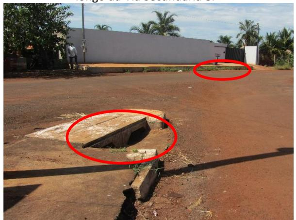
Figura 13– Local atingido por enxurrada pluvial, Detalhe para o sistema de drenagem instalado após evento.
