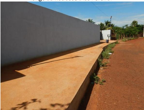
Figura 12– Local atingido por enxurrada pluvial, com alteamento de calçada e bueiros feitos pela prefeitura local após evento.
