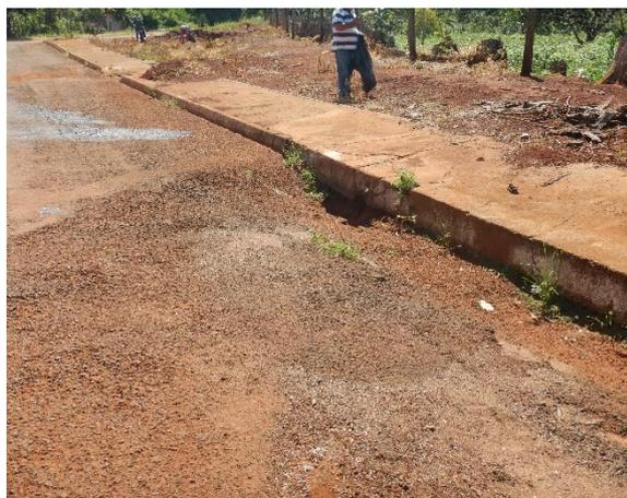
Figura 4 – Ponto de rebaixamento de via. Cabeceira de processo erosivo no PM-01.
