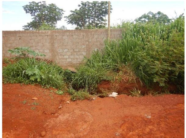
Figura 11– Processo de ravinamento no PM-08, ao longo da Via Secundária 8.
