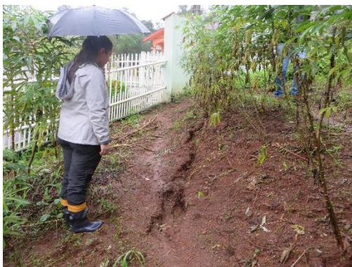
Figura 6 – Rachaduras no solo ao lado de moradia na rua Bento Gonçalves.
