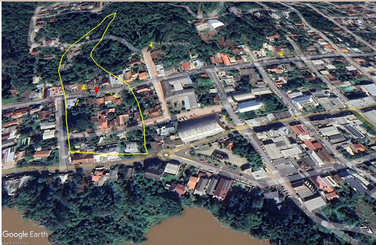
Figura 3 – Setor de Risco RS_CS_SR_09_CPRM delimitado em 2013 (linha em amarelo), tipologia rastejo e reativado em 2019 e novamente em 2024: trincas e rachaduras no asfalto (linha tracejada em amarelo) e em algumas moradias em destaque na figura. Imagem Google Earth.
