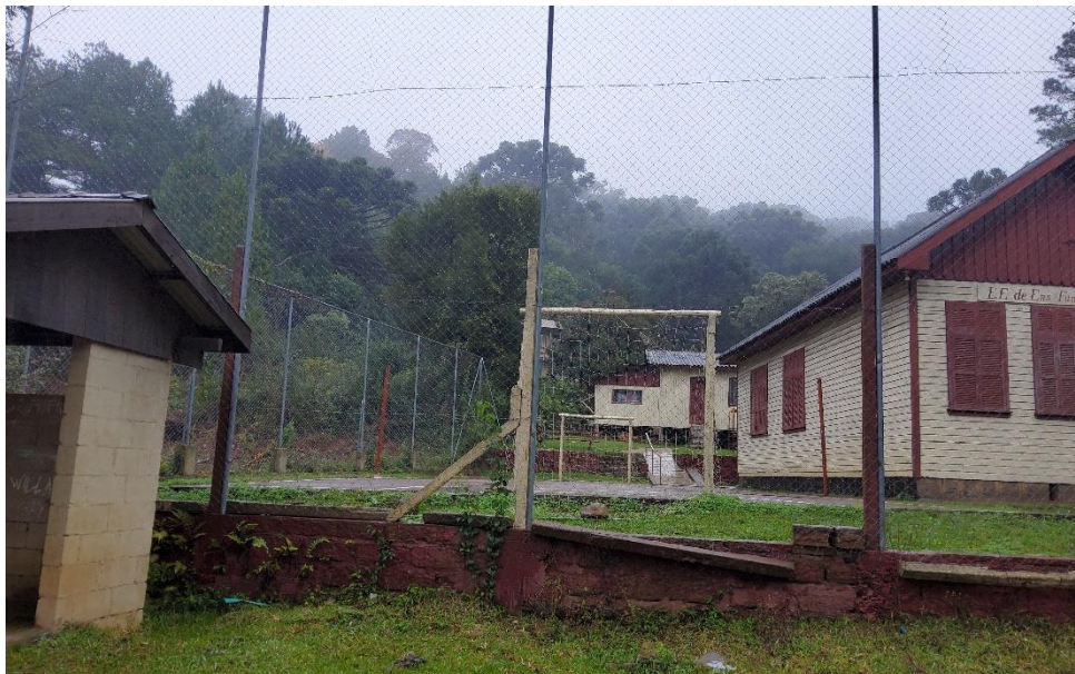
Figura 8 – Escola da comunidade da barragem do Salto, sem danos geotécnicos evidentes.
