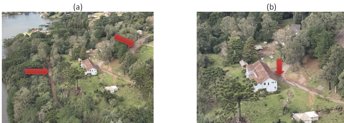
Figura 4 – Proximidades da barragem do Salto: (a) acessos com trincas e rachaduras e (b) local da trinca no terreno do antigo hotel.
