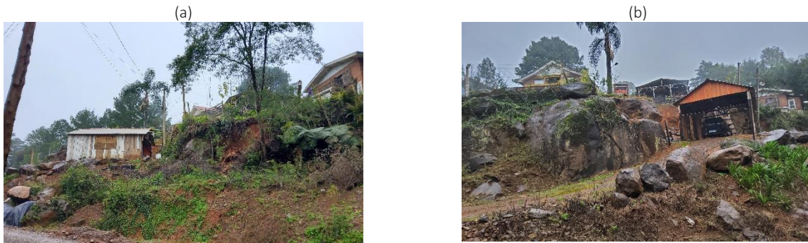
Figura 9 – Proximidades da barragem do Salto: residências (a) próximas ao talude de corte e (b) em áreas de blocos de rochas.
