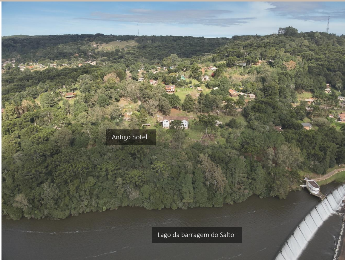
Figura 3 – Local vistoriado na região do Salto, próximo à barragem.
