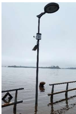
Figura 8: Estação em poste em frente ao prédio da SPH-RS.
