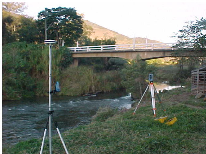
Figura III-14 DGPS base móvel e estação total na ponte Santo Antônio
