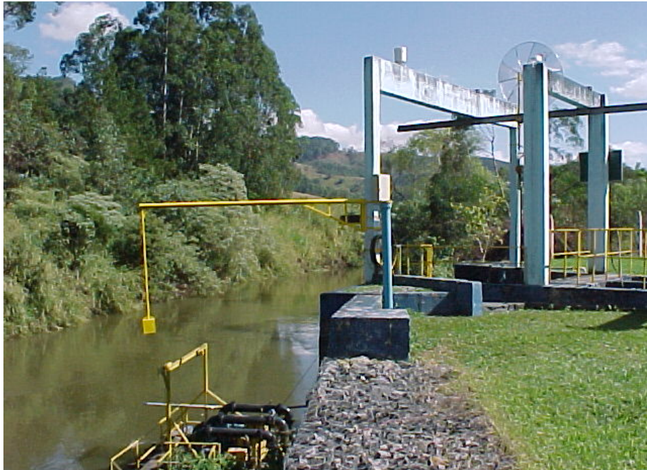
Figura III-4 Seção de controle a jusante – Captação-Copasa
