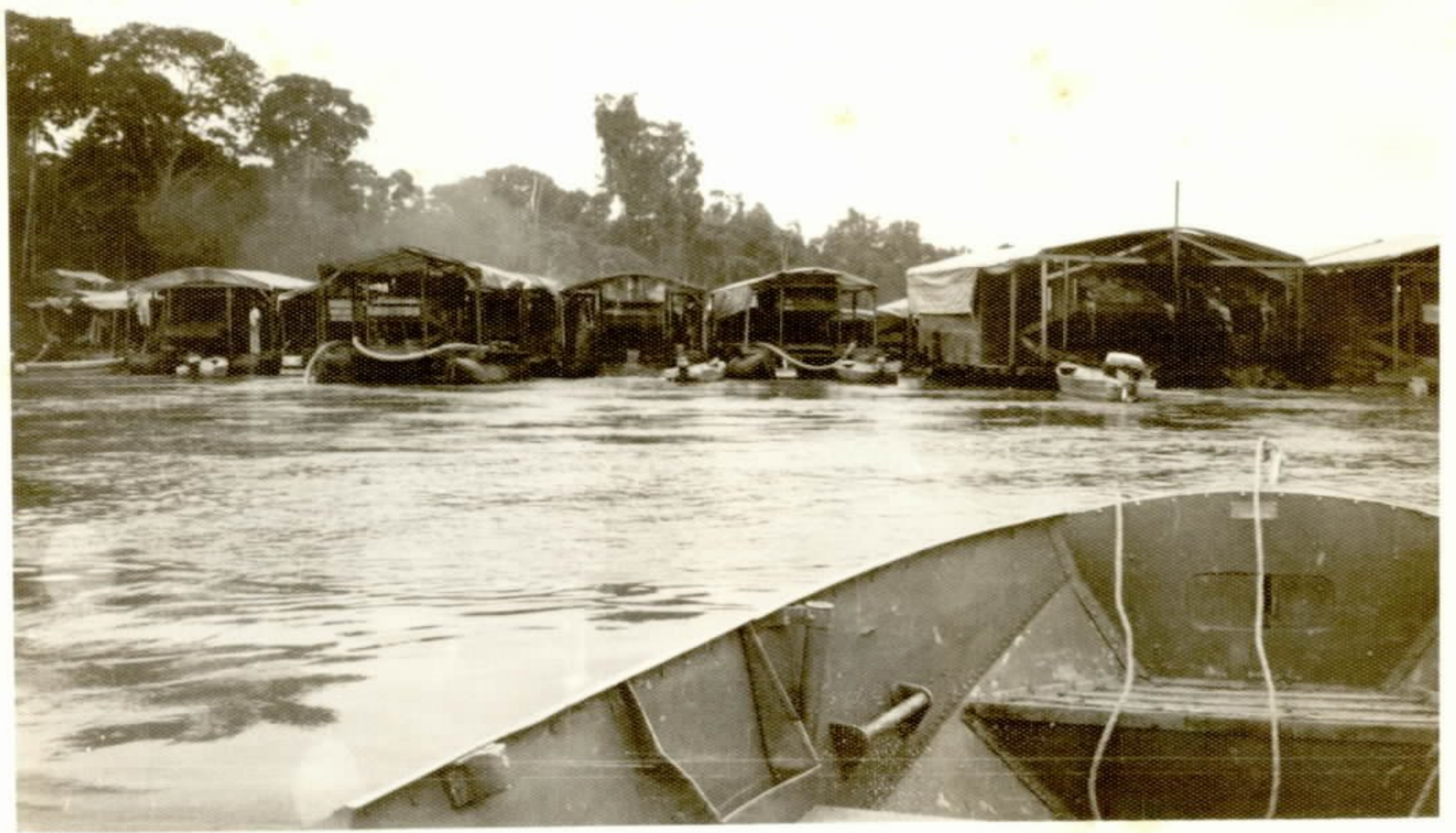
Foto nº 3 - Parte posterior de uma fila de balsas em operação, notando-se chumaços de fumaça emanados pela combustão de motores a Diesel que poluem o ar, acarretando sérios riscos a saúde dos mergulhadores quando emergem do fundo do rio.
