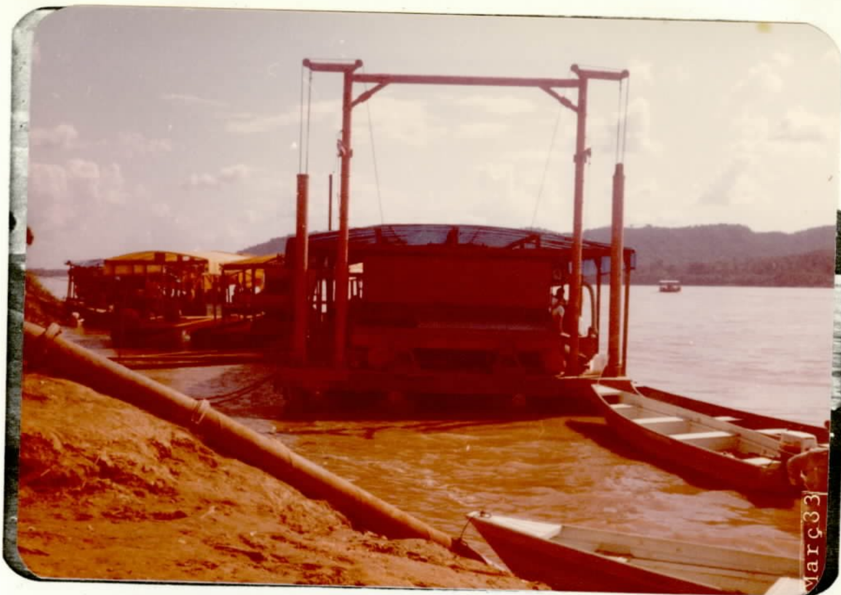
Foto nº 7 - Detalhe de uma draga construída em ferro.
