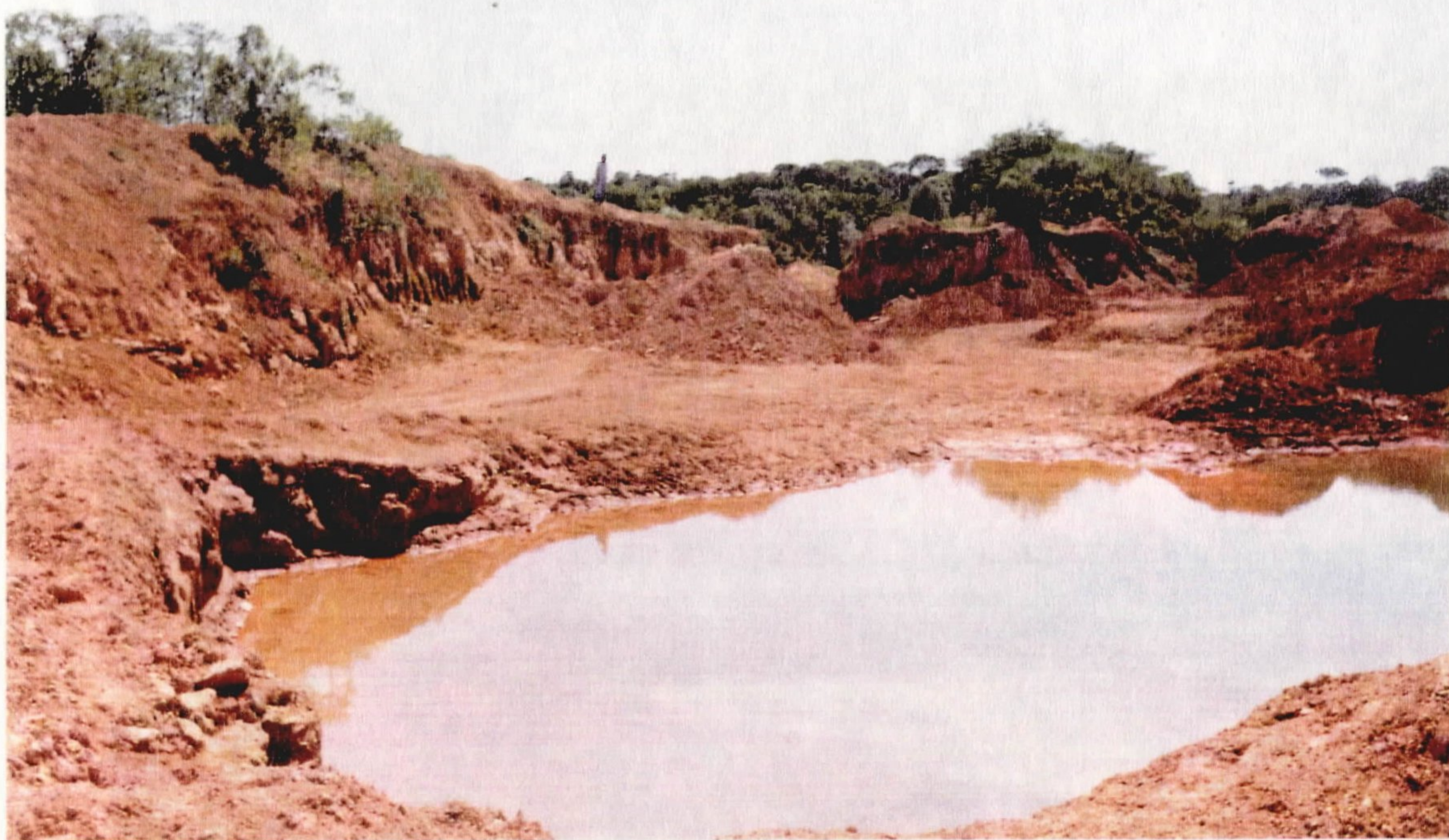
Foto 3 - Extração de argilas residuais da Formação Palermo. Observa-se a sub-utilização da jazida devido a falta de critérios, como drenagem superficial e planejamento de bancadas.
