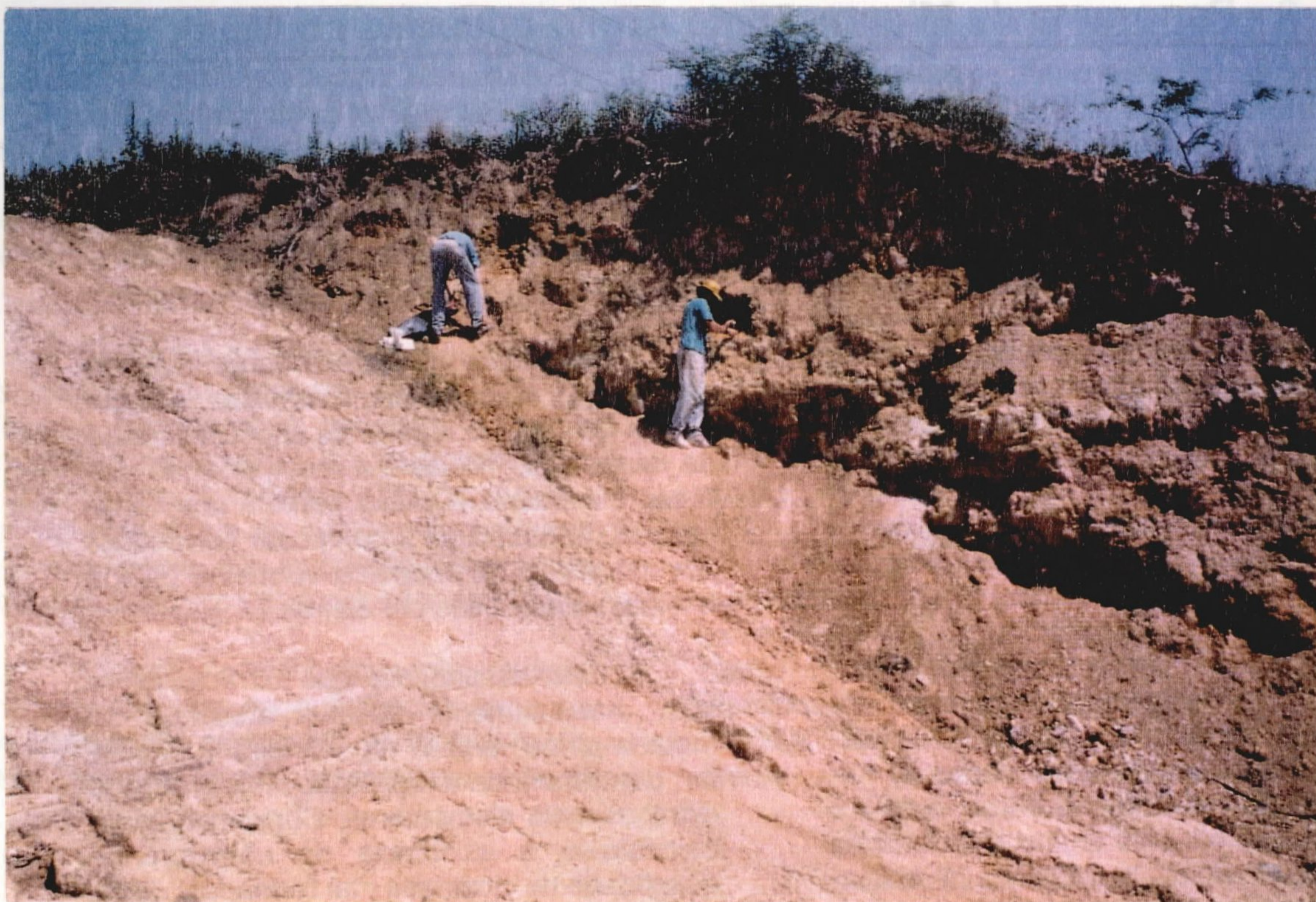
Foto 2 - Argilas residuais provenientes da alteração de rocha pelíticas da Formação Palermo. Em primeiro plano, a alternância de tonalidade evidencia a laminação plano paralela da rocha original. Bairro Próspera.
