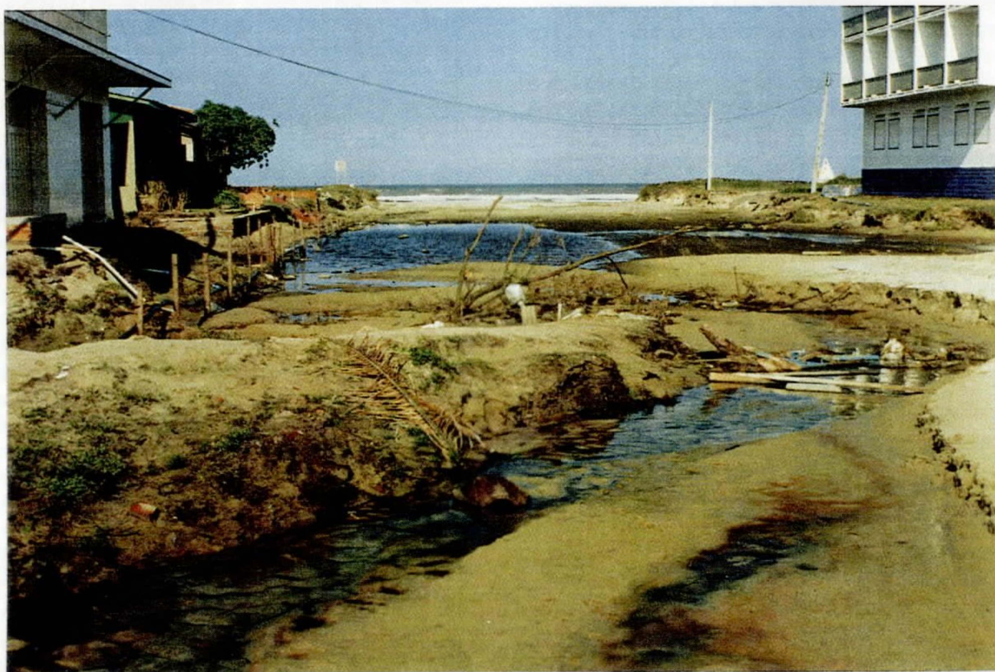
Foto 12 - Destruição das ruas e calçamento à beira-mar por efeito de enxurrada, no mês de maio de 1995. Balneário de Rainha do Mar. (Foto cedida por Douglas R. Trainini).
