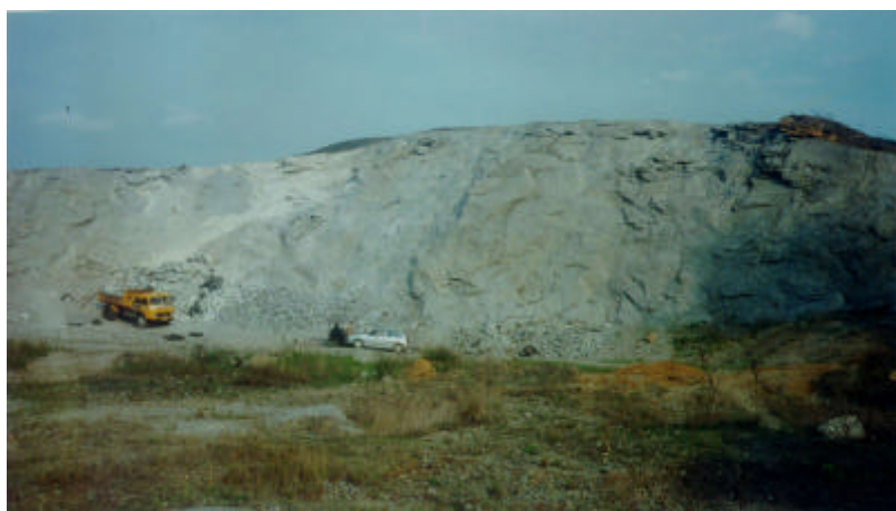
FOTO 4.1 Pedreira com produção mecanizada de brita, no Granito Nanuque. Local: Nanuque. Estação: MP-625. UTM: 357530/8027843.
