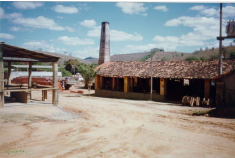
FOTO 4.3 Cerâmica Rezende Ltda. Local: Ubaporanga. Estação: NS-424. UTM: 803483/7827008.
