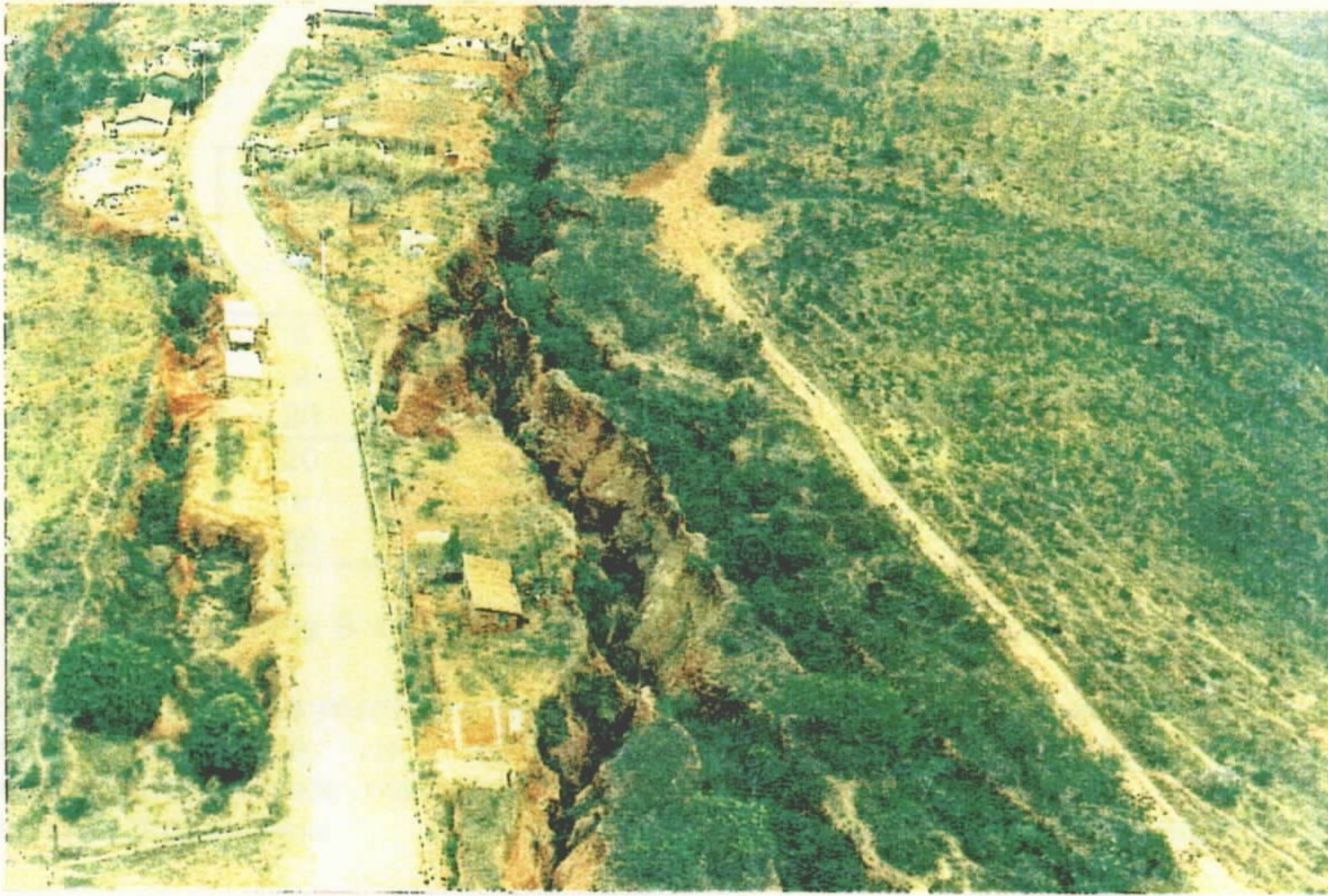
Foto 7: Vista aérea da voçoroca linear instalada no Morro do Cruzeiro, município de Lagoa Santa (MG), em terrenos de alta declividade constituídos por residuais de metapelitos. (Fonte: Projeto de Recuperação Ambiental do Lago da Cidade de Lagoa Santa - CETEC)
