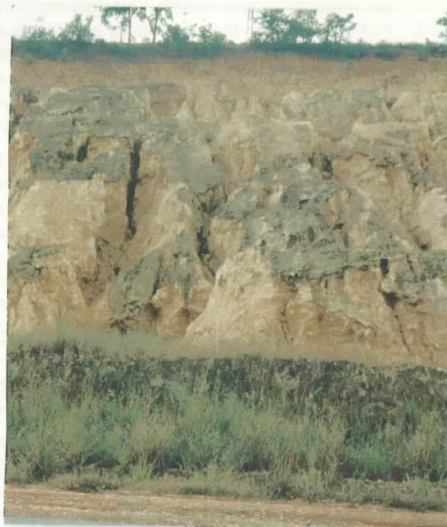
Foto 11: Erosão em sulco em talude da rodovia MG-424 em residuais do Complexo Metapelítico e sedimentos coluviais. Km 50, município de Matozinhos (MG).
