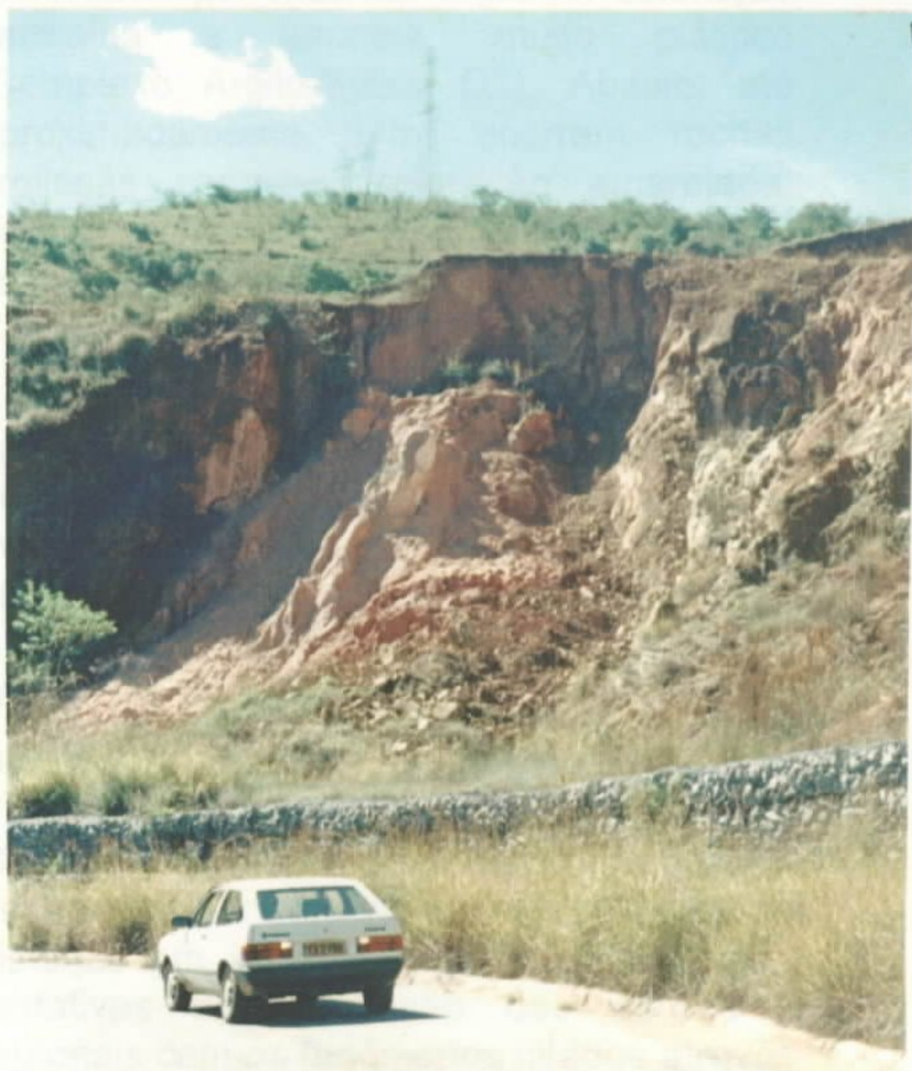
Foto 10: Desbarrancamento em talude da rodovia MG-10, em residuais de rochas do Complexo Gnáissico-Migmatítico Indiviso. Município de Vespasiano (MG).
