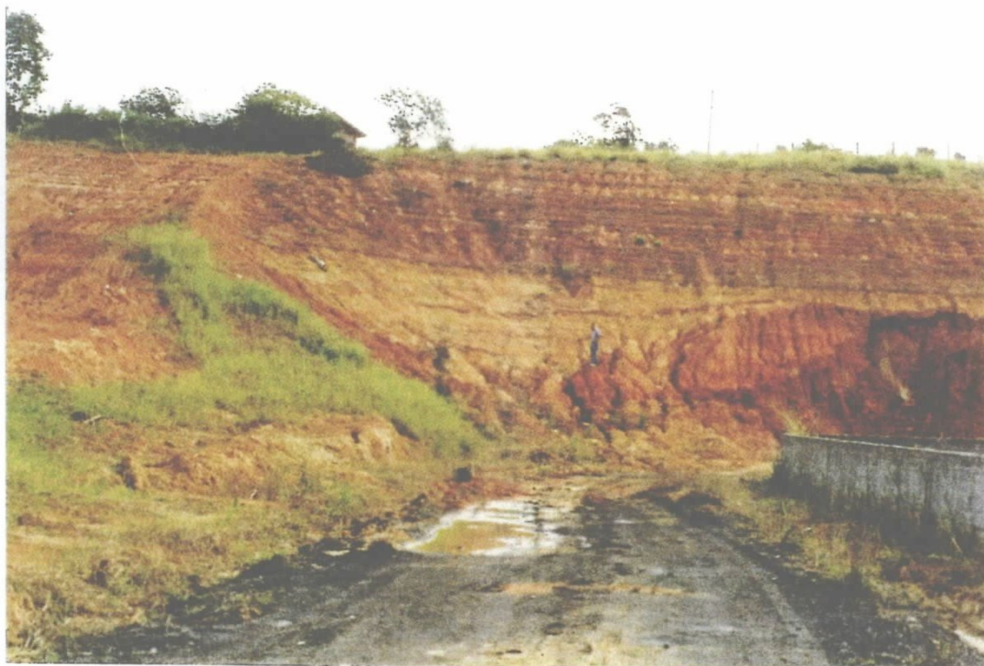
Foto 03 - Corte de encosta, onde afloram solos Podzólicos Vermelho-Amarelo, muito suscetíveis à erosão. A exposição do horizonte C ao escoamento superficial origina inúmeros sulcos na superfície do terreno. Local - Bairro Próspera.
