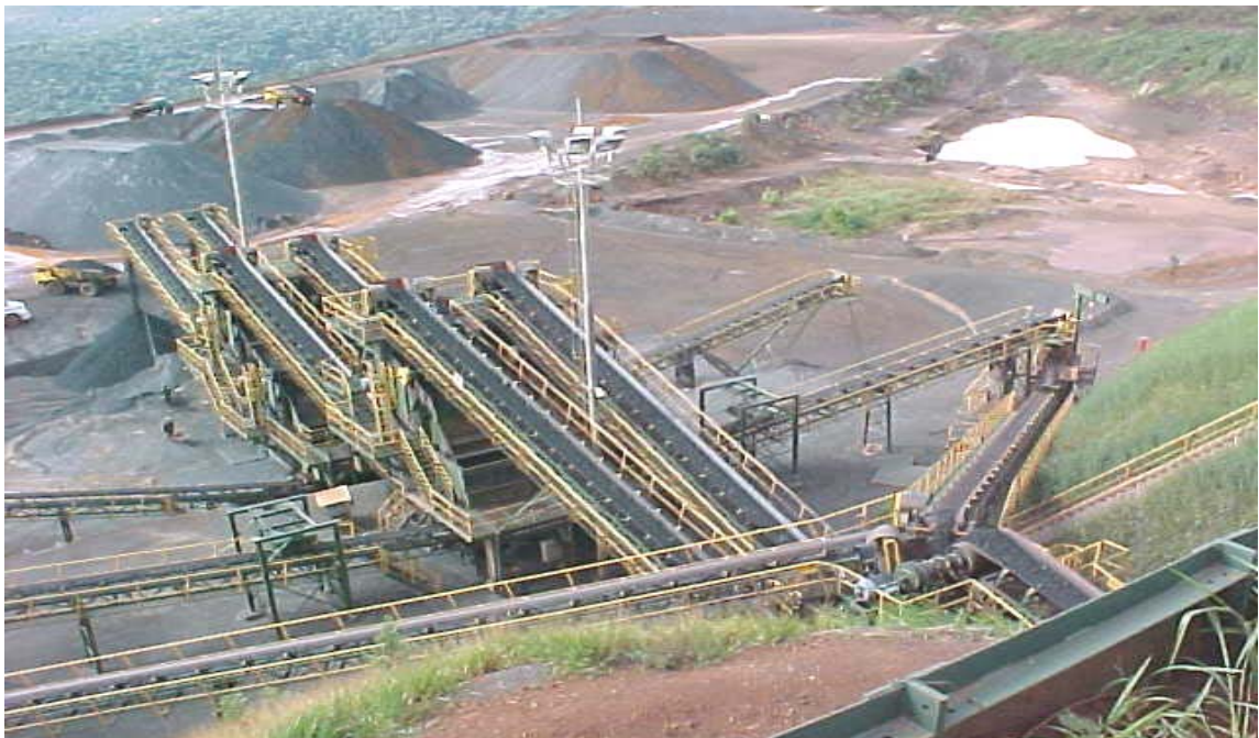
FOTO 22 – Instalação de Tratamento de Minério – ITM-4.
