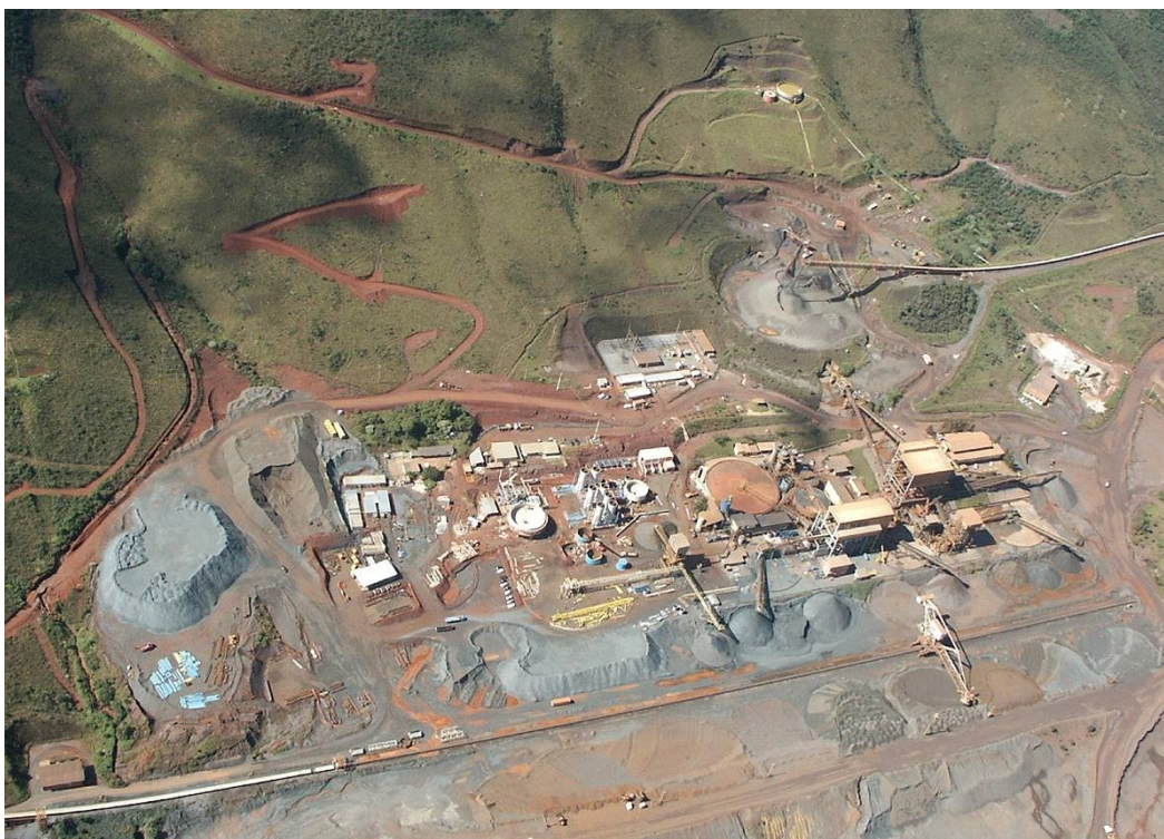
FOTO 16 - Instalação de Tratamento de Minério (ITM-D) do Complexo do Pico do Itabirito
