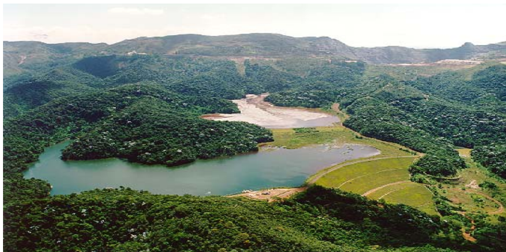
FOTO 14 – Barragem de rejeitos da Mina de Águas Claras, ferro, Nova Lima, MG.
