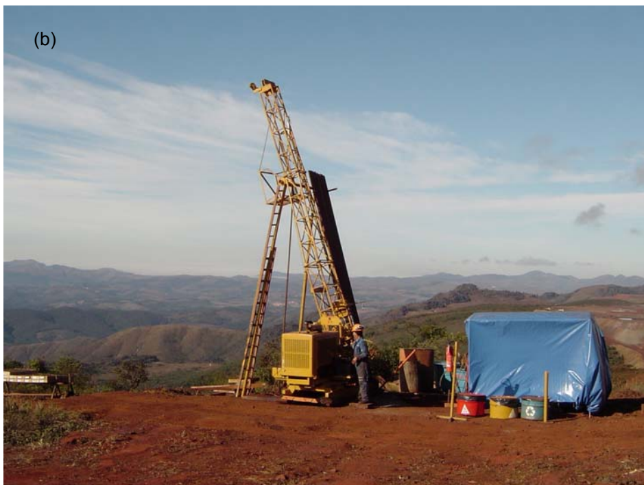
FOTO 1 a e b - Métodos de investigação por sondagem rotativa diamantada.
