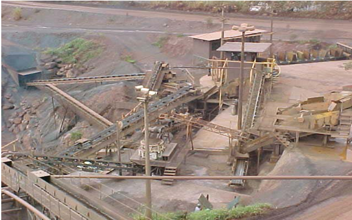
FOTO 21 – Instalação de Tratamento de Minério – ITM-3.
