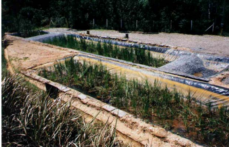
FOTO 24 - Tratamento de drenagem ácida na Mina Esperança, Santa Rita, Nova Lima (ponto 819).
