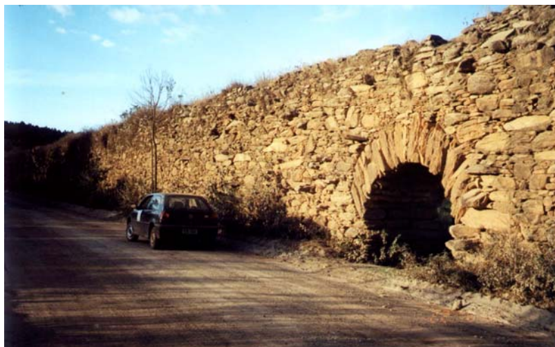
FOTO 27 - Antigo aqueduto na região de Catas Altas.
