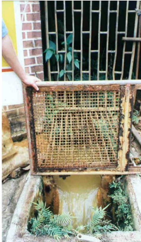
FOTO 10 - Drenagem ácida na Mina do Faria, Honório Bicalho, Nova Lima (ponto 815).
