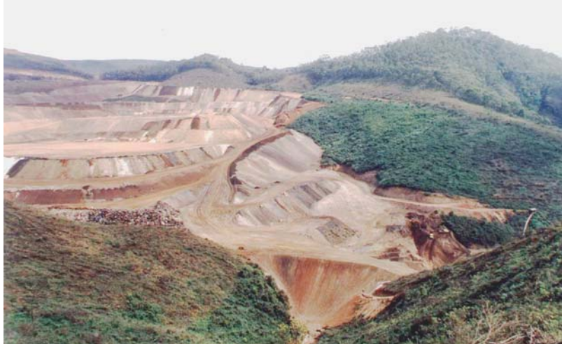
FOTO 21 - Construção de aterro de estéril na Mina do Tamanduá.
