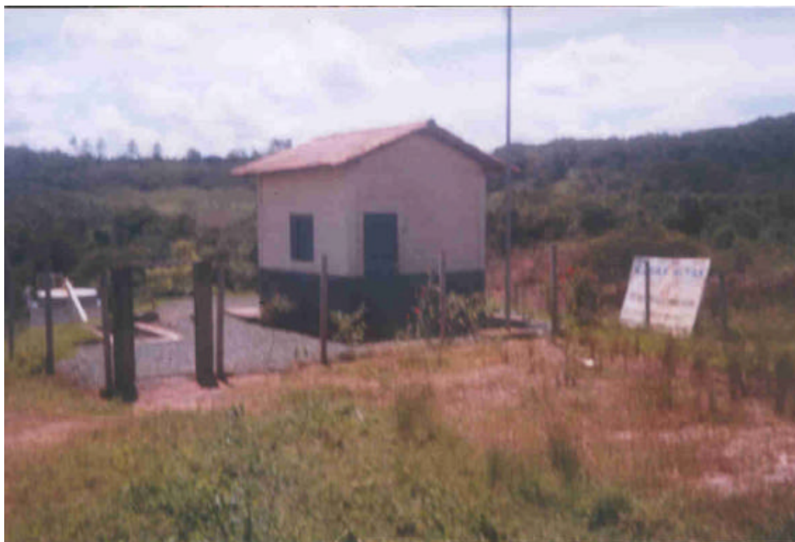
VISTA GERAL DA ESTAÇÃO DE TRATAMENTO DE ESGOTO – UTM-E:667169/UTM-N:7775468
