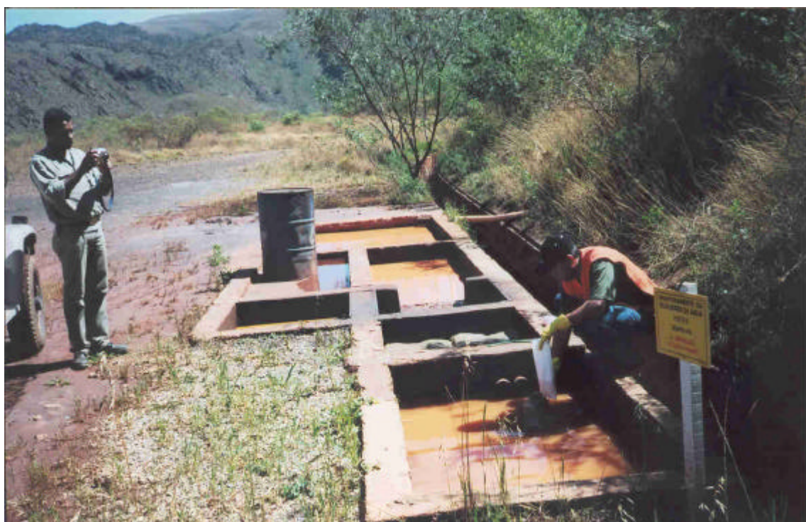
VISTA DO LOCAL DE COLETA DE AMOSTRA NA CAIXA SEPARADORA DE ÓLEOS E GRAXAS (SEMPRE VIVA)
