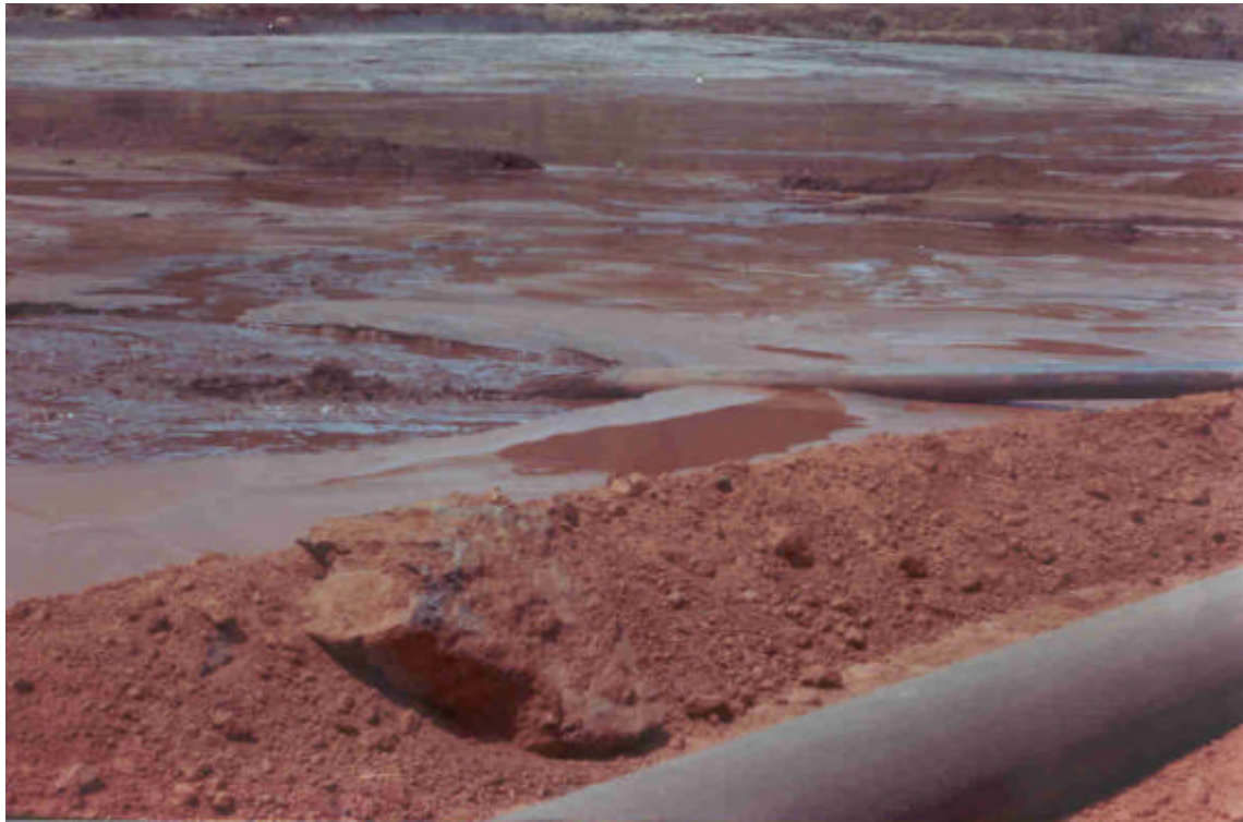
VISTA DO DESPEJO DA ÁGUA USADA NA MINA DA JANGADA NA BARRAGEM
