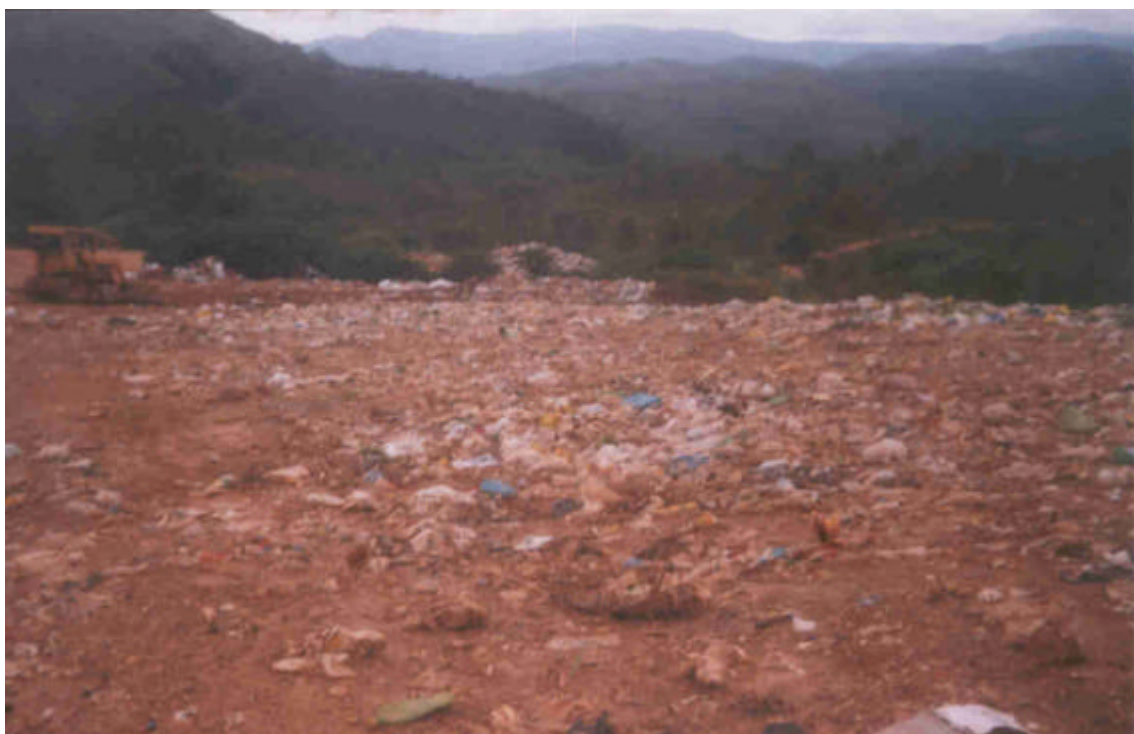
VISTA DO ATERRO SUSTENTÁVEL – UTM-E:634798/UTM-N:7799779
