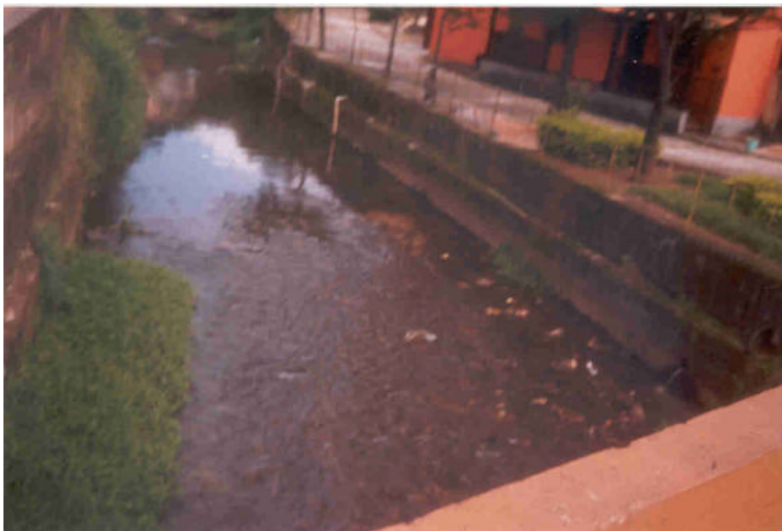
PONTO Nº 2 – RUA CLÓVIS SALGADO COM RUA TANCREDO NEVES – UTM-E:658672/UTM-N:7794706
