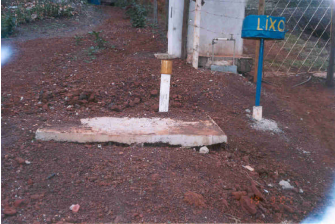
VISTA DO COLETOR DE ESGOTO "FOSSA NEGRA"- UTM-E:605175/UTM-N:7782216
