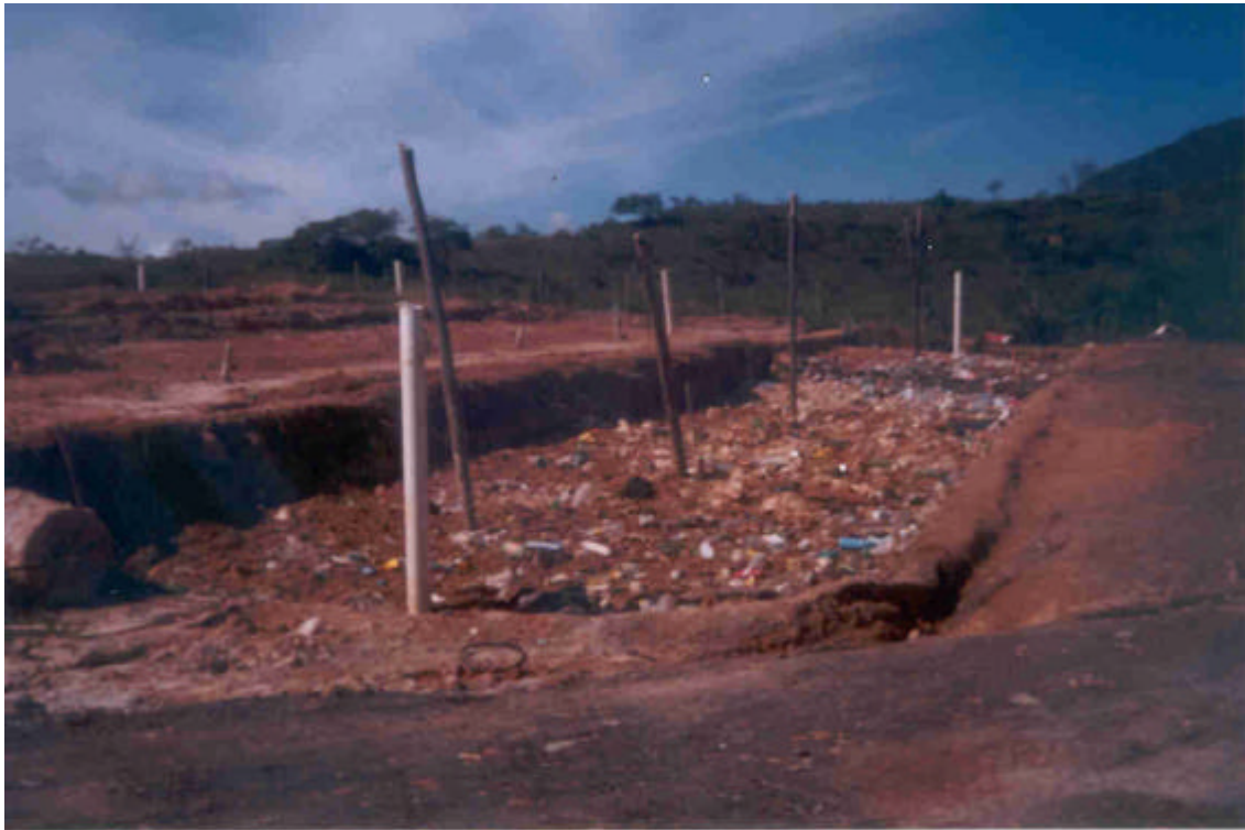
VISTA DO ATERRO SUSTENTÁVEL – UTM-E:434609 E UTM-N:7867992
