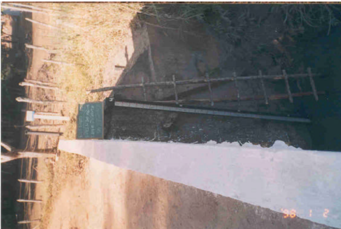
VISTA DE LANCE COMPLEMENTAR DA SEÇÃO DE RÉGUA
