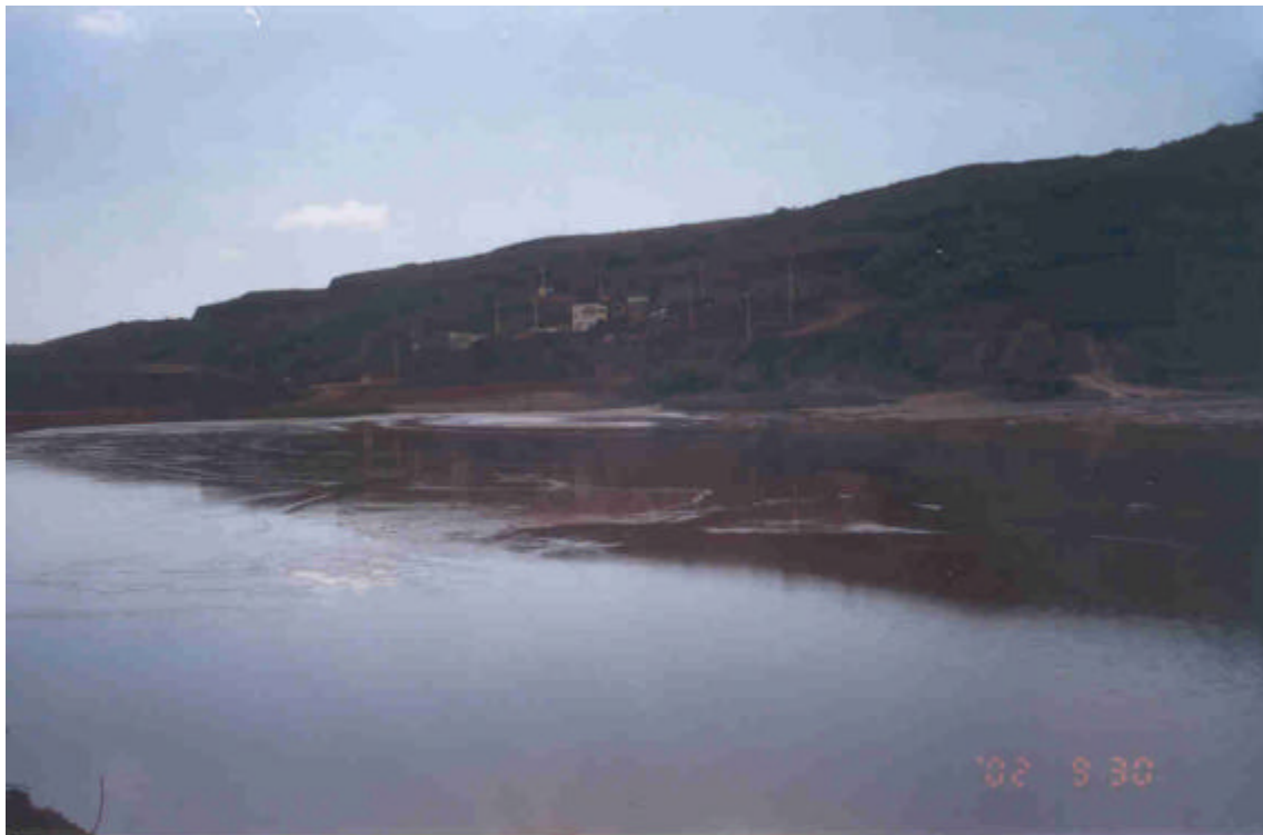
VISTA DA BARRAGEM DE CONTENÇÃO DE FINOS(V & M TUBES)-UTM-E:603864/UTM-N:7770337
