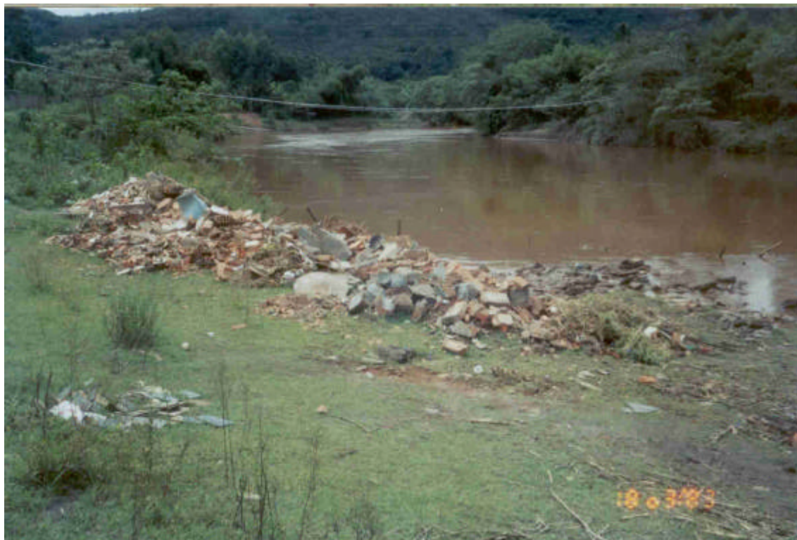
VISTA DO LOCAL DE DEPOSIÇÃO DE ENTULHO A JUSANTE DA PONTE
