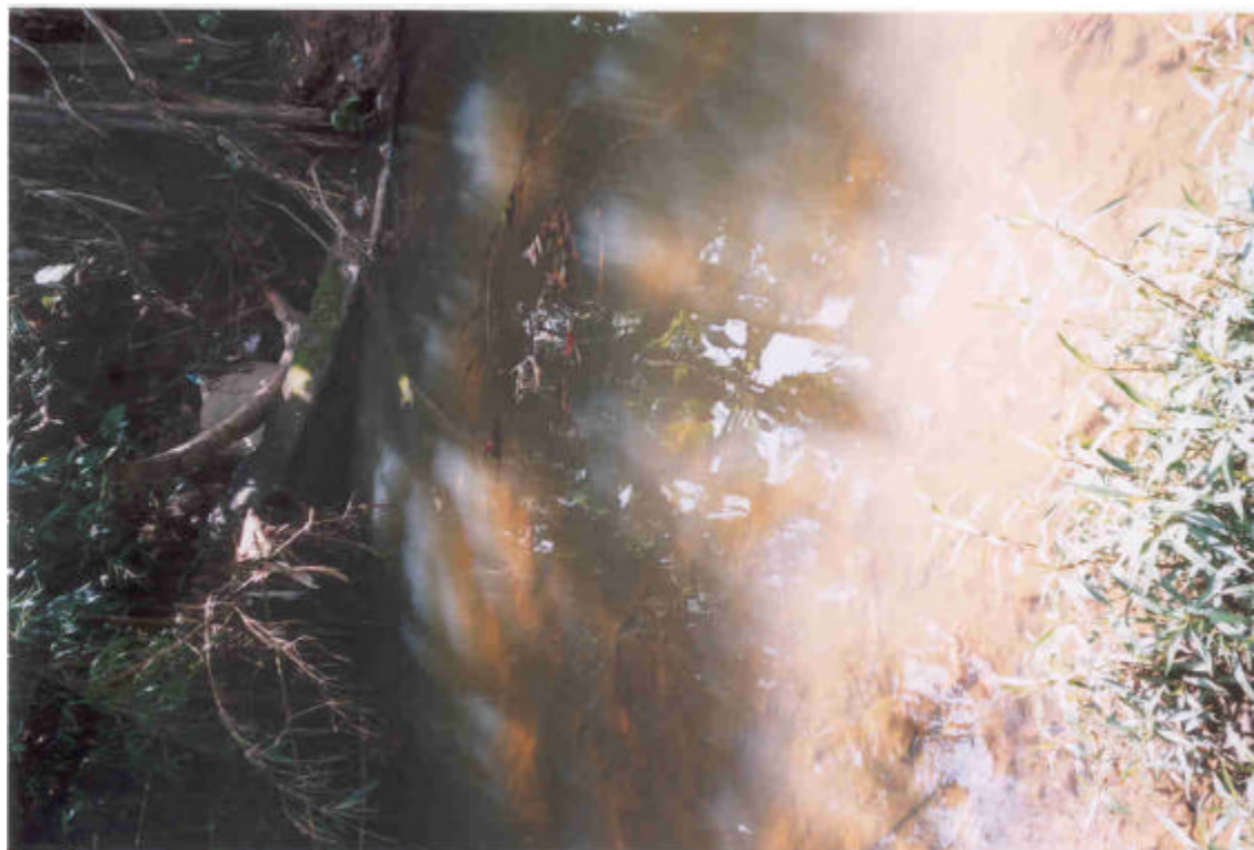
PONTO Nº 2 – LANÇAMENTO DA JUSANTE DA PONTE DO PASTINHO – UTM-E:626700/UTM-N:7778649
