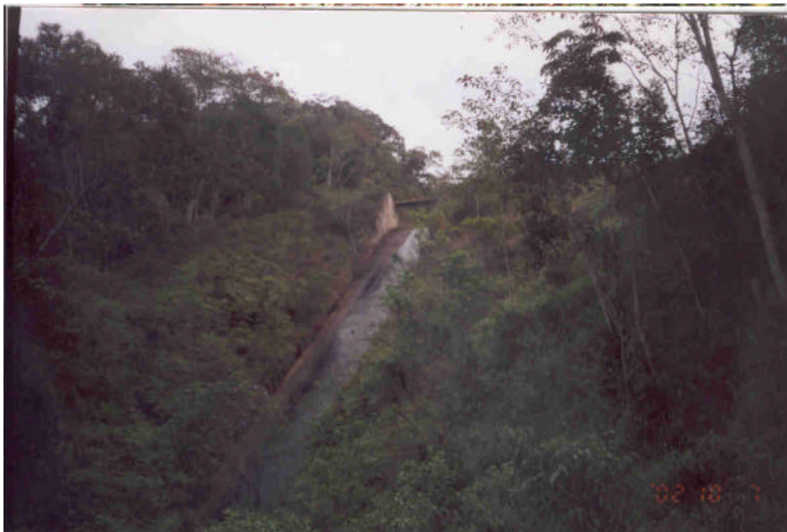
VISTA DO VERTEADOR DE GROTA 2 (MINA DE ÁGUAS CLARAS)
