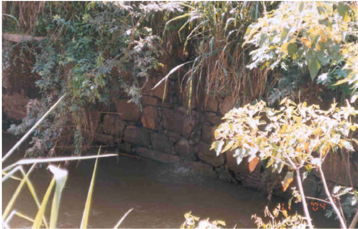
VISTA DO LOCAL DE LANÇAMENTO NA PONTE DO LAVRADO – UTM-E:582547/UTM-N:7772553
