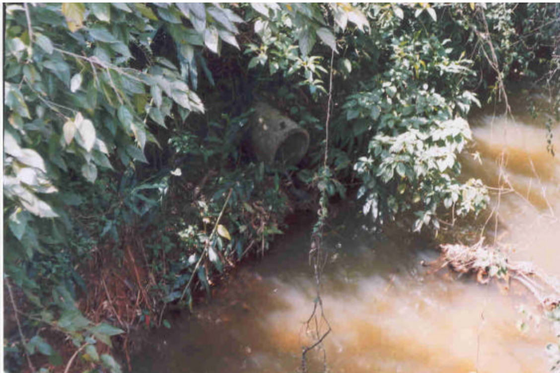
PONTO Nº 1 – LANÇAMENTO A MONTANTE DA PONTE DO PASTINHO – UTM-E:626700/UTM-N:7778649
