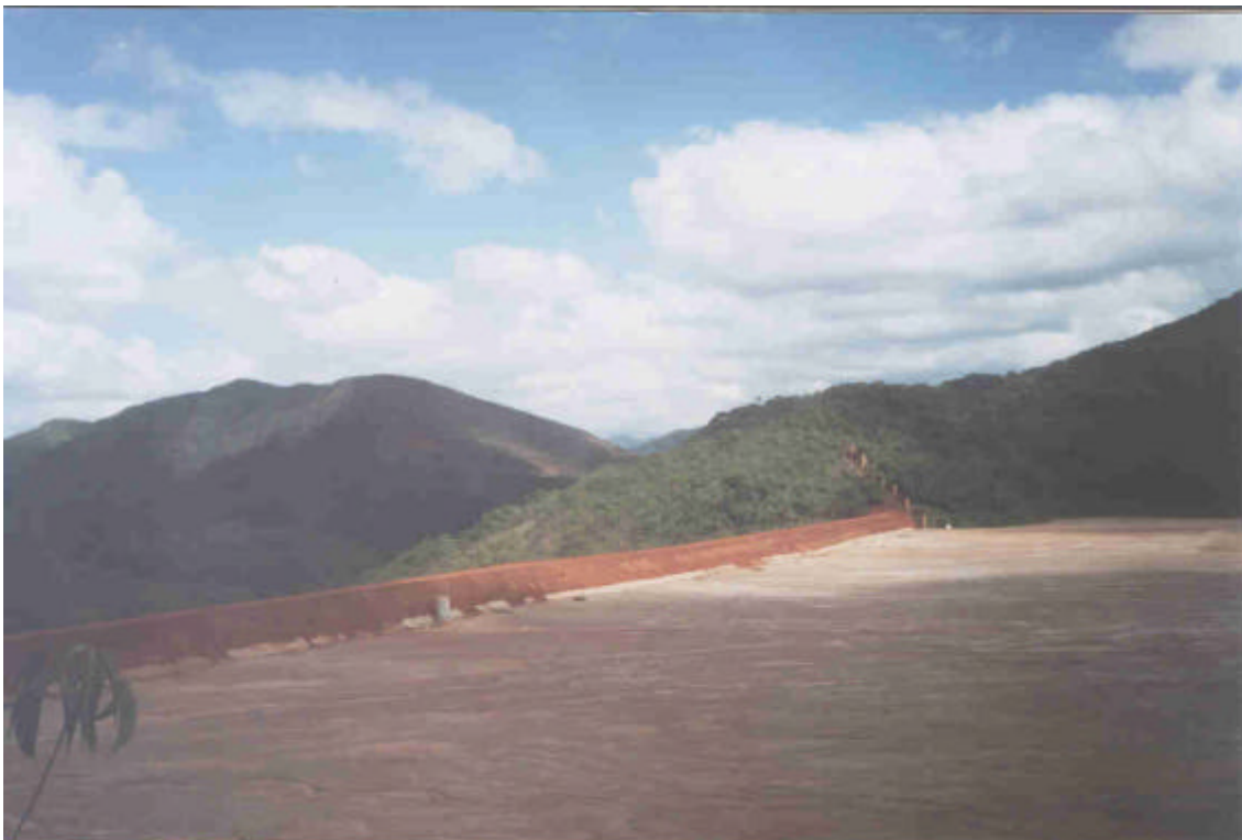
VISTA PANORÂMICA DA BARRAGEM DE CONTENÇÃO DE FINOS
