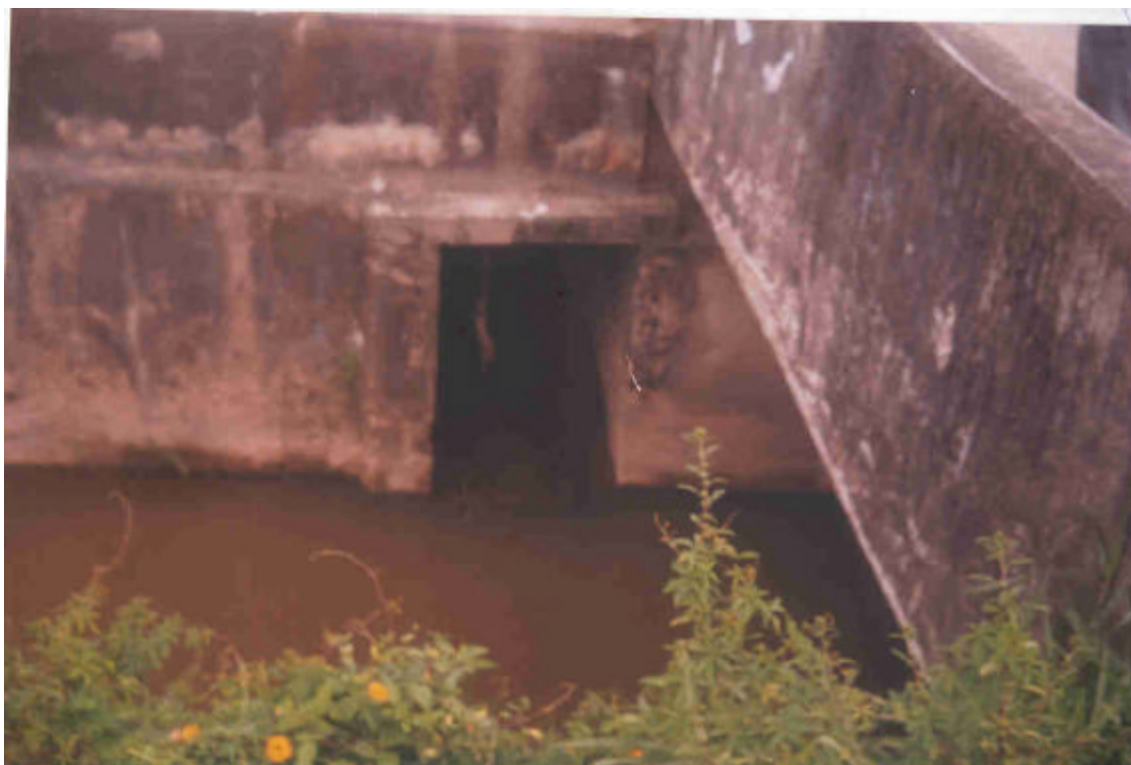
PONTO Nº 2 – Av. JOÃO PINHEIRO (PTE DA ESTAÇÃO)-UTM-E:639981/UTM-N:7799183
