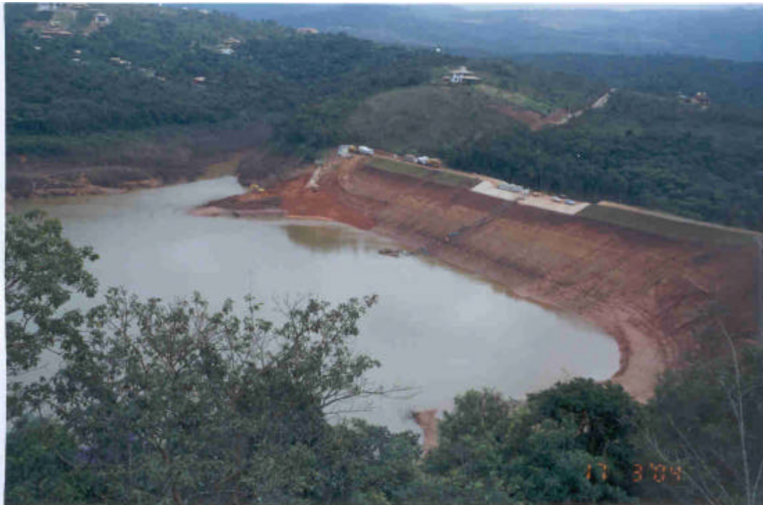
VISTA DA BARRAGEM DA MINA TAMANDUÁ – UTM-E:611848/UTM-N:7780799
