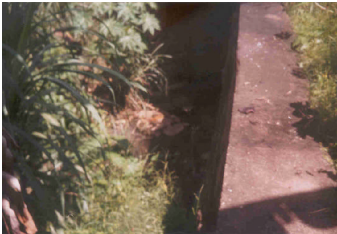
PONTO Nº 10 – Córrego do Soberbo – UTM-E:639761/UTM-N:7802178
