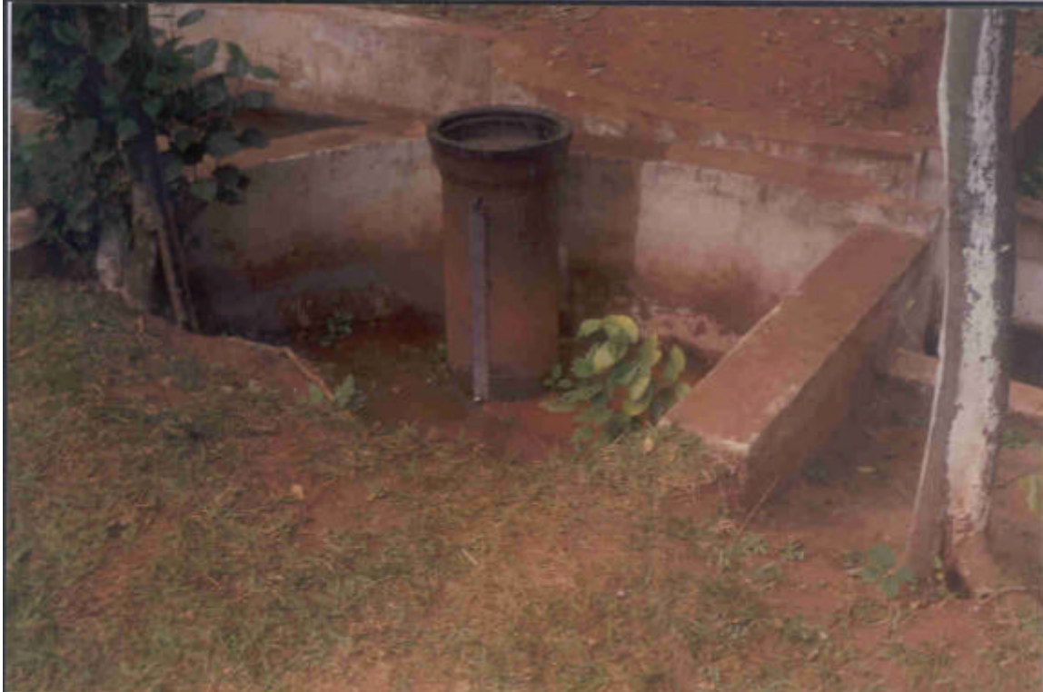
VISTA DO POÇO TRANQUILIZADOR (COTA DA CALHA)
