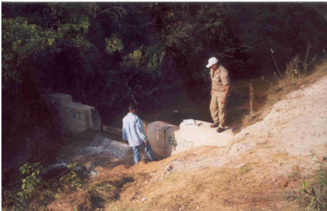
VISTA DO VERTEADOR DO CÓRREGO AREDES
