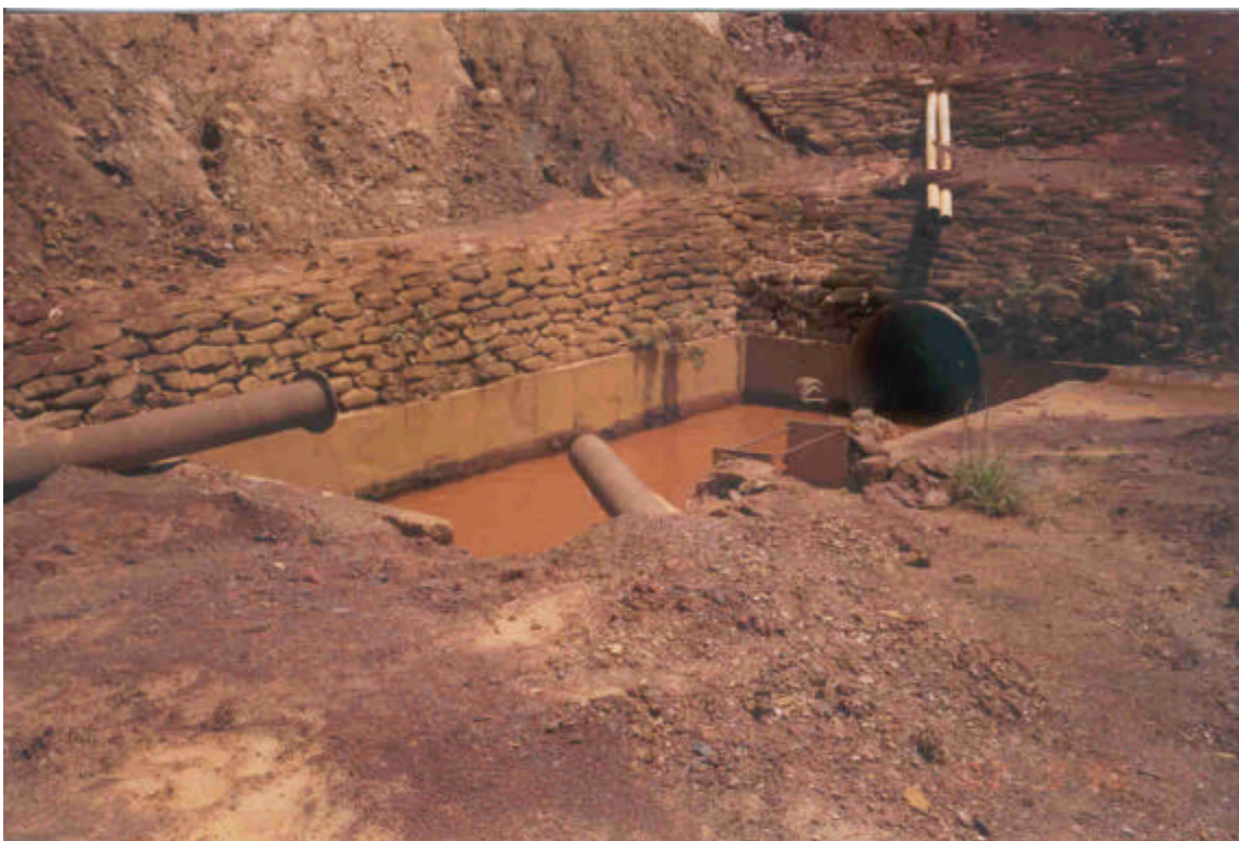
VISTA DA CAIXA DE SEDIMENTAÇÃO (V & M TUBES)-UTM-E:606395/UTM-N:7771688
