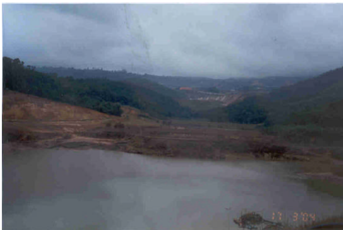
VISTA PANORÂMICA DA BARRAGEM DA MINA TAMANDUÁ
