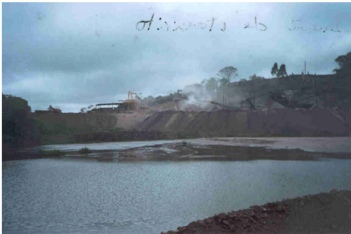
VISTA DA BARRAGEM DE CONTENÇÃO DE FINOS DA EXTRAMIL
