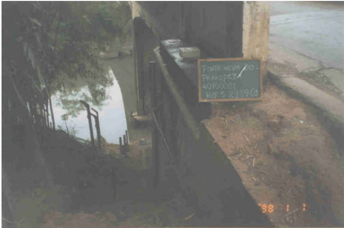
VISTA DOS RNS
