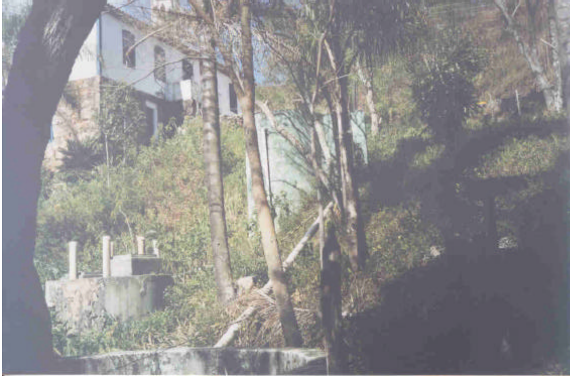
VISTA DA ESTAÇÃO DE TRATAMENTO DE ESGOTO DO CARAÇA –UTM-E:657948/UTM-N:7777015
