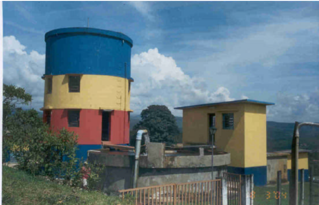
VISTA DA ESTAÇÃO DE TRATAMENTO – UTM-E:627074/UTM-N:7778385
