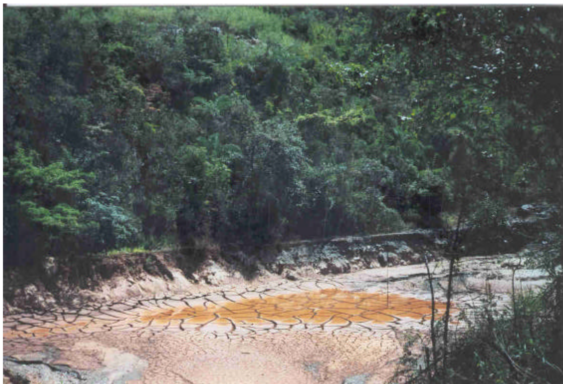
VISTA DA BARRAGEM DE CONTENÇÃO DE FINO DE PEDRAS CONGONHAS
