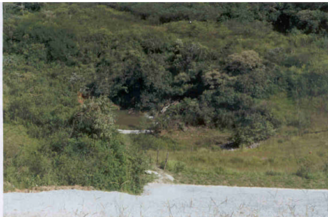
VISTA DA BARRAGEM DA MINERAÇÃO MORRO VELHO – UTM-E:622555/UTM-N:7791086
