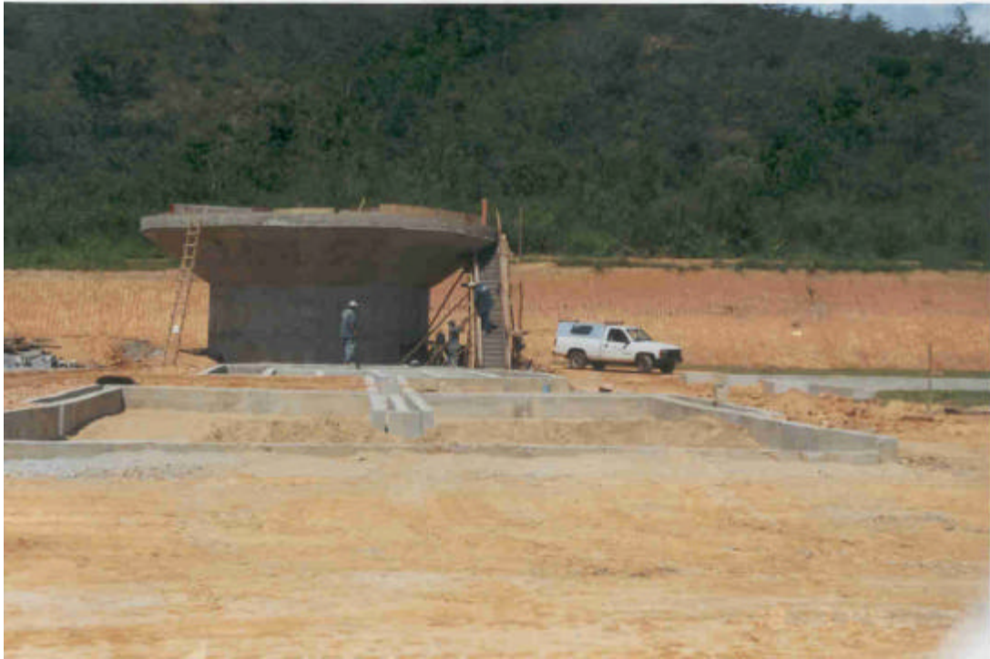
VISTA DA ESTAÇÃO DE TRATAMENTO DE ESGOTO EM CONSTRUÇÃO
