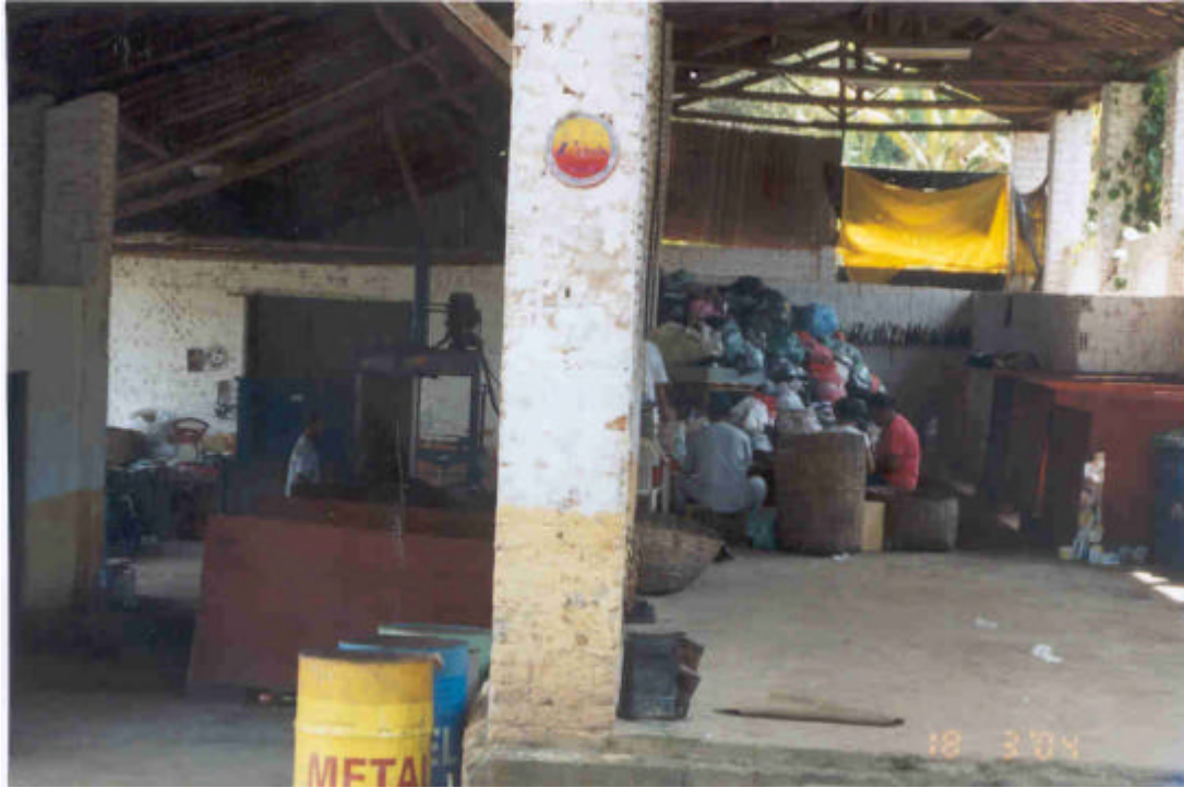
VISTA DA USINA DE RECICLAGEM -UTM-E:626579/UTM-N:777738
