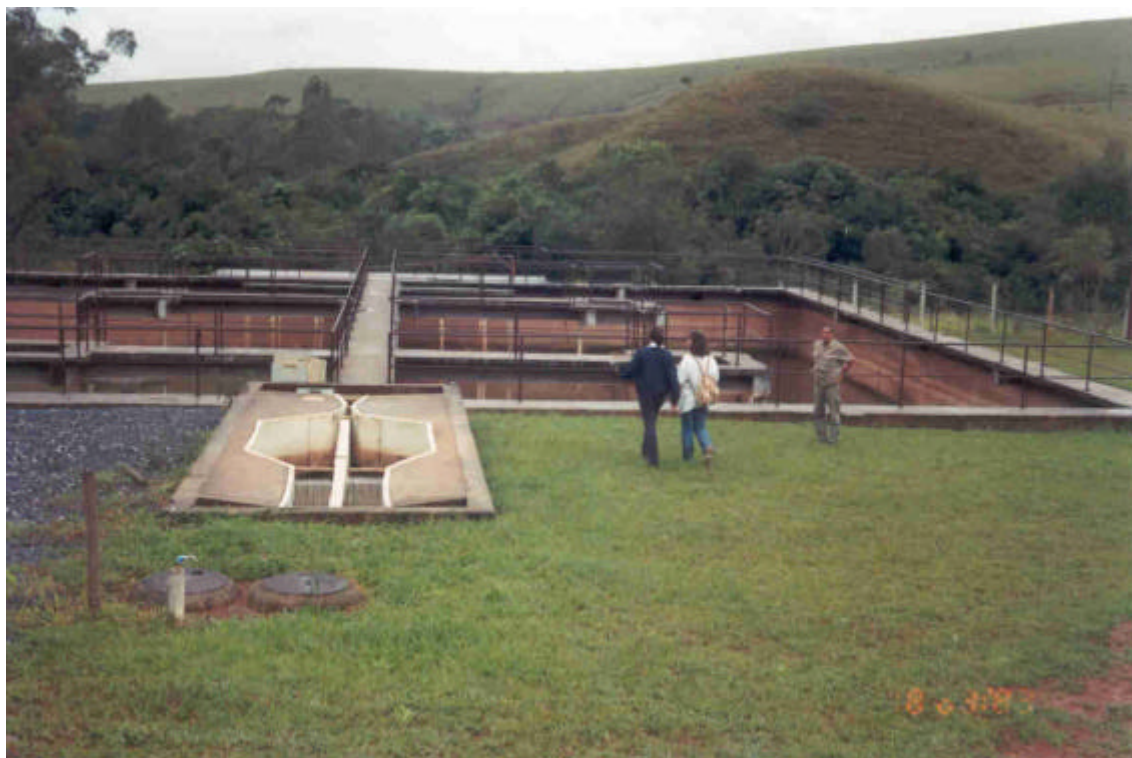
VISTA DA ESTAÇÃO DE TRATAMENTO DO Condomínio Alphaville
