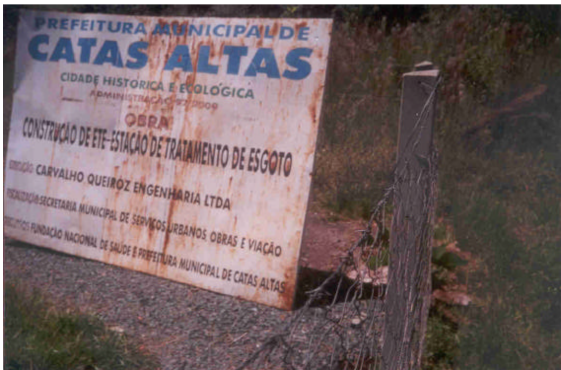
VISTA DA PLACA DA ESTAÇÃO DE TRATAMENTO DE ESGOTO – UTM-E:667169/UTM-N:7775468
