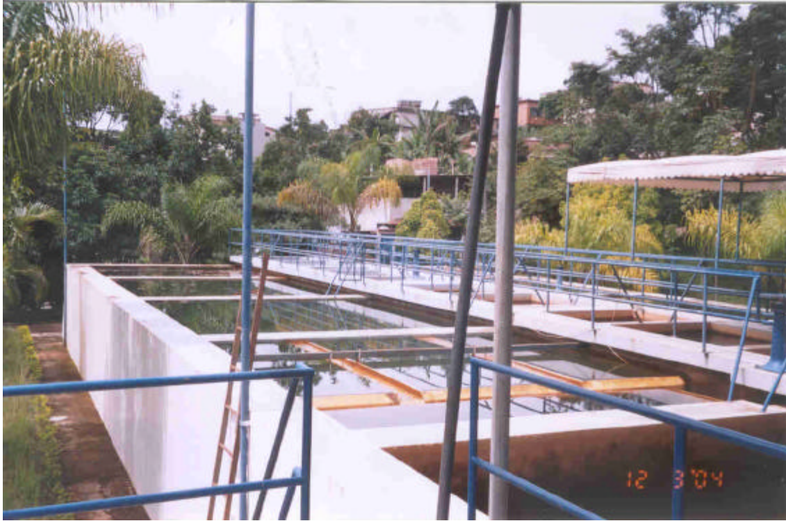
VISTA DA ESTAÇÃO DE TRATAMENTO DE ÁGUA - UTM-E:623484/UTM-N:7759440
