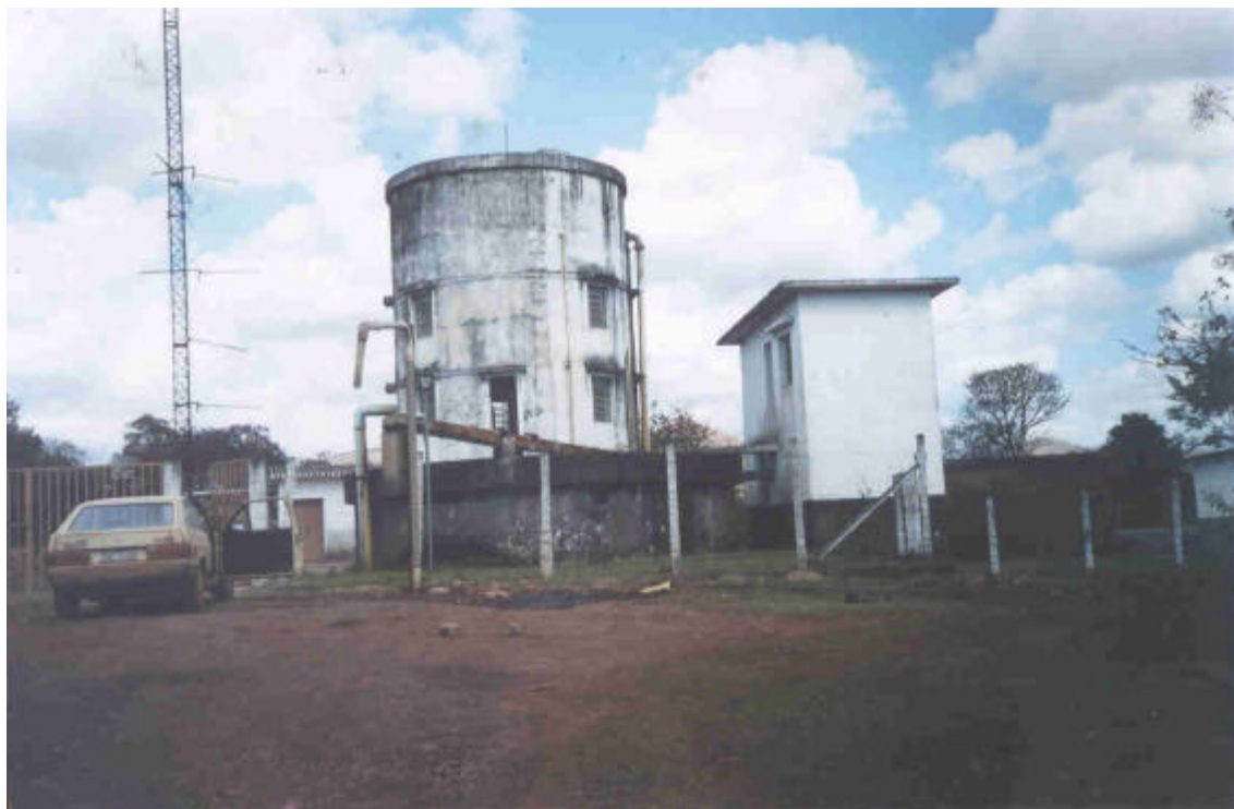
VISTA DA ESTAÇÃO DE TRATAMENTO DE ÁGUA
