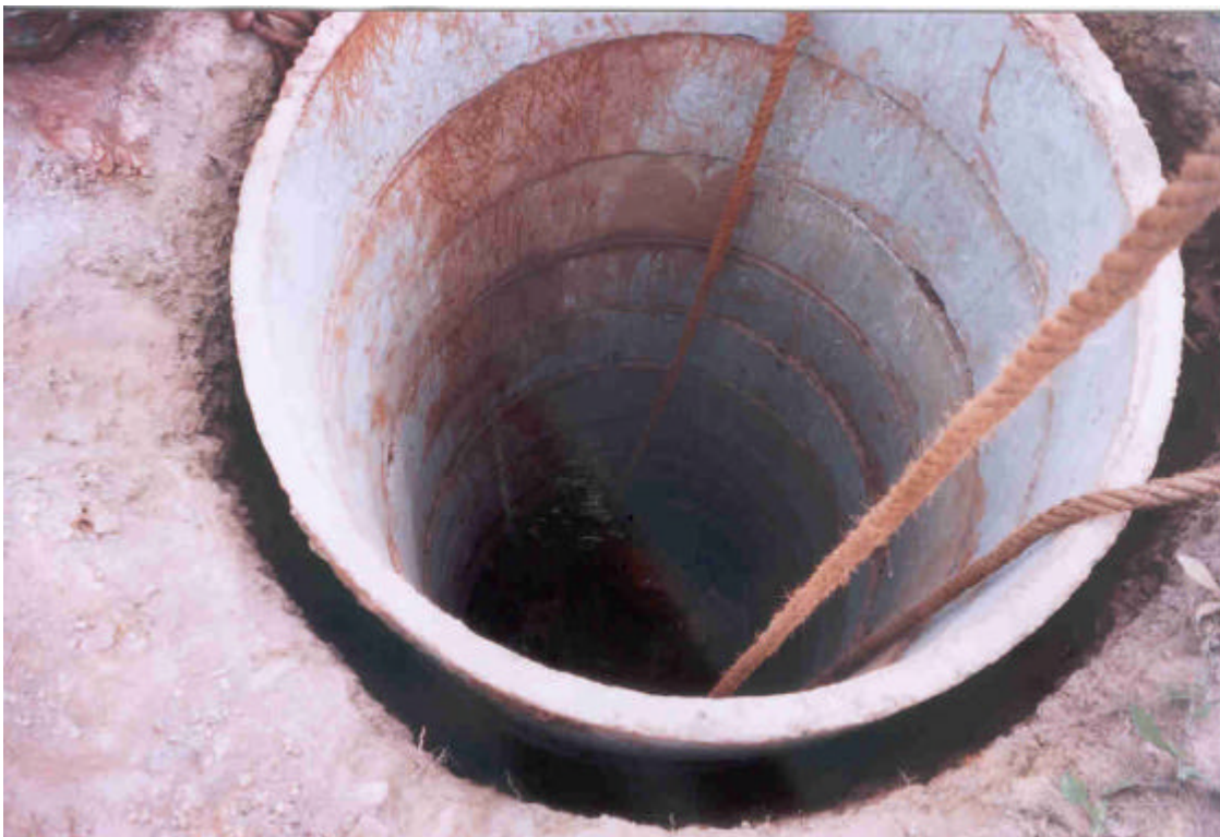
VISTA DA FOSSA NEGRA REVESTIDA EM FASE DE CONSTRUÇÃO
