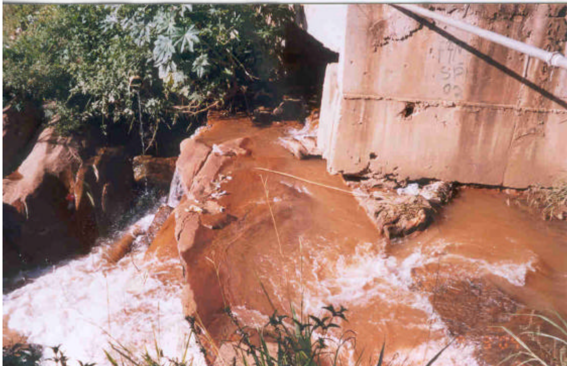
PONTO Nº 3 – Córrego Sumidouro – UTM-E:596924/UTM-N:7784848
