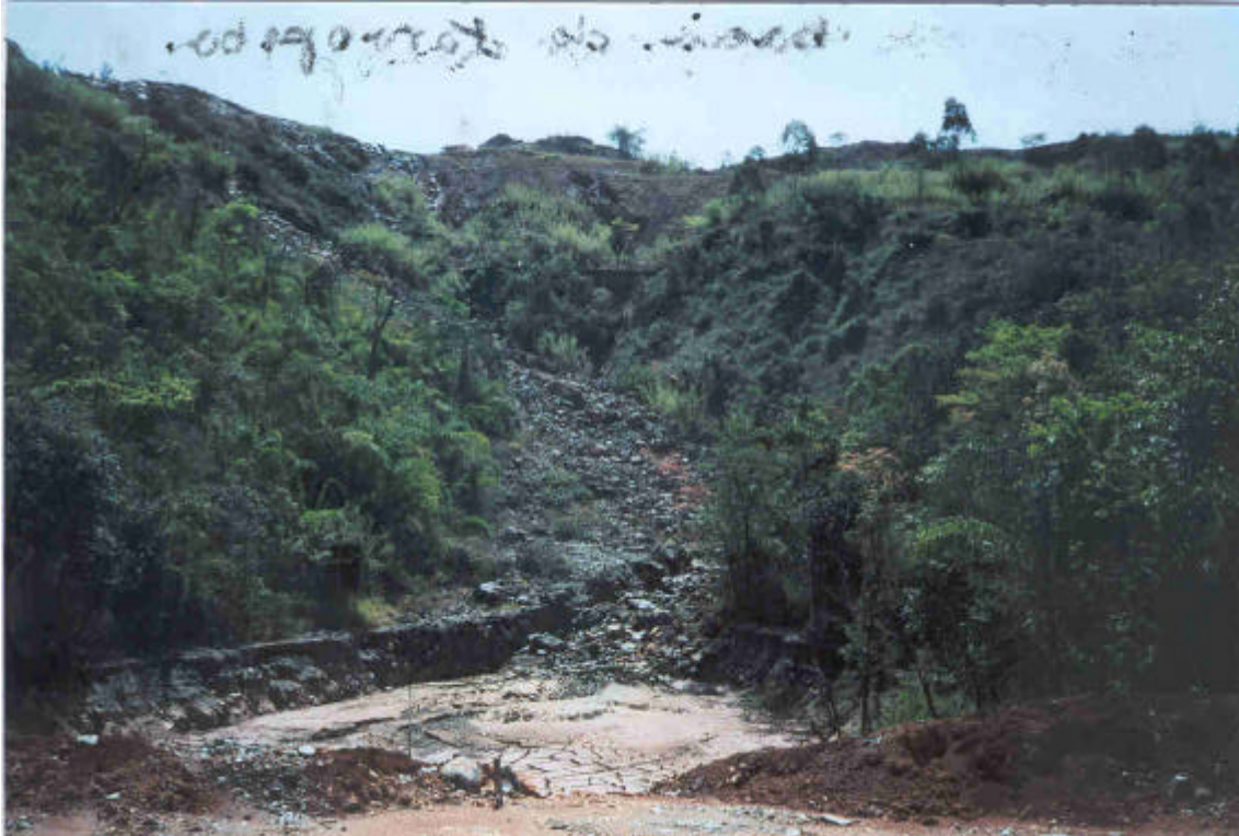
VISTA DA BARRAGEM DE CONTENÇÃO DE FINOS DE PEDRAS CONGONHAS
