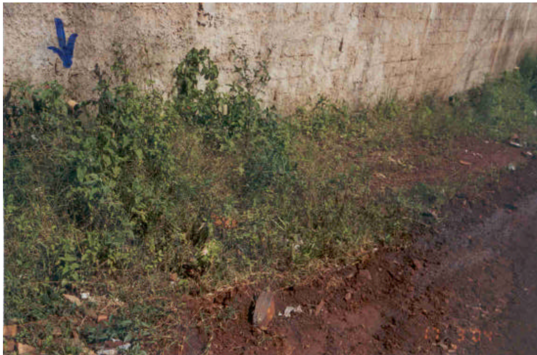
VISTA DO PONTO DE LANÇAMENTO DE ESGOTO EM JARDIM CANADÁ –UTM-E:606135/UTM-N:7781560
