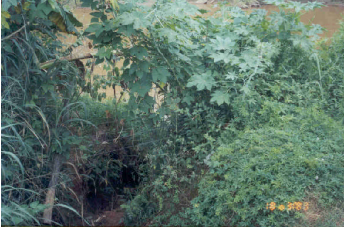
VISTA DO PONTO DE LANÇAMENTO NO RIO CONCEIÇÃO
