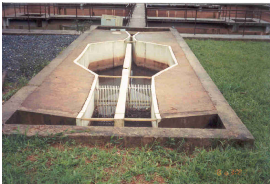
VISTA DA ESTAÇÃO DE TRATAMENTO DE ESGOTO DO Condomínio Alphaville
