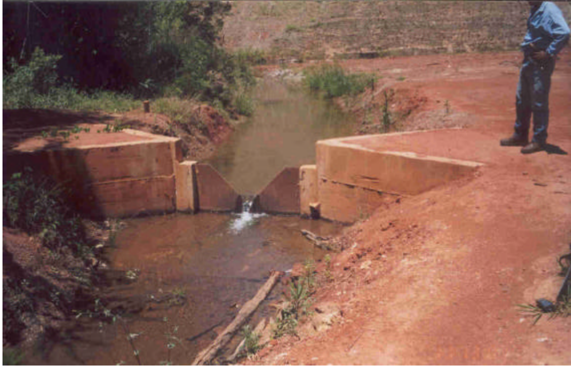
VISTA DO VERTEADOR DO DRENO DE FUNDO DA BARRAGEM MORRO VELHO
