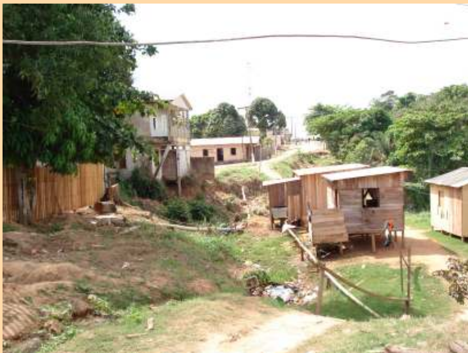
Fotografia 13: Detalhe de desmoronamento na Rua Rio Grande do Sul. Observa-se ao fundo parte da rua destruída, comprometimento de construção de alvenaria e terreno em movimentação sendo ocupado por construções de madeira.
