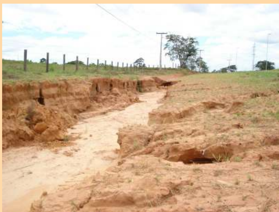
Fotografia 18: Erosão em solo arenoso, obra de abertura do anel viário, localidade do Amapá, AL-07.
