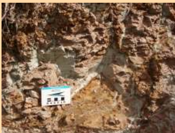
Fotografia 06: Contato entre siltito castanho amarelado e argilito cinza em corte de estrada próximo da terceira ponte, destacando padrão de fraturamento.
