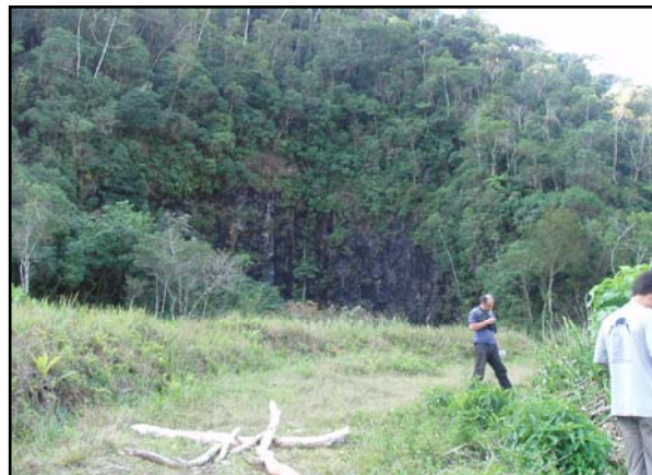
Figura 6.21: Vegetação avançando sobre frente de pedreira paralisada, Angra dos Reis - RJ.
