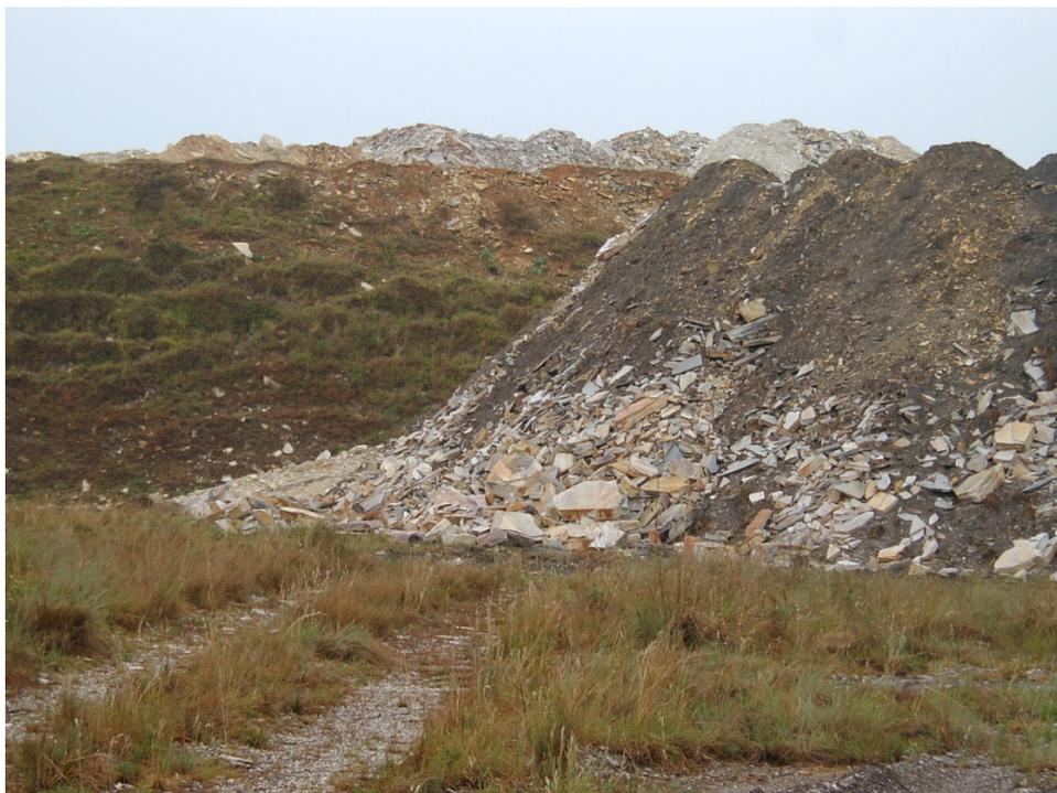
**Figura 6.7:** Talude de pilha de rejeito revegetado (a esquerda). Recobrimento do talude com o solo anteriormente decapeado.
