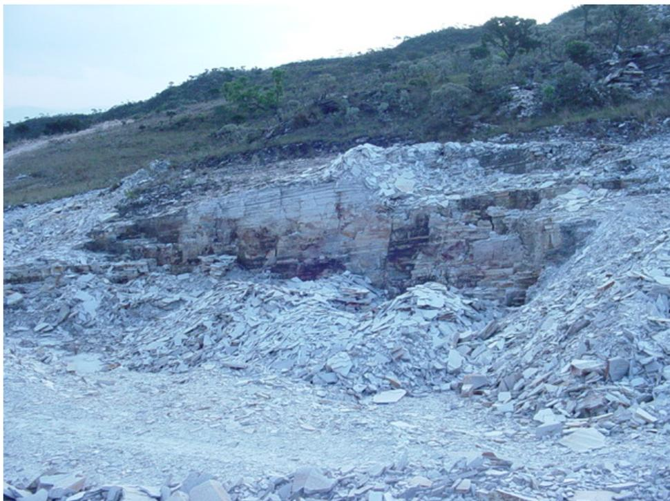
**Figura 6.10:** Aterro de frente de pedreira desativada utilizando-se os rejeitos da mineração.
