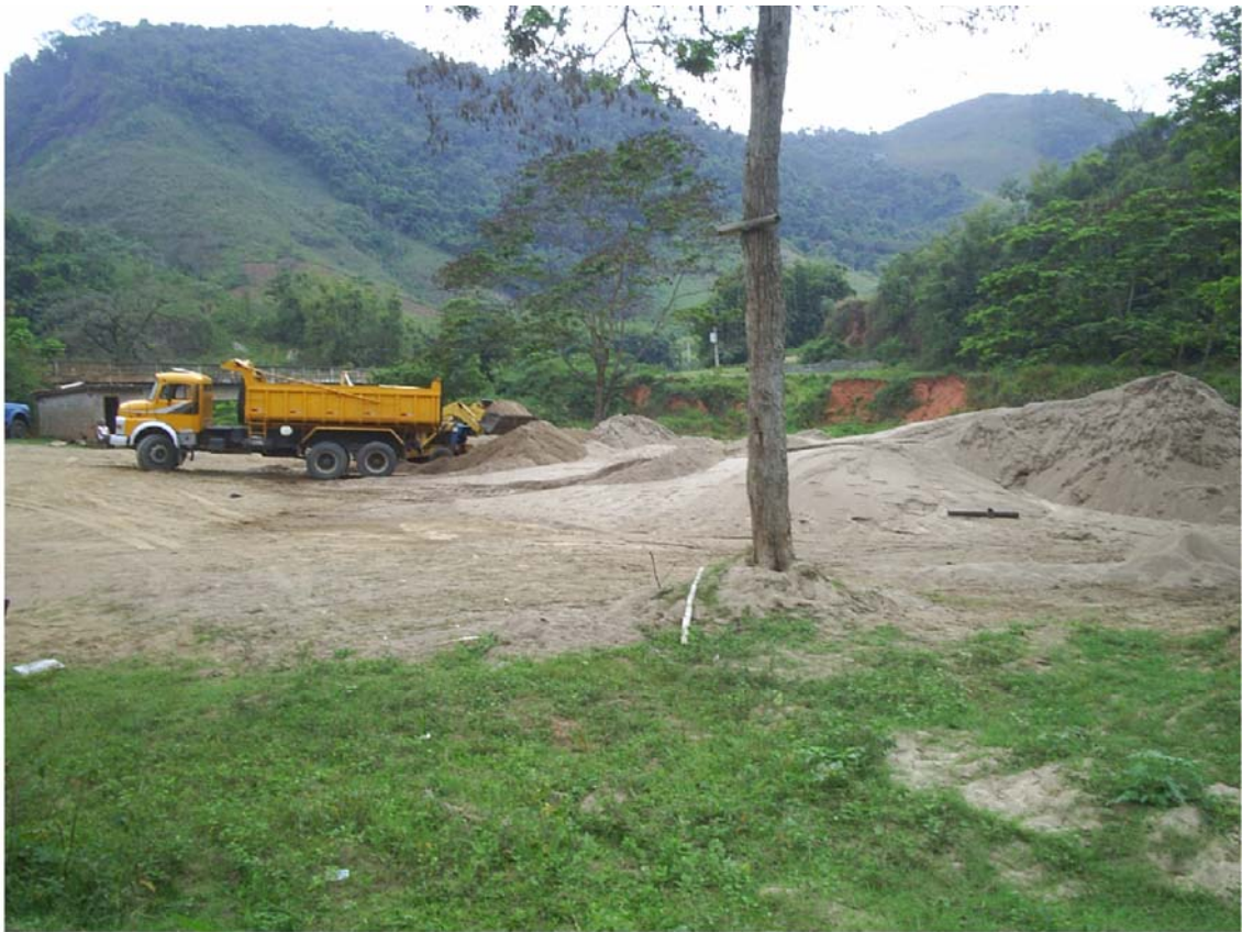
Figura 6.5- Caminhões sendo carregados por areia retirada por draga do leito do Rio Preto, MG. Ao fundo pode ser observado erosão do terraço.
