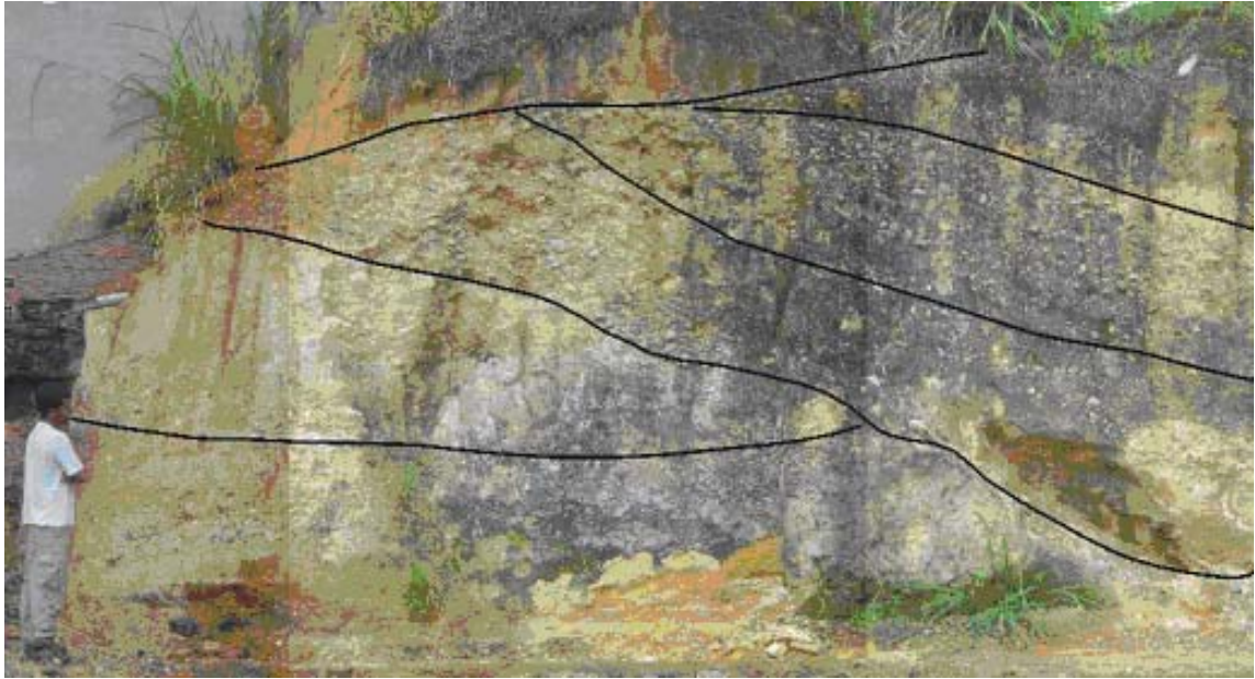
Figura 5.16: Seção representativa da Formação Ribeirão dos Quatis. Notar superfícies indicando reativações de barras de cascalhos no sistema fluvial. Ponto V-91, localizado no final da Rua A (UTM: 0595004/7509892), bairro Belmonte, município de Volta Redonda.
