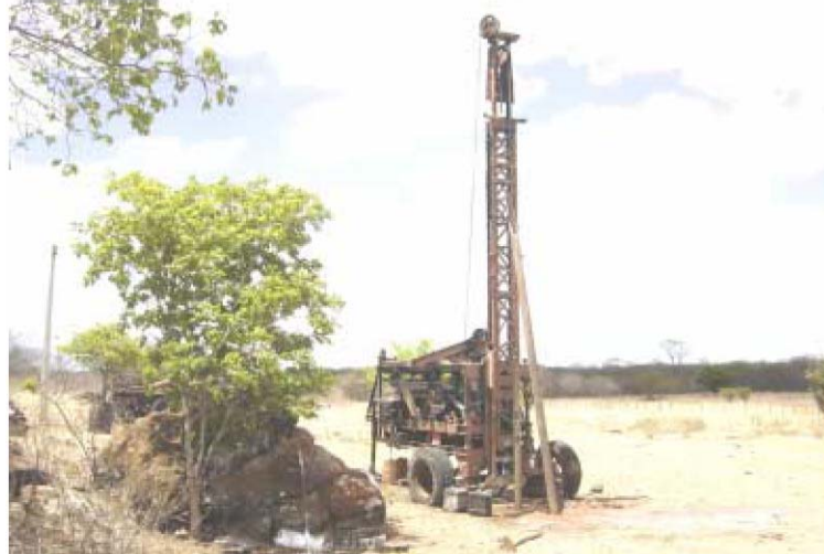
Foto 4.2.10 - Detalhe da perfuratriz percussora. Poço Santo Antônio
