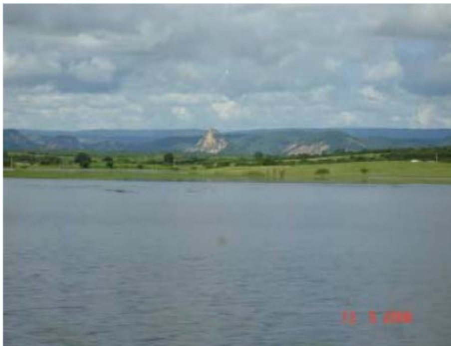
Foto 5.2.5 – Vista do reservatório do Açude Pilões. A jusante observase o cultivo de arroz irrigado por estas águas.
