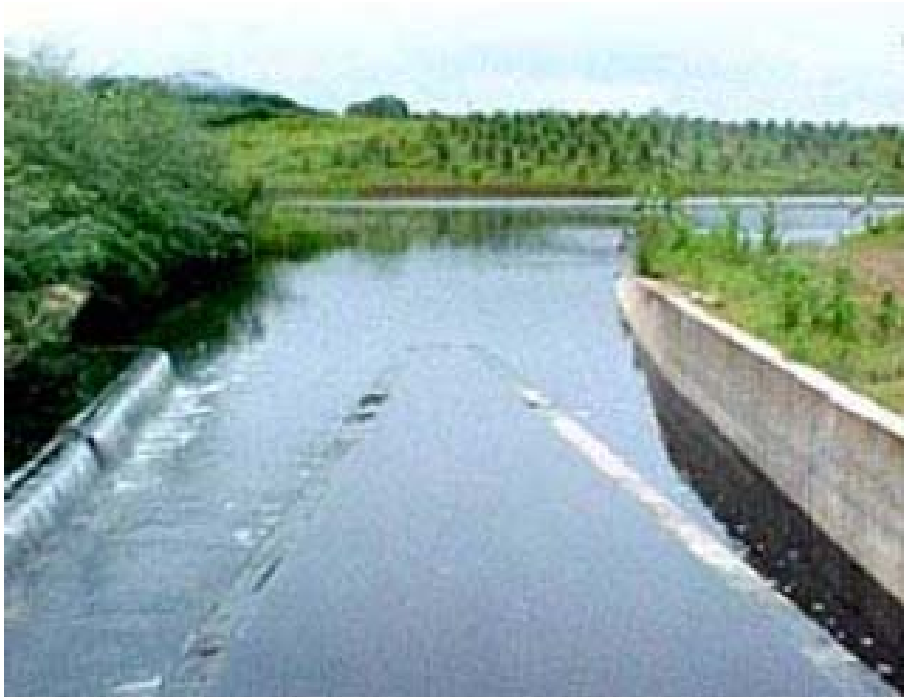
Foto 5.2.2 – Vista da Barragem de Compensação. Projeto Várzeas de Sousa.
