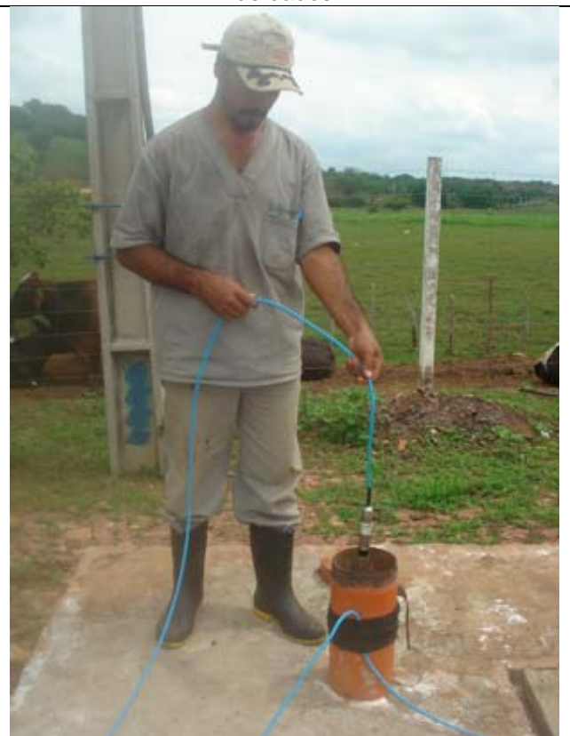
Detalhe do sensor do medidor de nível piezométrico
