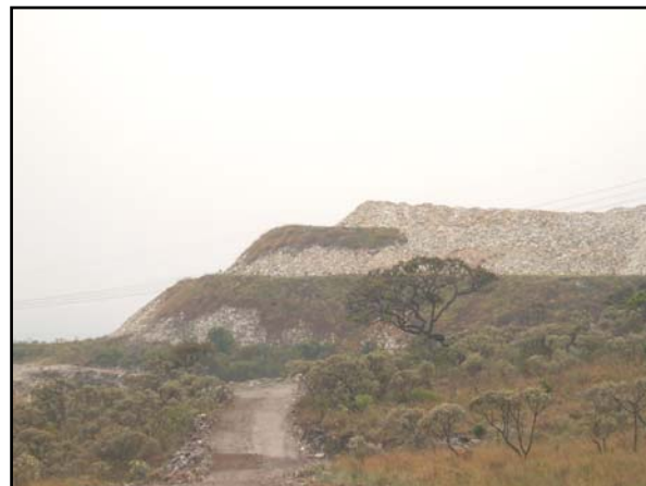
Figura 6.6: Revegetação induzida em pilha de rejeito da Mineração PR Pedras, na serra de Alpinópolis.
