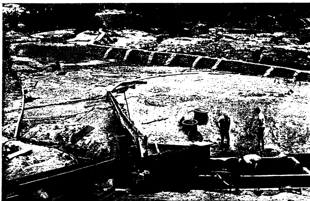
FOTO 23 - Vista da bacia de rejeitos oriundos da lavagem do cascalho. Após a concentração do cascalho através de um jigg tipo Yuba, (em primeiro plano), o concentrado era enviado para tanques onde garimpeiros procediam a recuperação final do diamante através de peneiras.
