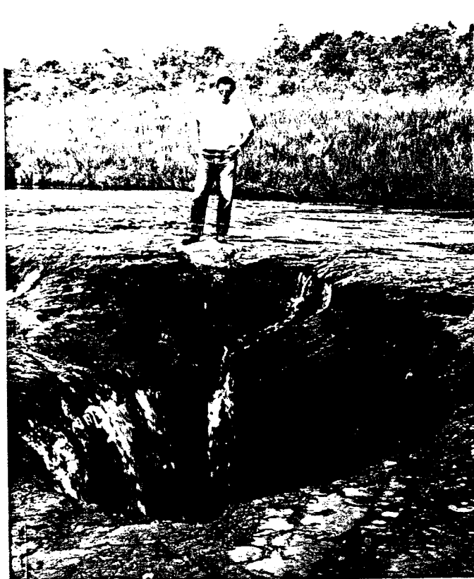
FOTO 6 - Detalhe de um sumidouro formado por aprofundamento de uma marmitta até atingir um nível de disjunção, por onde a água escapa. Rio do Lajeado, a montante ao ponto anterior.
