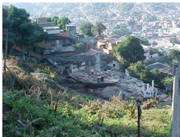
Figuras 8.5 e 8.6 - Vistas de jusante e de montante do deslizamento do matacão rochoso, que causou 6 mortes, na Engenhoca, em 2003 (fotos do autor)
