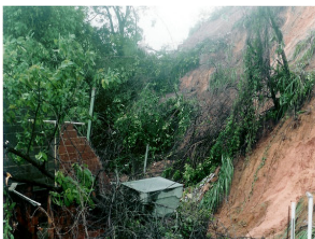
Figuras 8.10 e 8.11 - Detalhe da crista e dos danos associados ao deslizamento de solo no talude remanescente da atividade de saibreira em Magé, baixada fluminense
