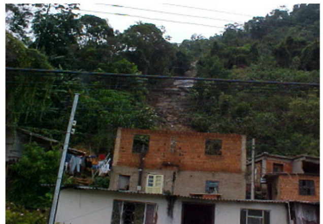
Figura 8.14 - Vistas frontais de um típico deslizamento raso de Petrópolis em 2001. A capa delgada de solo desliza e mobiliza o horizonte de rocha muito fraturada. O conjunto de detritos segue sob a forma de corrida e atinge as casas situadas ao pé dos taludes íngremes
