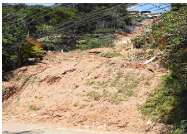
Figura 8.15 - Vista do escorregamento, ocorrido em fevereiro de 2008, que destruiu duas casas e causou a obstrução de uma via interna de um condomínio em Petrópolis (foto do autor).
