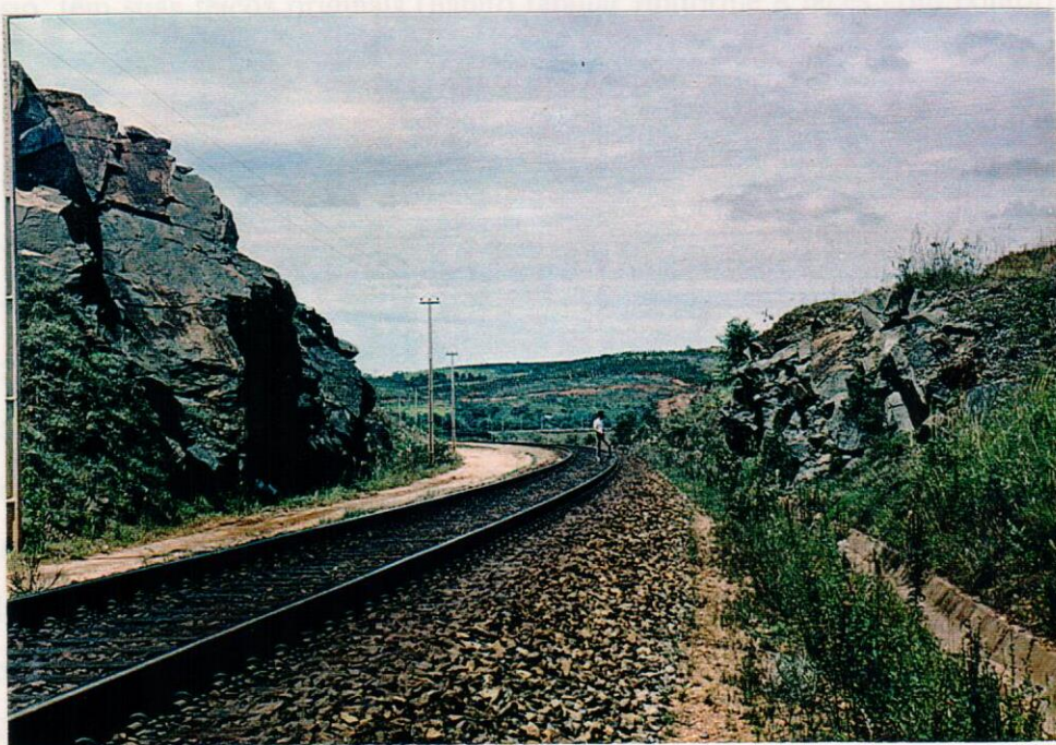
Fotografia 15 - Foto panorâmica do único afloramento onde a rocha metagabroica não ocorre na forma de blocos soltos. Corte da Ferrovia do Aço, localizado na parte NNE da área mapeada. Ponto MJ-01.
