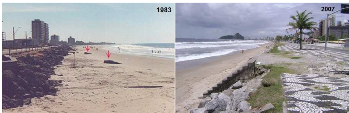
Figura 6: À esquerda os efeitos da erosão na praia Brava até o ano de 1983, depois da rápida ocupação desta área, e os espigões colocados na praia – indicados pelas flechas (Fonte: http://www.netpar.com.br/lindroth ). À direita o estado da praia no ano de 2007.
