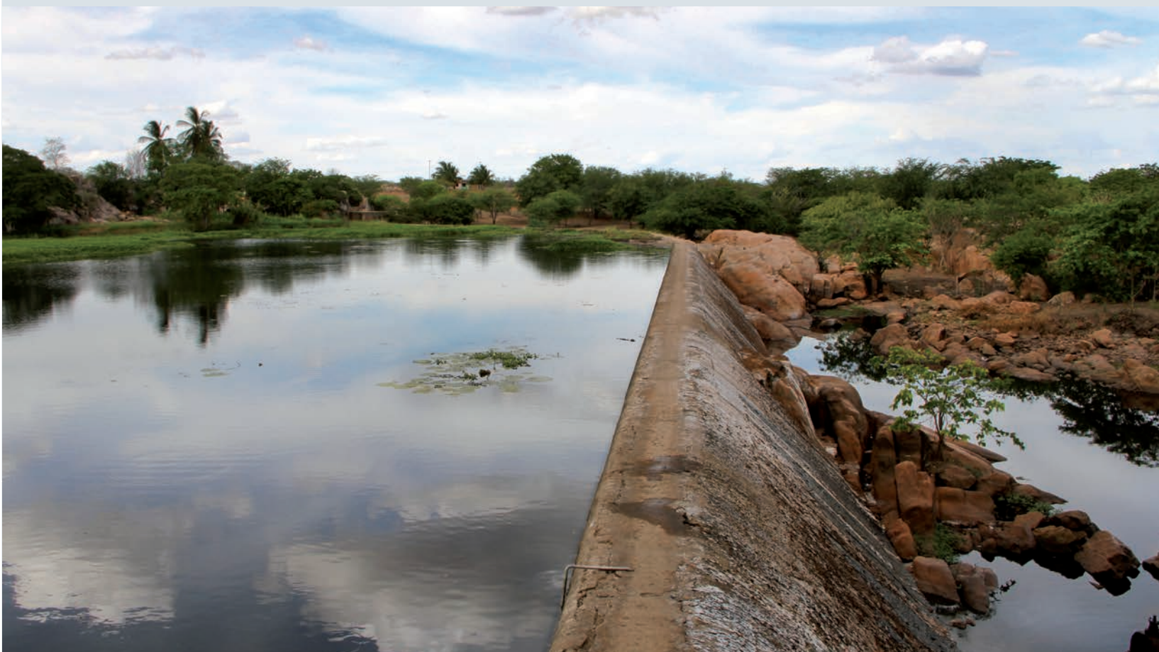
Açude de Queimadas, Rio Itapicuru. Talude de Jusante
