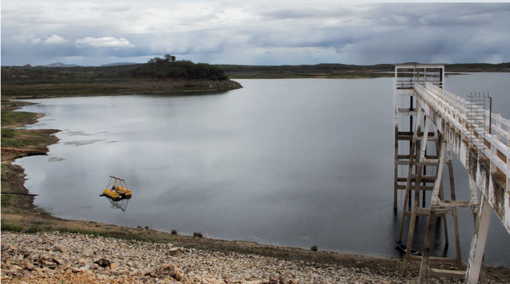
Torre da tomada d'água do reservatório Cocorobó Bacia do rio Vaza Barris
