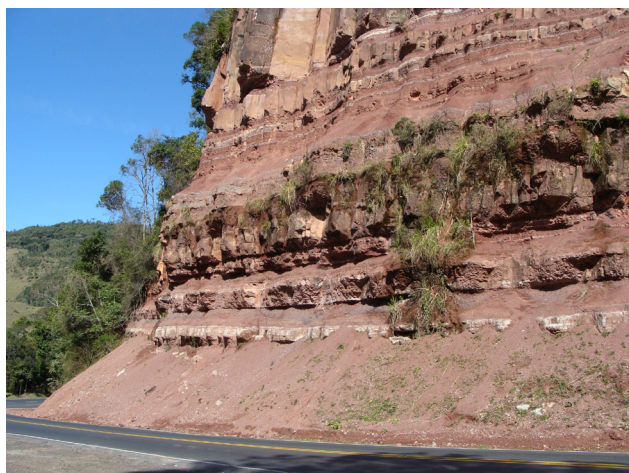
Figura 4.25 - Intercalações de camadas areníticas e sílticas consolidadas e fraturadas na BR-116 em Monte Castelo.
