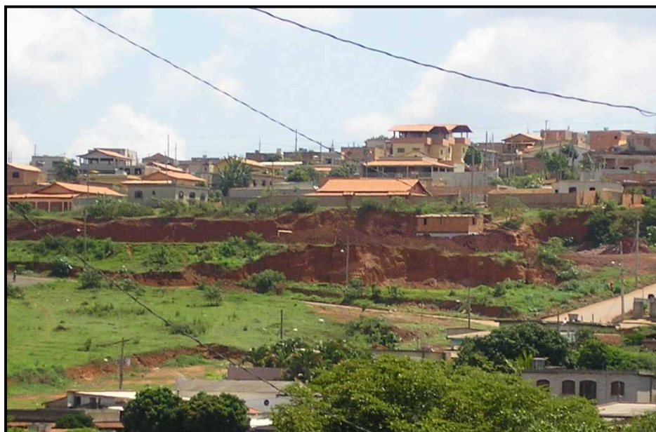
Figura 29 – Casas localizadas em encostas, em área de risco de desabamento.
