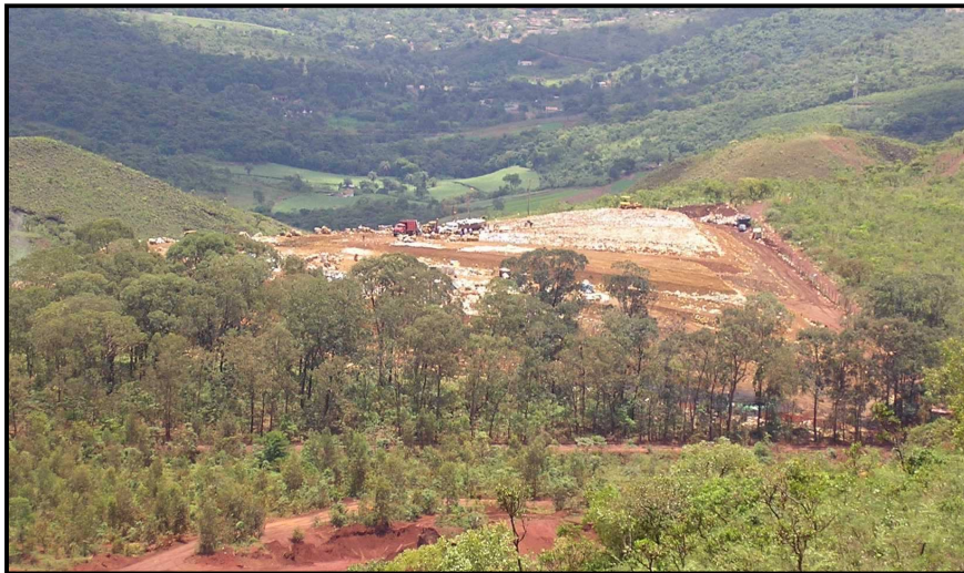
Figura 32 – Área de despejo do lixo urbano de Ibitité, localizado na porção sul do município..
