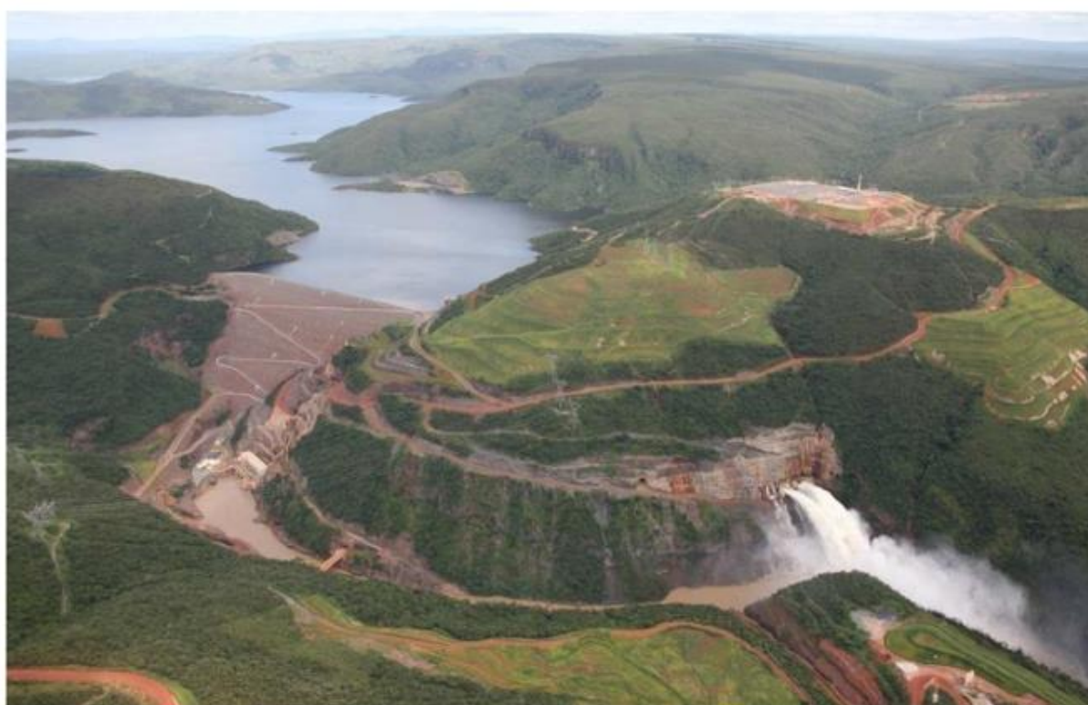
Figura 3: Fotografia da UHE de Irapé em funcionamento com comportas do vertedouro abertas (fotografia: Ana Luiza Lima, 2009).
