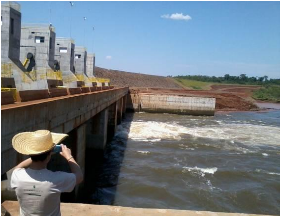
Figura 16 – Perda de oxigênio dissolvido à jusante do barramento da UHE Passo do São João.
