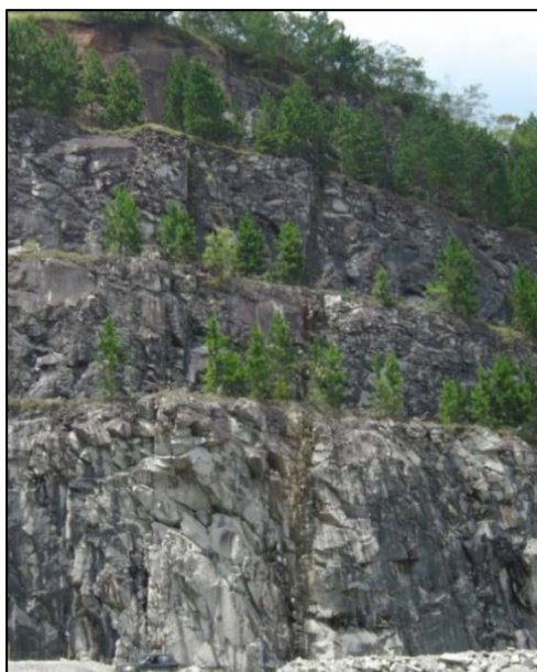
Figura 37 - GS-3, ponto U: zona de fratura do grupo NW (atitude média 58/90); notar os traços retilíneos e a grande continuidade (ocorre continuamente nas quatro bancadas visíveis neste local da pedra)
