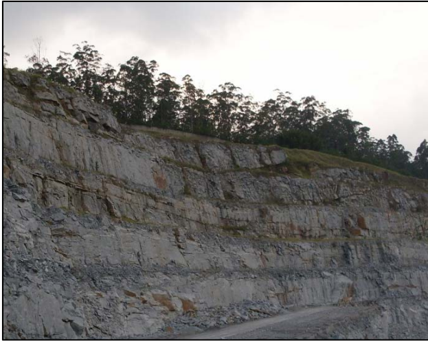
Figura 42 - GS-1, próximo à SL6: fraturas de sub-horizontais bastante contínuas, que alcançam dezenas de metros de comprimento, suavemente onduladas
