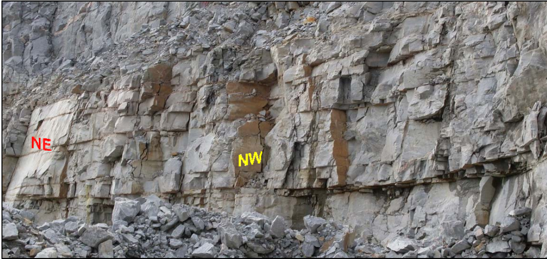
Figura 50 - GS-1, próximo ao ponto B: fraturas de direção NW subverticais terminam nas fraturas de baixo ângulo da GS-1, indicando que as fraturas NW são mais jovens (notar alteração ocre das fraturas NW, e fratura NE de alto ângulo, no canto esquerdo da foto, quase sem alteração)
