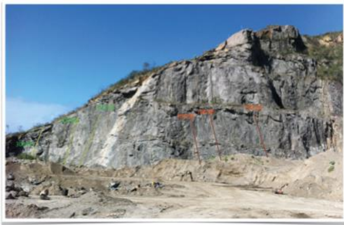
Figura 10 - Vista da frente da pedreira Cispel e algumas fraturas tectônicas marcadas
