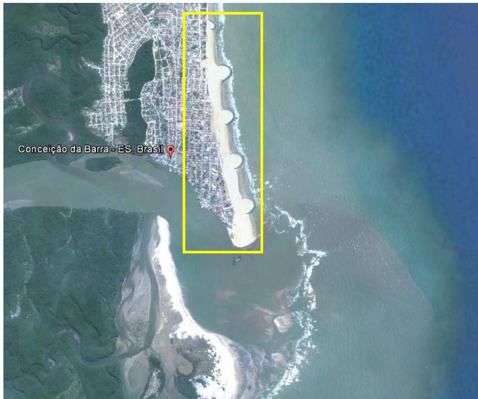
Figura 42 – Obras de contenção de erosão costeira, com estruturas de enrocamento circular, visando ao acúmulo de sedimentos. Conceição da Barra, foz do rio São Mateus, Espírito Santo (ES).
