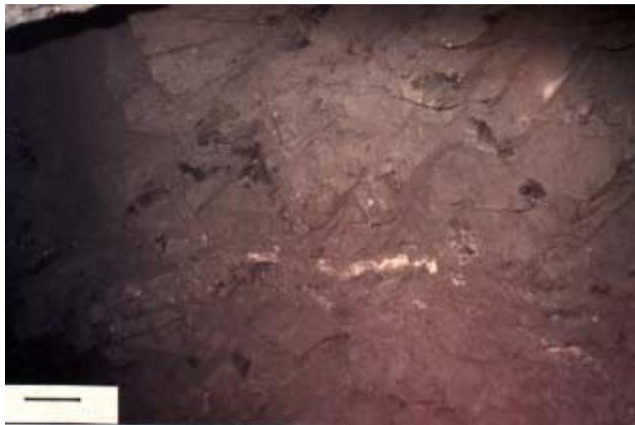
Figura 2.8: Vista da galeria escavada no microtonalito Caxias, mostrando as venulações irregulares de quartzo, subverticais (foto superior) e subhorizontais (foto inferior). Comprimento da barra: 30 cm.
