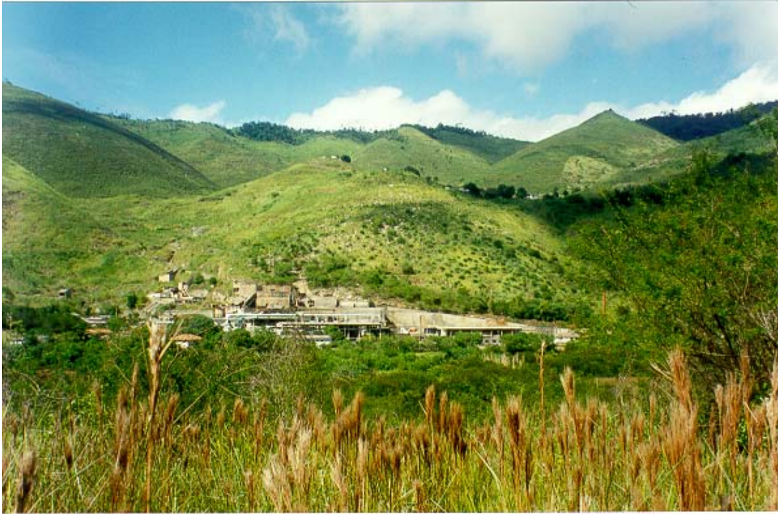
Foto 8: Vista da usina de refino Plumbum Mineração e Metalurgia S.A., já desativada
