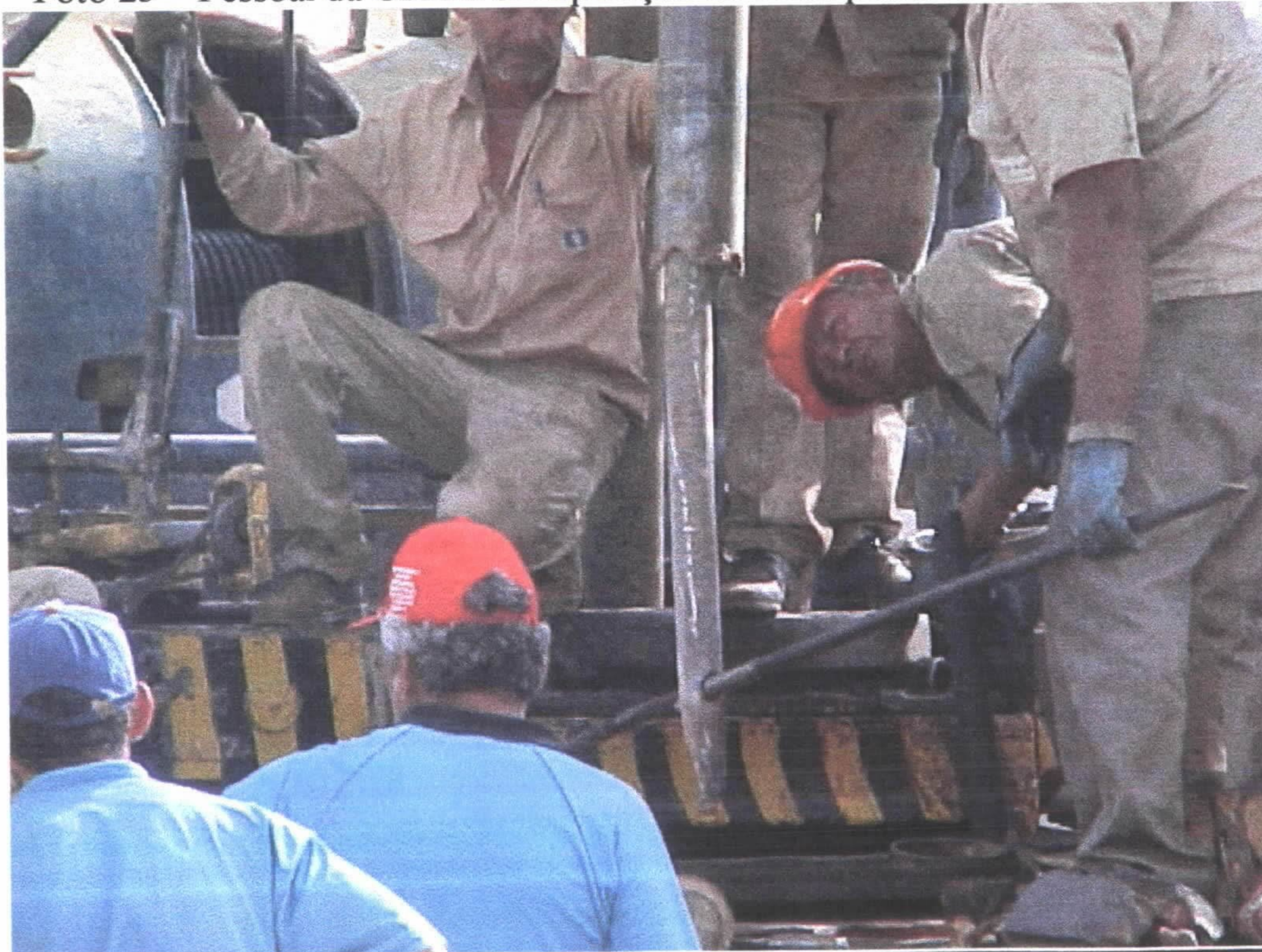
Foto 23 – Pessoal da CPRM em operação de corte/pescaria da bomba/tubos
