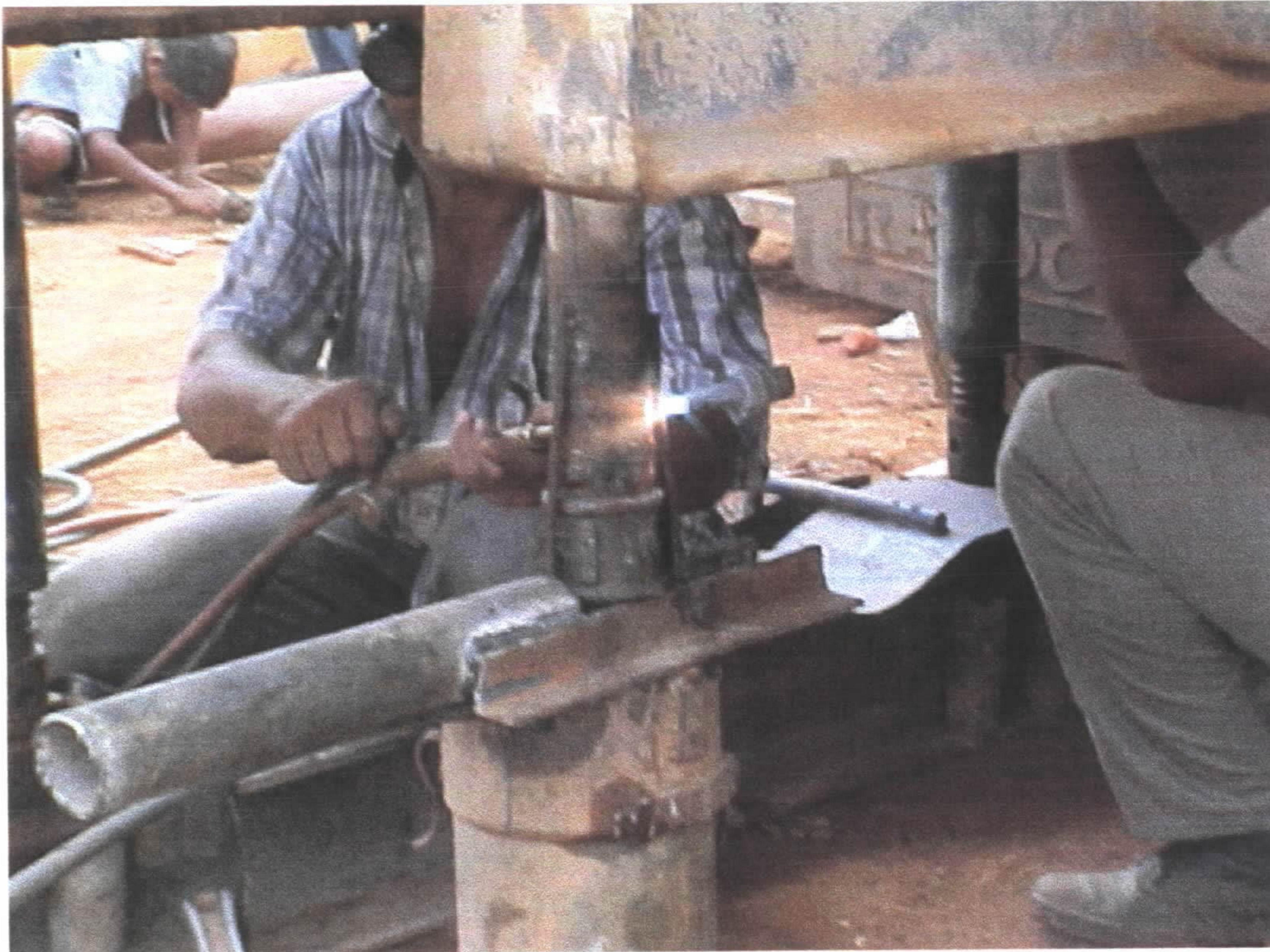
Foto 16 – Retirada da bomba existente (soldador em operação)
