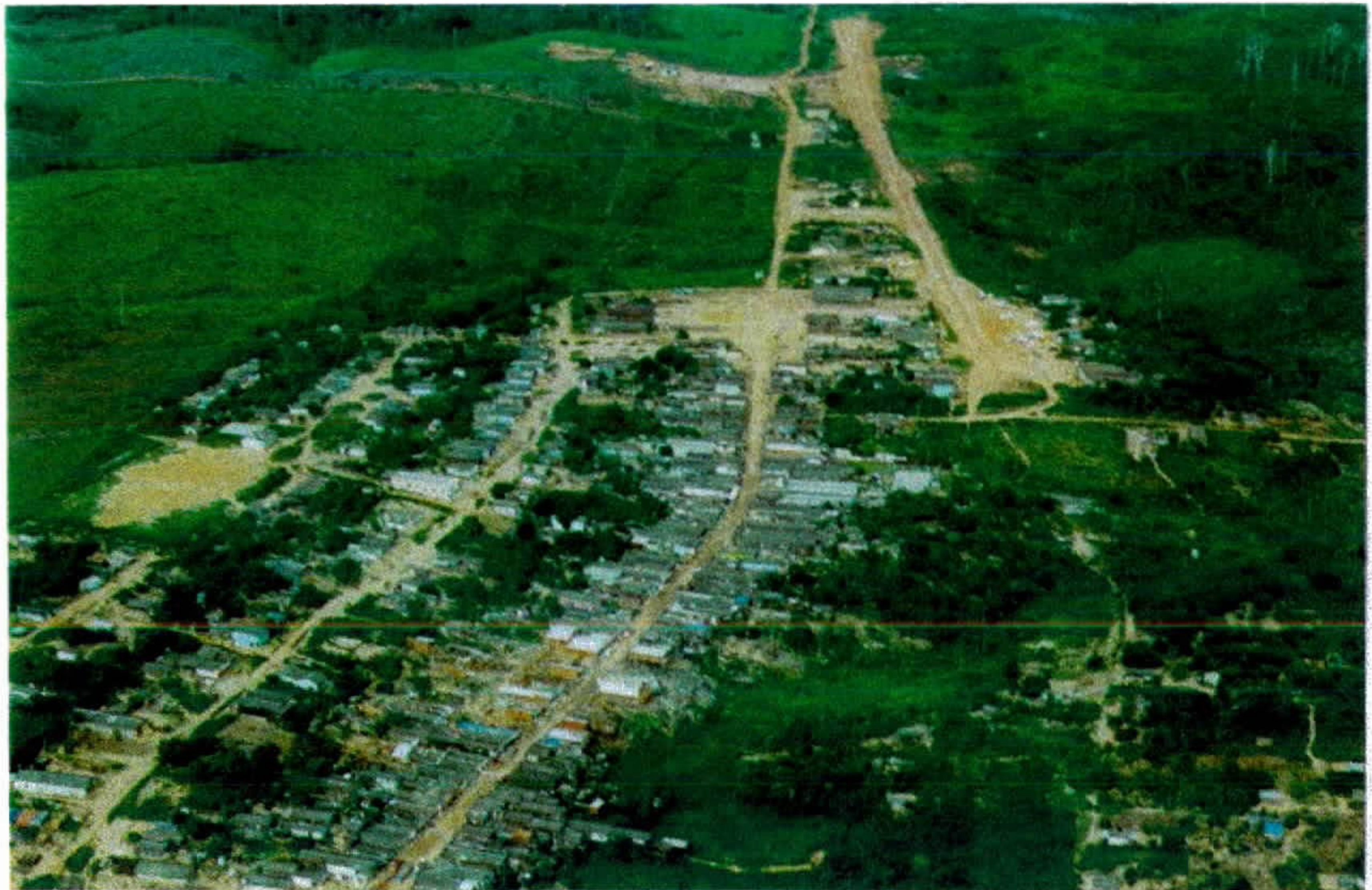
Figura 2.3 – Vila do Creporizão, Província Mineral do Tapajós, onde está localizada a base de campo da CPRM, para apoio aos trabalhos de mapeamento geológico, estudos de prospectos e ambientais.
