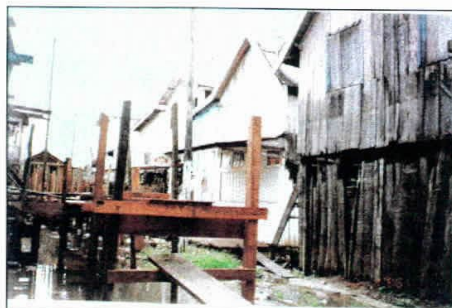
Foto 8 - Água no Beco Cota 26.41 m - 07/04/96
