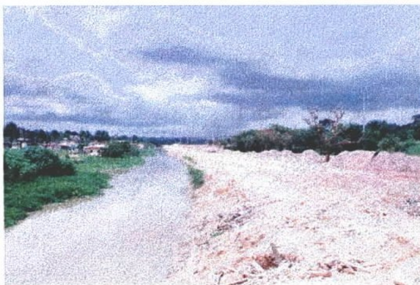
Foto 48 - Abertura da Rua Cota 24.31 m - 28/02/96
