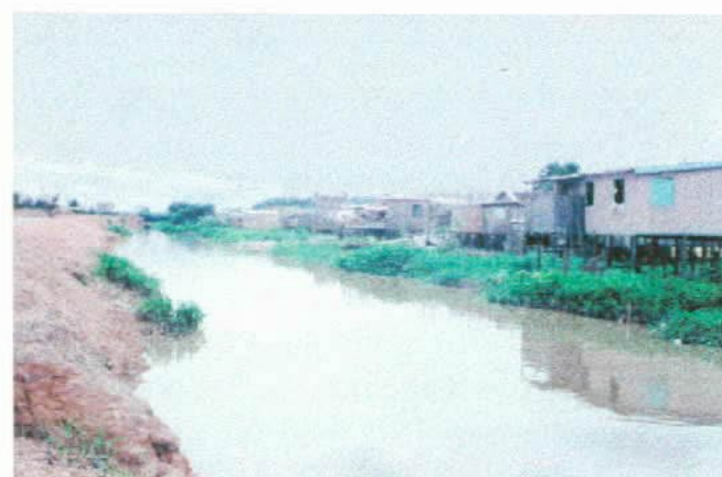
Foto 46 - Comunidade Beneficiada Cota 24.31 m - 28/02/96
