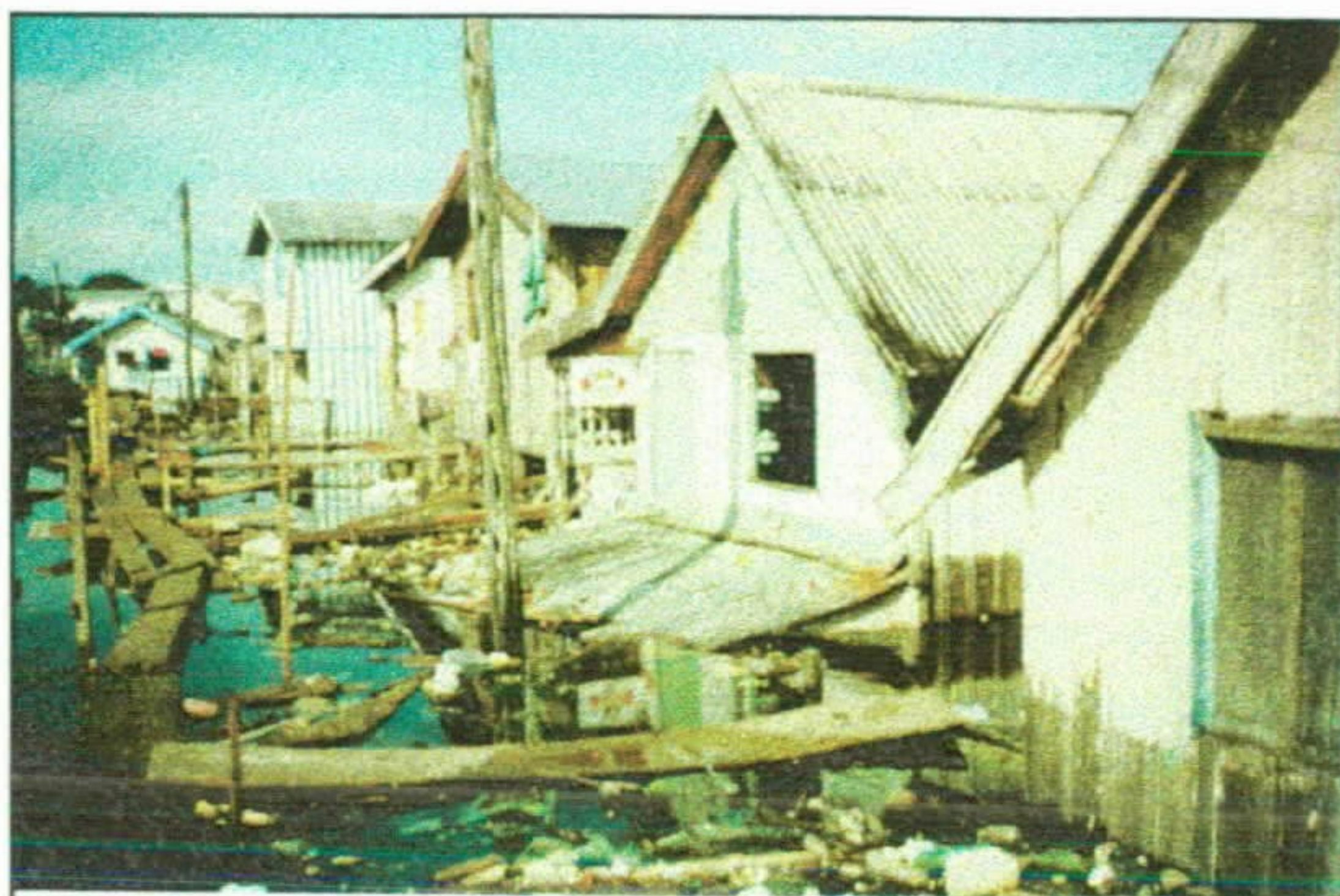
Foto 7 - Avanço das Águas no (2º Piso) Cota 29.05 m - 26/06/94
