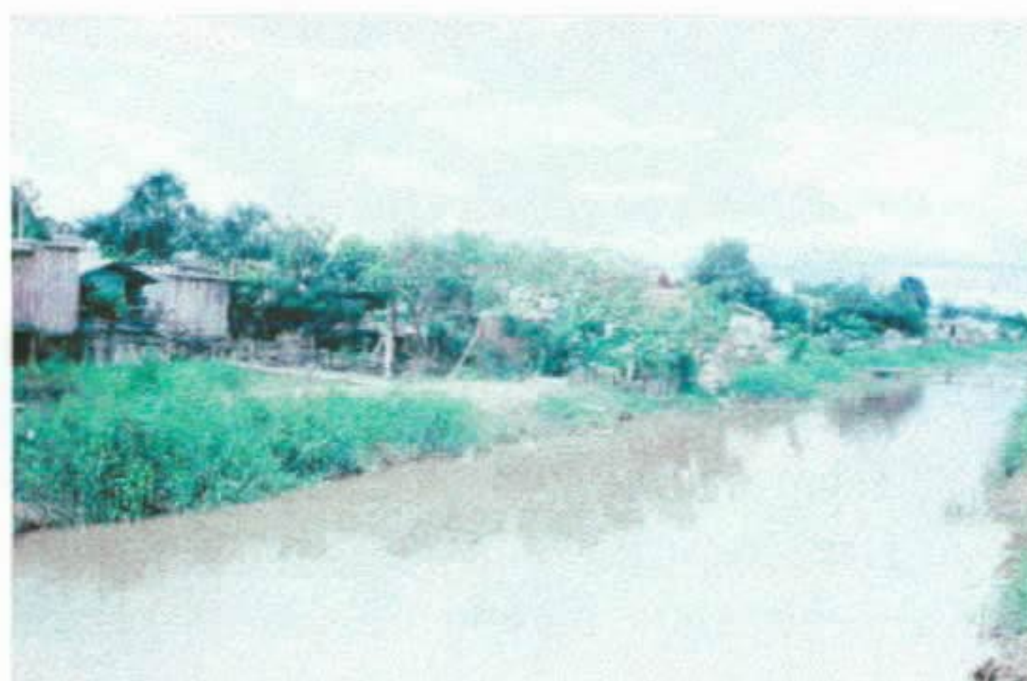
Foto 45 - Trecho Beneficiado (Japiim) Cota 24.31 m - 28/02/96
