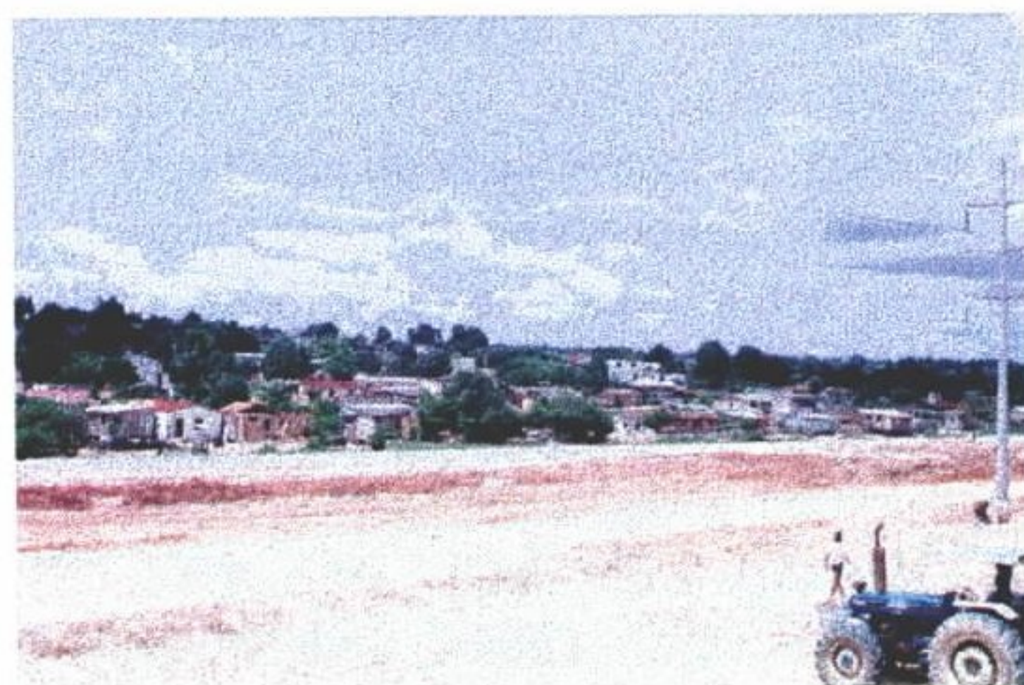
Foto 51 - Área em Obras Cota 24.31 m - 28/02/96
