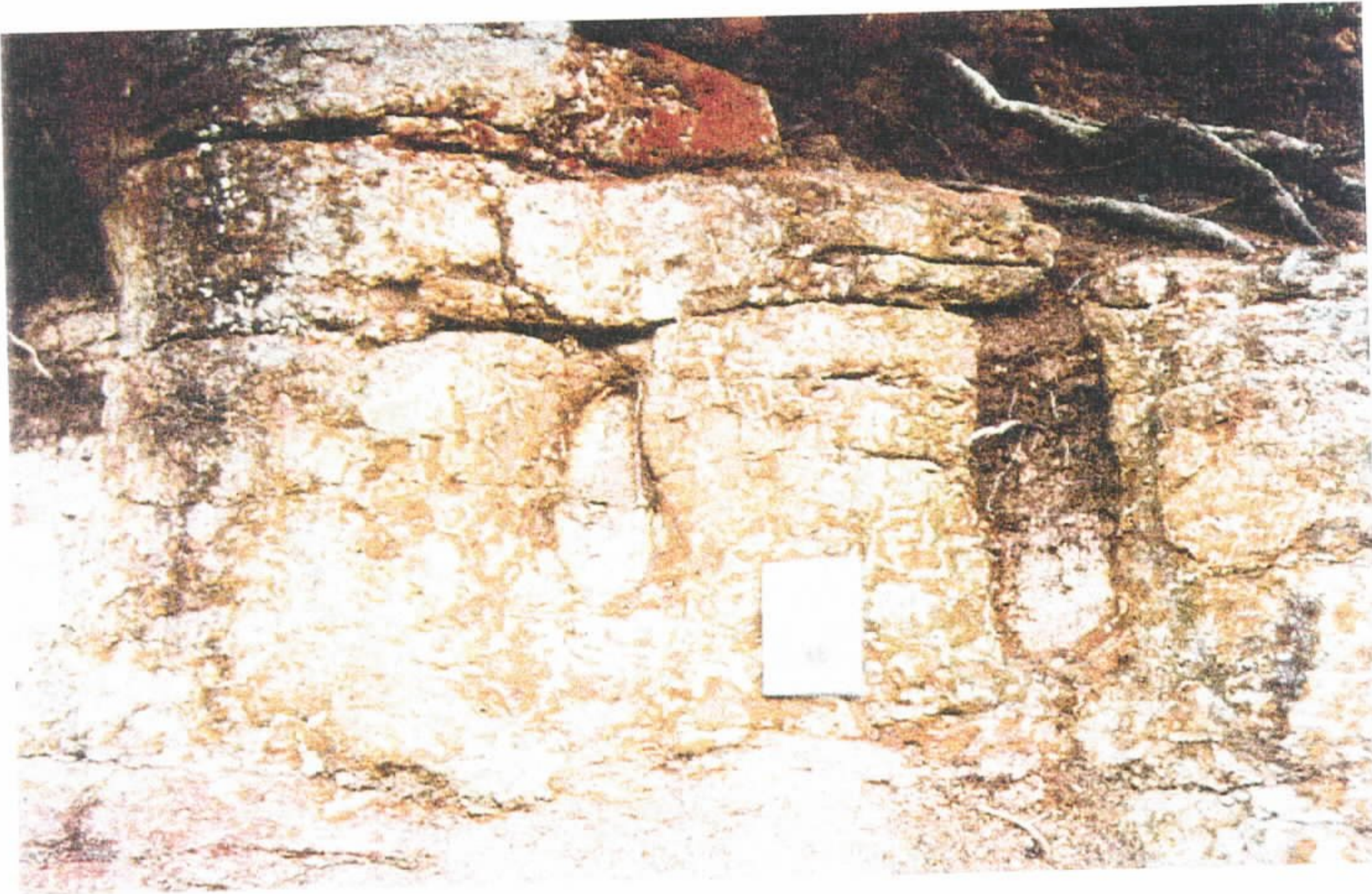
Foto 10 - Colunas constituídas por arenito ferruginizado, de aspecto mosqueado e cor ocre-avermelhada. Observa-se relictos de arenito não ferruginizado, contidos entre colunas soldadas.
