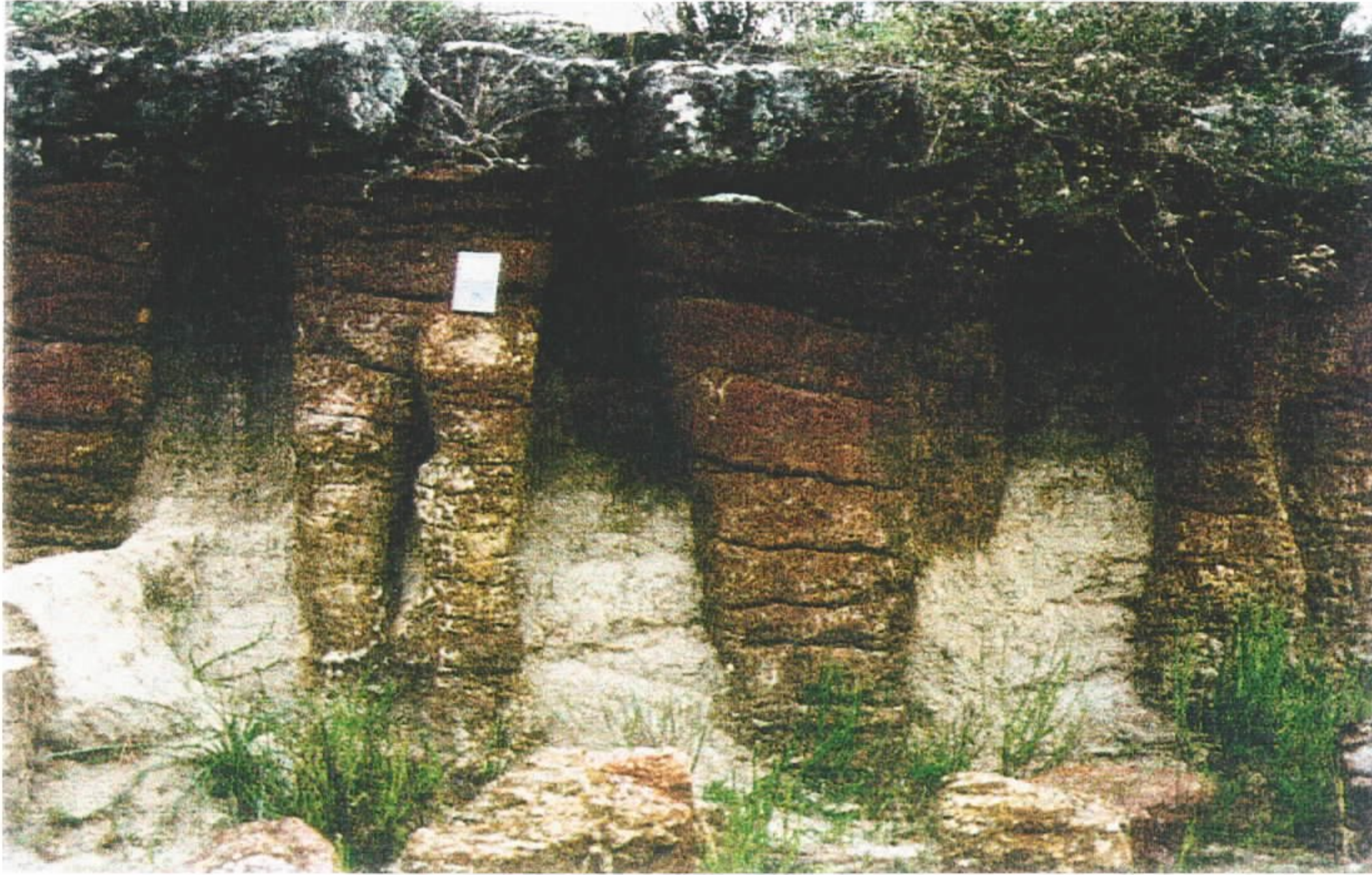
Foto 02 - Colunas de arenito ferruginizado, pertencente à zona esferulítica do horizonte concrecionário de perfil laterítico imaturo, fraturadas segundo o acamamento. O arenito intercolunas é mais argiloso e não se apresenta ferruginizado.
