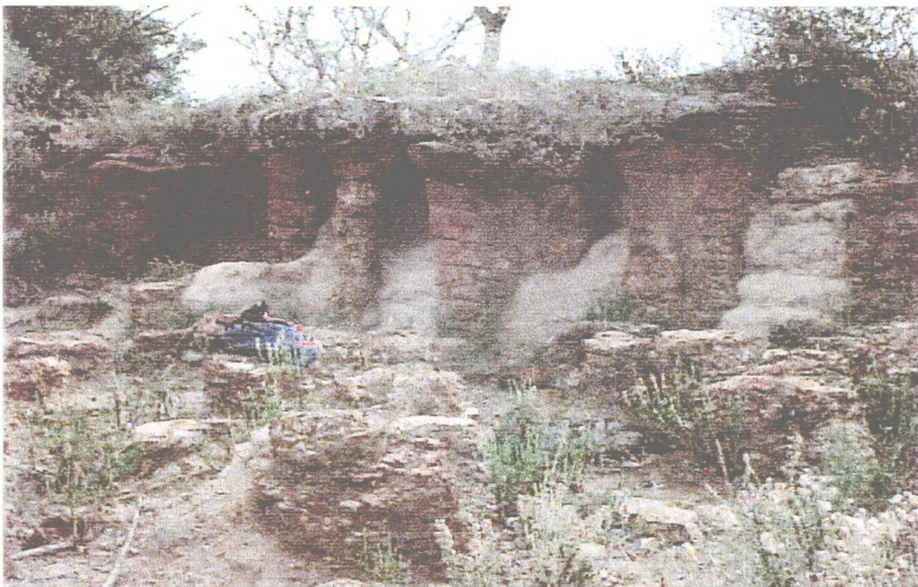
Foto 13 - Início do processo de esvaziamento dos trechos preenchidos pelo material arenítico friável entre colunas. Note-se o princípio de carreamento do material rumo às porções inferiores da gruta, e no primeiro plano, restos "in loco" de porções basais dessas colunas. Na porção superior, é possível perceber crostas lateríticas (carapaças) sobre tais colunas, variando em torno de 60 a 80cm de espessura.
