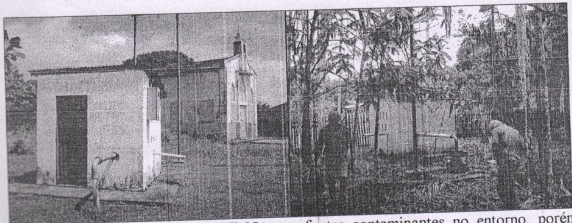
Figura 2 – Vista dos terrenos onde estão situados os poços PT-05, no centro da cidade (esquerda), e PT-07, no bairro São Francisco (direita), ambos sem nenhuma cerca nem muro de proteção.
