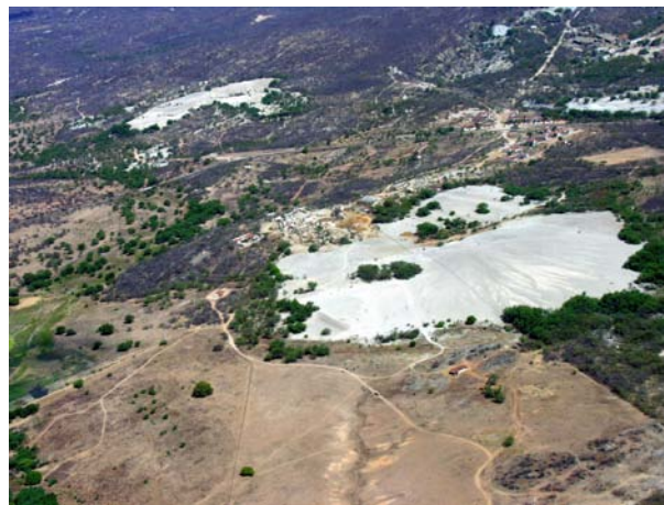
Figura 52 – Vista aérea do Parque Temático da Mina Brejuí e o depósito de acúmulo de rejeitos da mina (em primeiro plano). Foto: R. Diniz.
