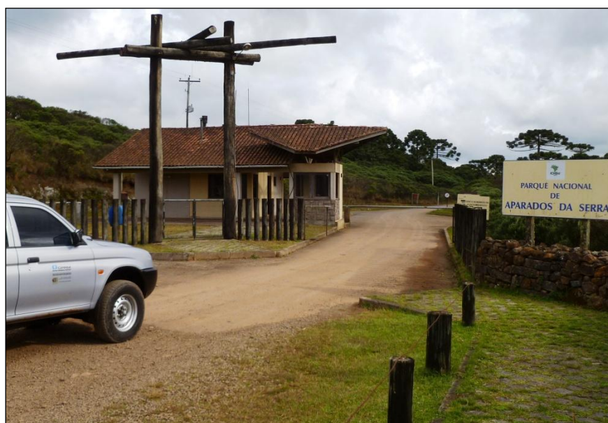
Figura 9: Pórtico de entrada do Parque Nacional de Aparados da Serra no Cânion Itaimbezinho.
