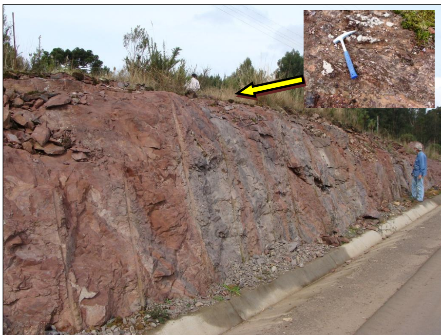
Figura 95: O geossítio Ácidas de Cambará possui alternância de cores que deixam em evidência as estruturas de fluxo. No detalhe, o afloramento visto em planta com linhas de fluxo preservadas.
