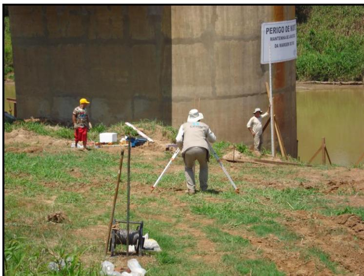
**Foto 7 – Instalação da estação fluviométrica na área de captação da ETA II.**
