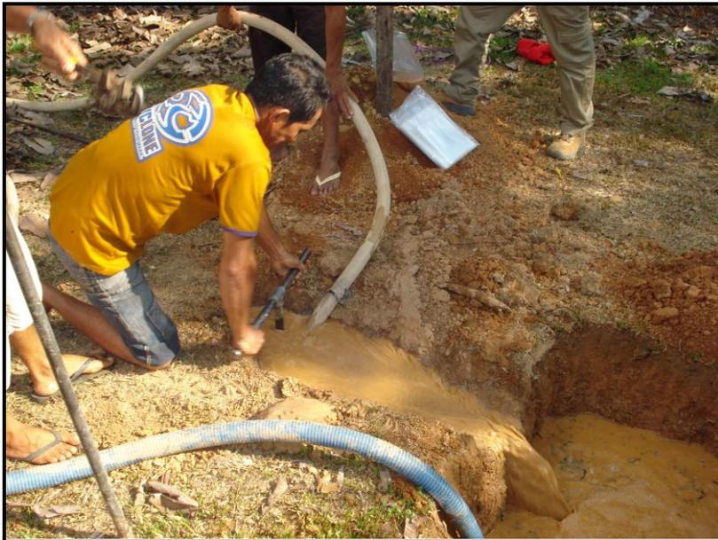
**Foto 9 – Construção de poço tubular raso com trado manual no 2º Distrito de Rio Branco.**
