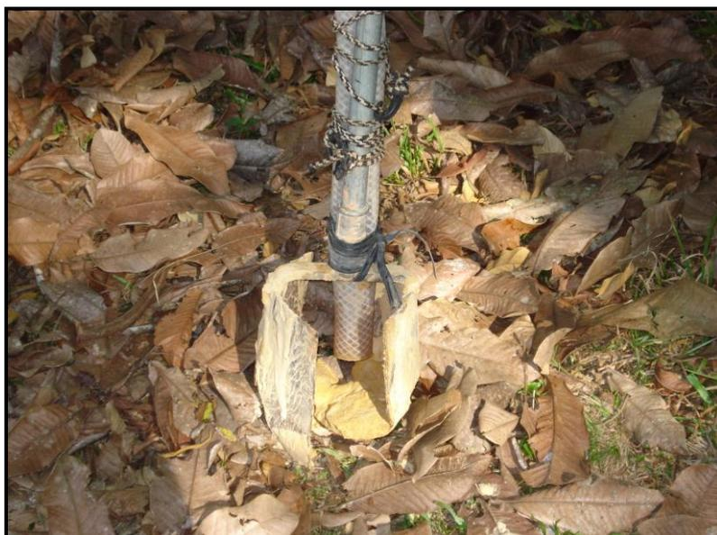
**Foto 10 – Detalhe do trado manual utilizado para a construção de poço tubular raso no 2º Distrito de Rio Branco.**
