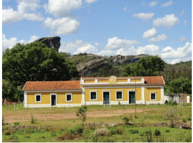
Foto 8.26 – Antigua sede de hacienda hoy utilizada como un hotel y vista de la formación geológica Morro de la Cruz.
