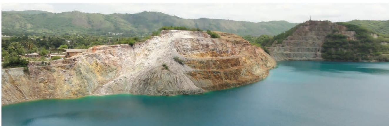
Foto 8.73 – Detalhes das encostas da antiga Mina El Cobre.
