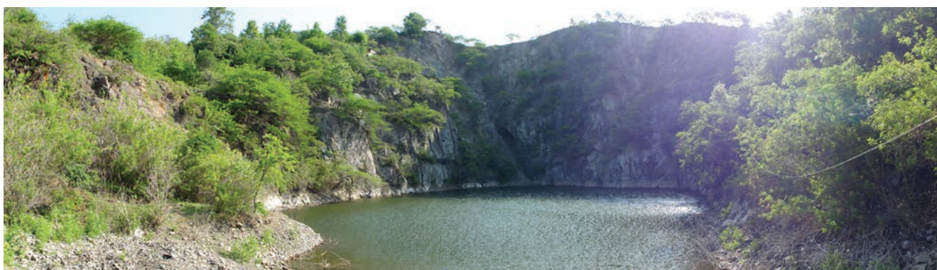
Foto 8.80 – Vista panorâmica da cava inundada da Mina El Cuero.
