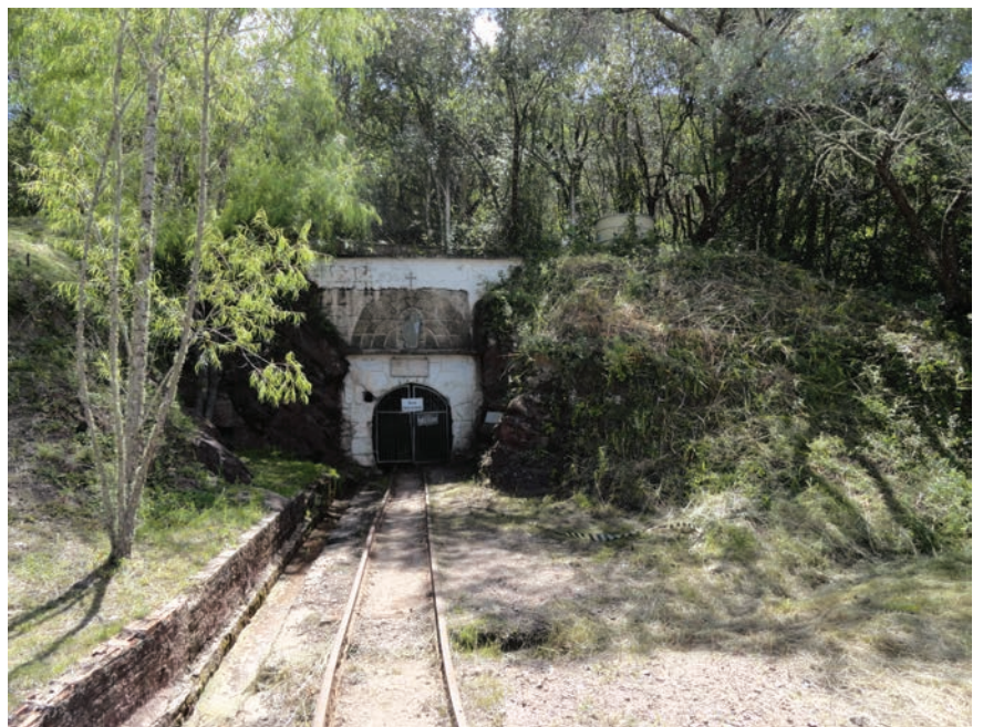
Foto 8.33 – Entrada da galeria dos ingleses.
