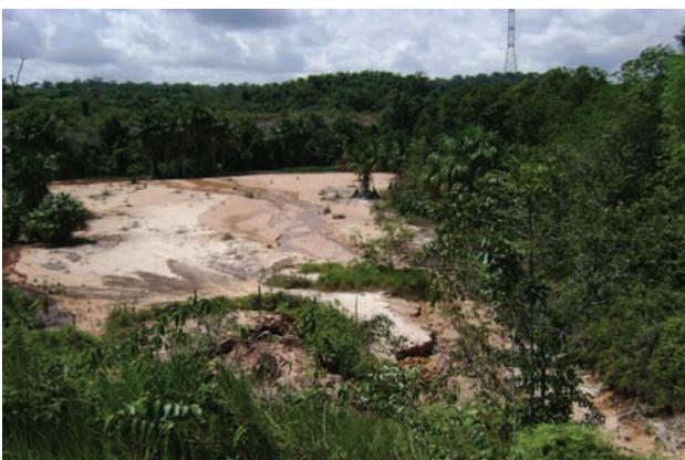
**Figura 7.24** - Assoreamento de drenagem às margens da BR-174 (Km 24).
