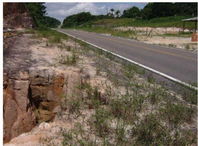
**Figura 13.30b** - Risco geológico: processo de voçorocamento ameaçando o pavimento da rodovia BR-174 (Manaus, AM).
