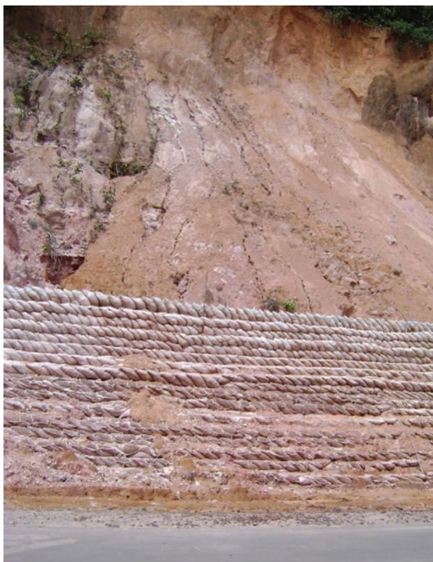
**Figura 13.30c** - Risco geológico: estabilização de processos de ravinamento e movimentos de massa em corte de estrada em arenito da formação Alter do Chão (Silves, AM).
