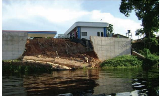
**Figura 7.32** - Desabamento do muro de um posto de gasolina na orla da cidade de Barcelos (AM).
