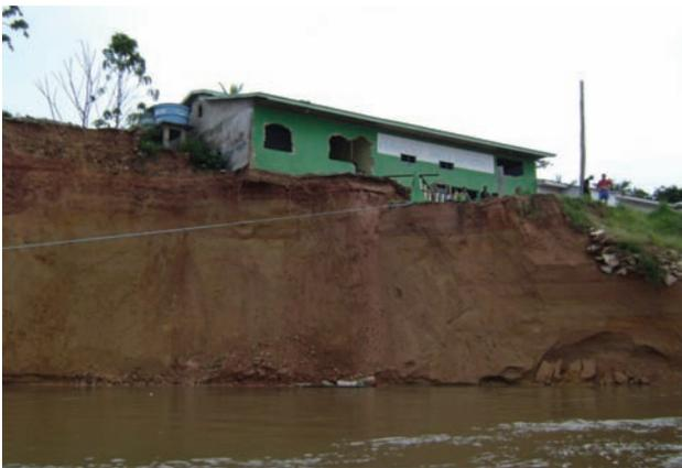
**Figura 7.31** - Vista frontal de talude subvertical do rio Solimões, na orla de Jutai, que sofreu ruptura planar (“terras caídas”), afetando as fundações do prédio de um frigorífico. Fonte: CPRM (2009).
