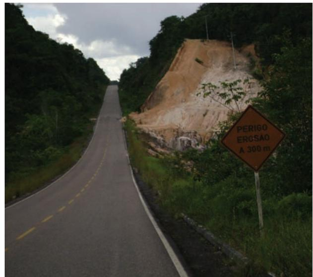
**Figura 13.30a** - Risco geológico: processos de voçorocamentos e ravinamentos em corte da rodovia BR-174 (Presidente Figueiredo, AM).
