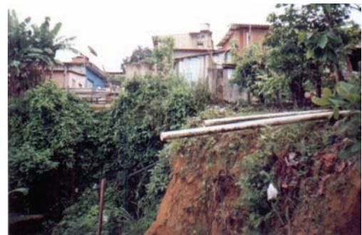
**Figura 7.16** - Lançamento de águas servidas diretamente em encosta íngreme, contribuindo para sua destabilização (São Raimundo, Manaus, AM).
