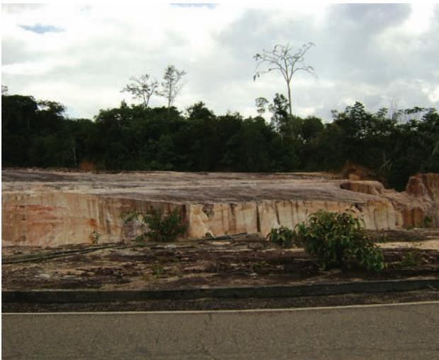
**Figura 7.20** - Voçoroca com forma linear que ocorre paralelamente ao traçado da rodovia BR-174, entre as cidades de Manaus e Presidente Figueiredo (AM).
