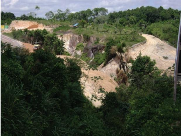
**Figura 7.22** - Vista geral do desmoronamento de parte da pista da rodovia BR-174 (km 14), em função do avanço de uma voçoroca.
