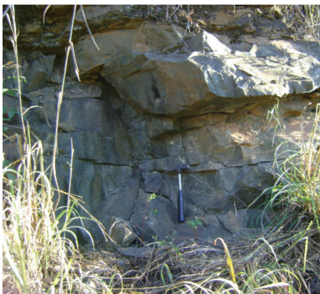
Figura 4.22 - Taludes de corte com exposição de litotipo muito fraturado, com elevado potencial de queda de blocos, detalhe de talude em maciço pouco alterado (município de Prata).
