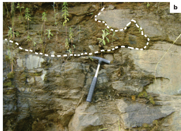
Figura 4.94 - Surgência de água ao longo de discontinuidades geomecânicas em maciços da unidade geológico-ambiental 62 no município de Ponte Nova. (a) talude de corte com surgência de água ao longo de bandamento migmatítico; (b) área úmida com surgência de água ao longo do plano de fratura – formação de zona de alteração intempérica (área pontilhada).
