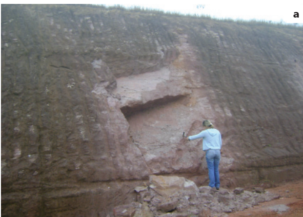
Figura 4.39 - Exemplos de movimento de massa em litologias finamente laminadas. (a) deslocamento de material medianamente alterado, com formação de cunhas paralelas ao mergulho de face do talude (município de Sacramento); (b) movimento de massa por rastejo (município de Belo Oriente).
