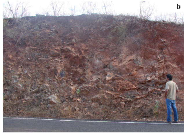
Figura 4.92 - Heterogeneidade geomecânica devido à deformação estrutural característica desse domínio. (a) talude em maciço da unidade geológico-ambiental 56 (município de Poços de Caldas); (b) talude em maciço da unidade geológico-ambiental 62 (município de Porteirinha).
