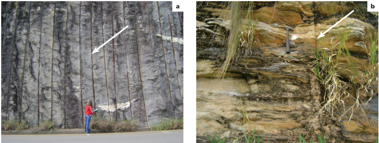
Figura 4.67 - Litotipos da unidade geológico-ambiental 37, com elevada resistência ao corte. Notar presença de meias-canas no maciço, feição indicativa do uso de explosivos para desmonte. (a) município de Piranga; (b) município de Tiradentes.
