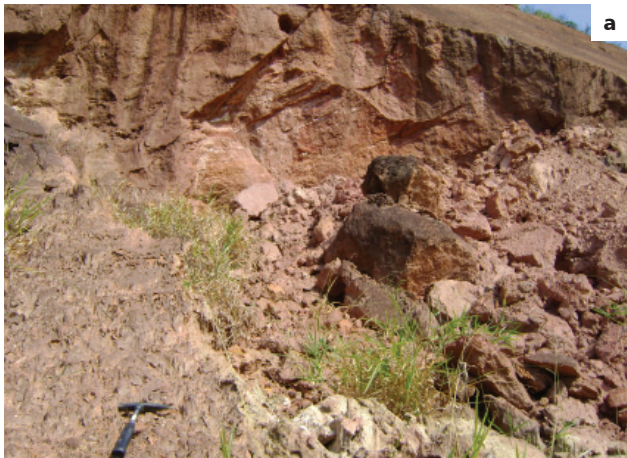
Figura 4.93 - Taludes de corte em maciços alterados e muito fraturados, com ocorrências de queda de blocos, na unidade geológico-ambiental 62. (a) município de Rio Casca; (b) município de Virginópolis.
