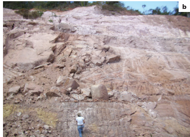
Figura 4.93 - Taludes de corte em maciços alterados e muito fraturados, com ocorrências de queda de blocos, na unidade geológico-ambiental 62. (a) município de Rio Casca; (b) município de Virginópolis.
