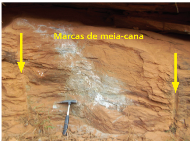
Figura 4.51 - Quartzito resistente ao corte e à penetração; as setas mostram locais com marcas de meia-cana, indicativo do uso de explosivos (município de Itamarandiba).
