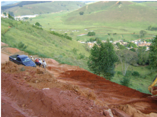
Figura 4.86 - Deslizamento de encosta em granitoide alterado da unidade geológico-ambiental 51, com utilização de maquinário para retirada de terra que interditou a pista (município de Matipó).
