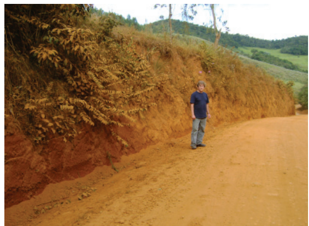
Figura 4.72 - Talude em corte de estrada. Mostra a boa estabilização em solo bem evoluído (unidade geológico-ambiental 42) (município de Catas Altas da Noruega).
