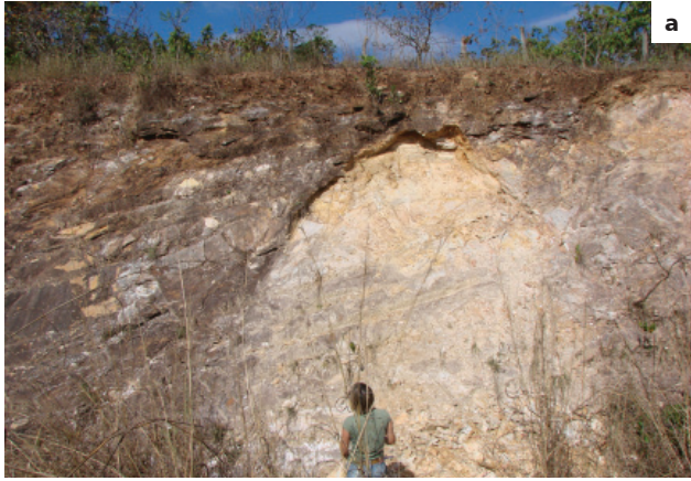
Figura 4.40 - Exemplos de movimento de massa e queda de blocos em litologias com mergulho da xistosidade concordante ao mergulho da face do talude. (a) escorregamento planar em talude de corte de material levemente alterado (município de Guarda-Mor); (b) queda de blocos em talude de metapelitos (município de Lagamar).
