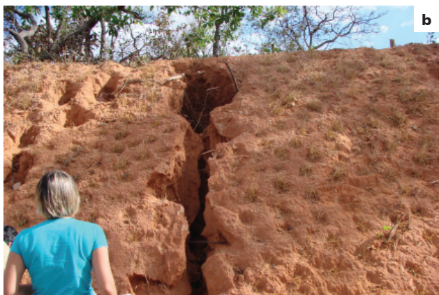
Figura 4.15 - Talude de corte em manto de alteração arenoso. (a) vista geral do afloramento; (b) detalhe de feição erosiva gerada por processo de ravinamento (município de Bonito de Minas).
