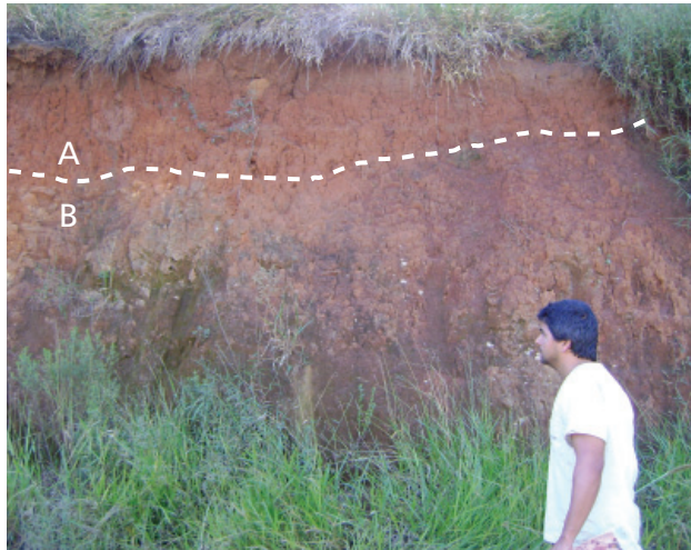
Figura 4.24 - Material de boa estabilidade, com baixo potencial à ocorrência de movimentos de massa e processos erosivos. (A) solo; (B) rocha muito alterada/saprólito (município de São Sebastião do Paraíso).
